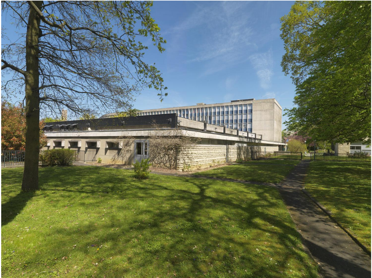
Vue générale du bâtiment bas, en rez-de-chaussée, des cuisines et du réfectoire, du côté sud du site, vers l'entrée.
