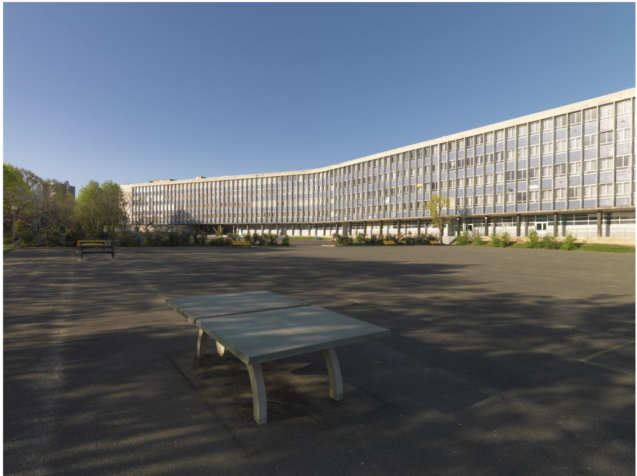
La barre incurvée du lycée, caractérisée par la répétition de la trame-standard de 1,75 m, vue depuis la cour.
