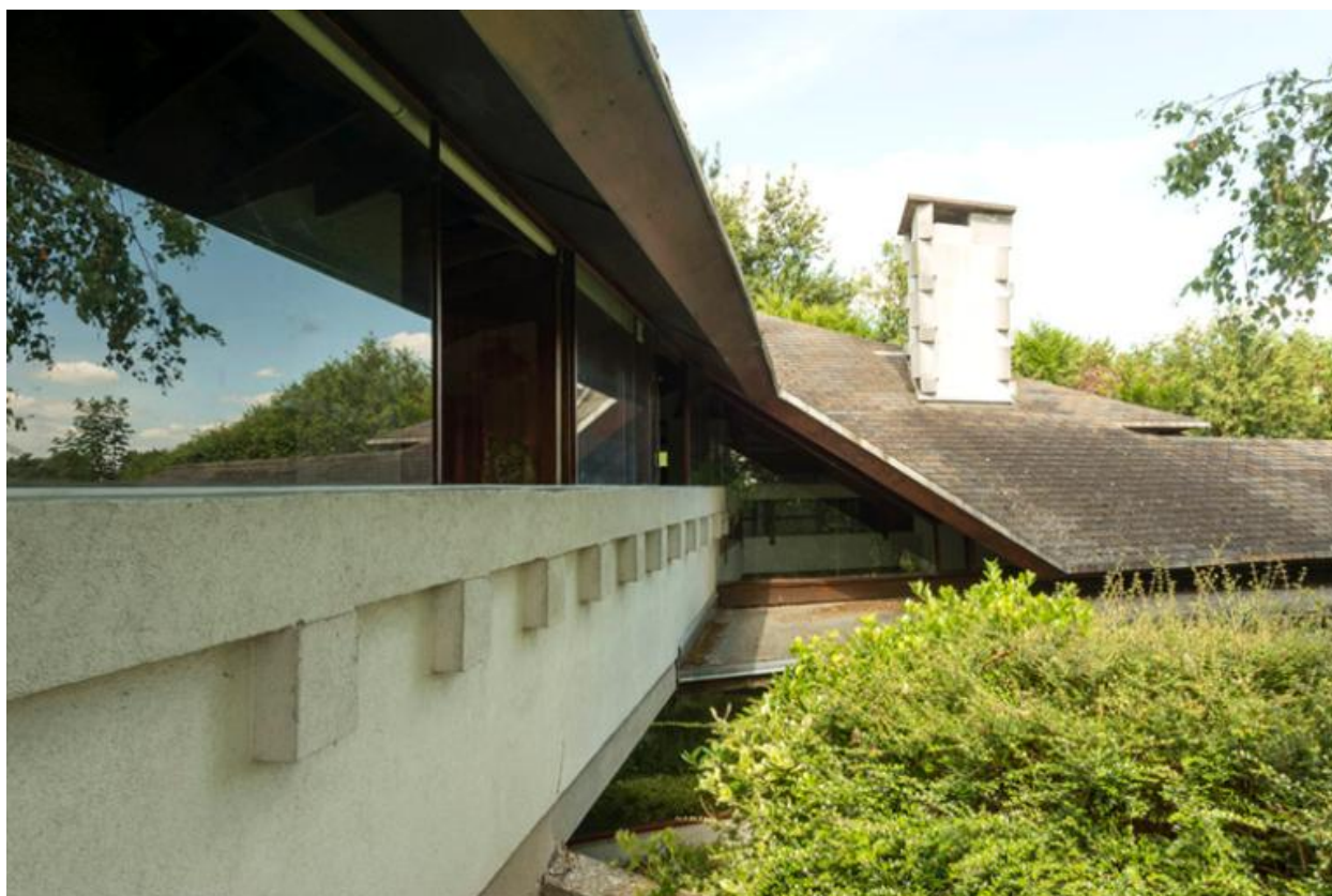
Vue prise depuis l'intérieur de la passerelle.
