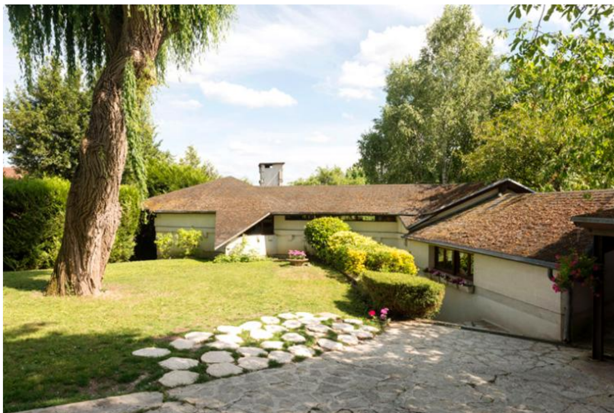
Vue générale de la façade postérieure.
