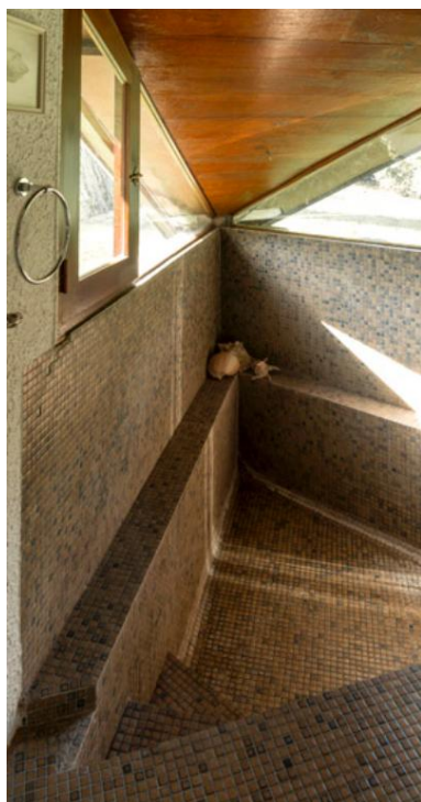
Vue de la salle de bains. Phot. Laurent Kruszyk IVR11_20179100094NUC4A
