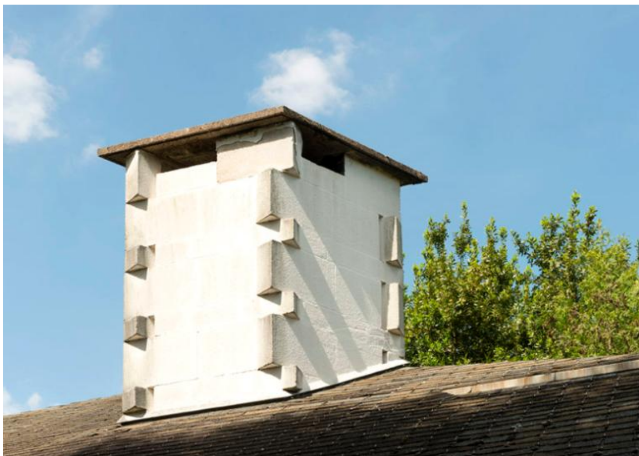
Vue de la cheminée.
