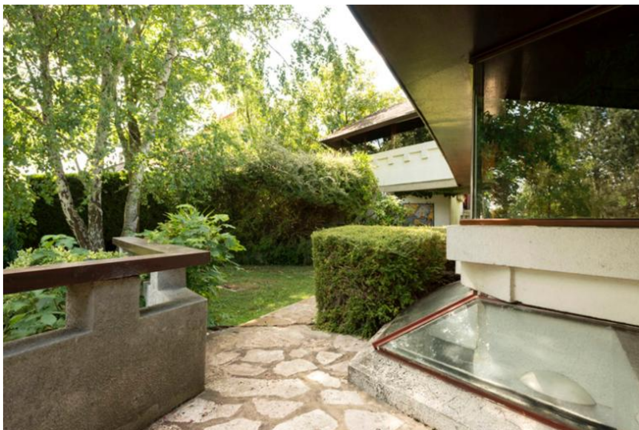
Vue des baies prise au niveau de la porte d'entrée.
