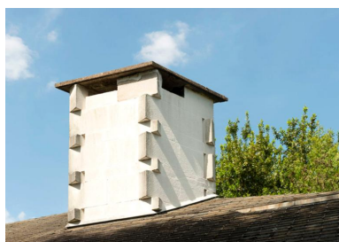
Vue de la cheminée. Phot. Laurent Kruszyk IVR11_20179100088NUC4A
