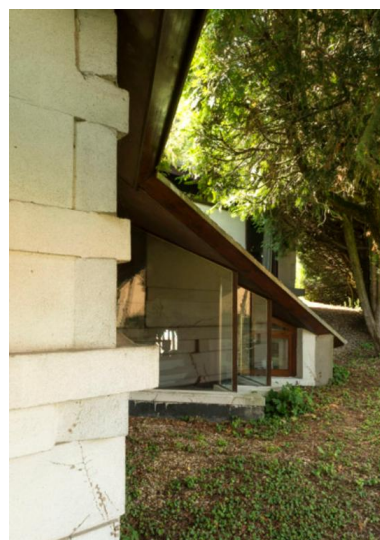
Vue de la façade latérale (côté droit). Phot. Laurent Kruszyk IVR11_20179100090NUC4A
