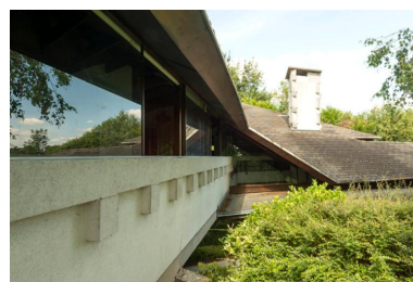
Vue prise depuis l'intérieur de la passerelle. Phot. Laurent Kruszyk IVR11_20179100087NUC4A
