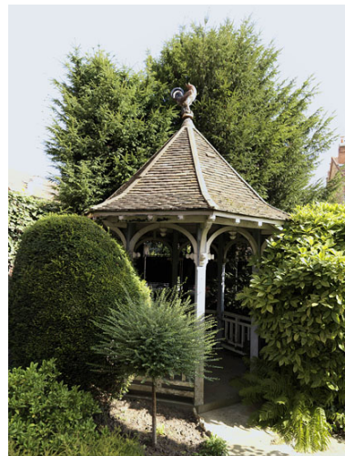
Vue d'ensemble du kiosque situé dans le jardin, à l'angle vers la rue. Phot. Jean-Bernard Vialles IVR11_20089500498NUC4A
