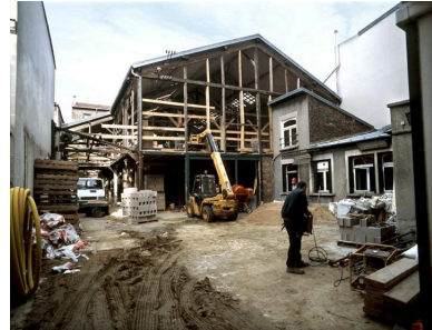
Halle en cours de reconversion (printemps 2005). Cette construction à pans de bois établie en fond de parcelle avant 1910, devenue la plus ancienne de la commune depuis la démolition de l'usine de bonneterie Chantalou en décembre 2005 (IA93000619), est désormais transformée en logements.
