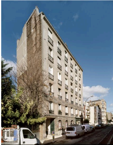
Un immeuble, construit vers 1900, masque sur la rue de Noisy-le-Sec l'atelier situé en fond de parcelle.
