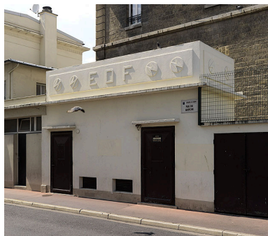
Vue du transformateur. Phot. Jean-Bernard Vialles IVR11_20089500376NUC4A
