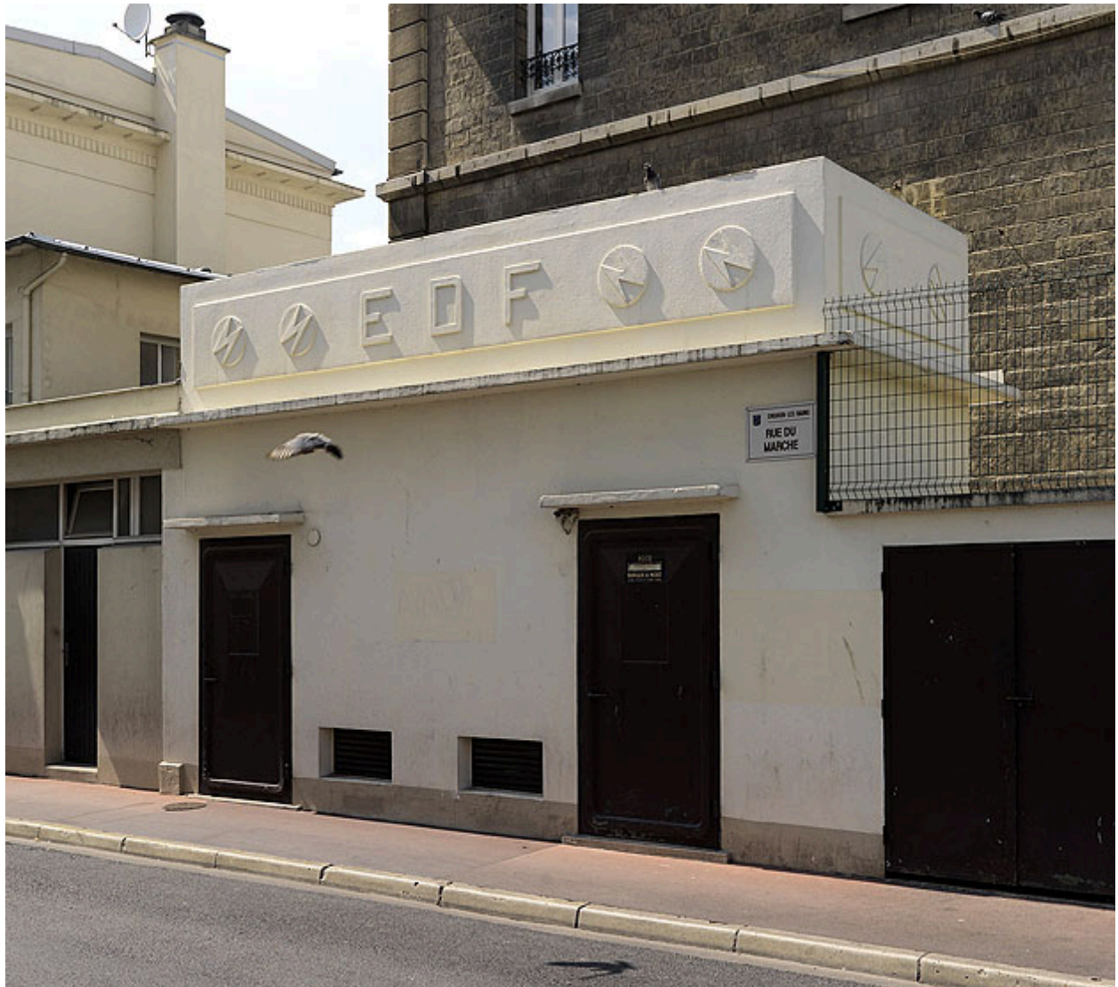
Vue du transformateur.
