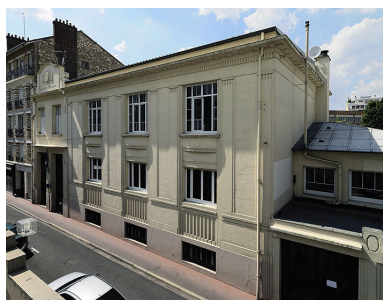
Vue d'ensemble depuis la rue de l'édifice. Phot. Jean-Bernard Vialles IVR11_20089500373NUC4A
