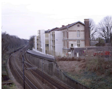
Vue du bâtiment inaugurée en 1899 depuis les voies de chemin de fer bordant le haut de la parcelle. Phot. Stéphane Asseline IVR11_20079400211XA
