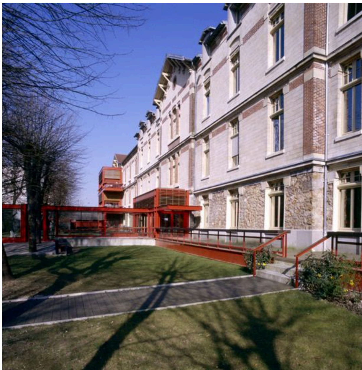
Vue rapprochée du bâtiment inaugurée en 1899.
