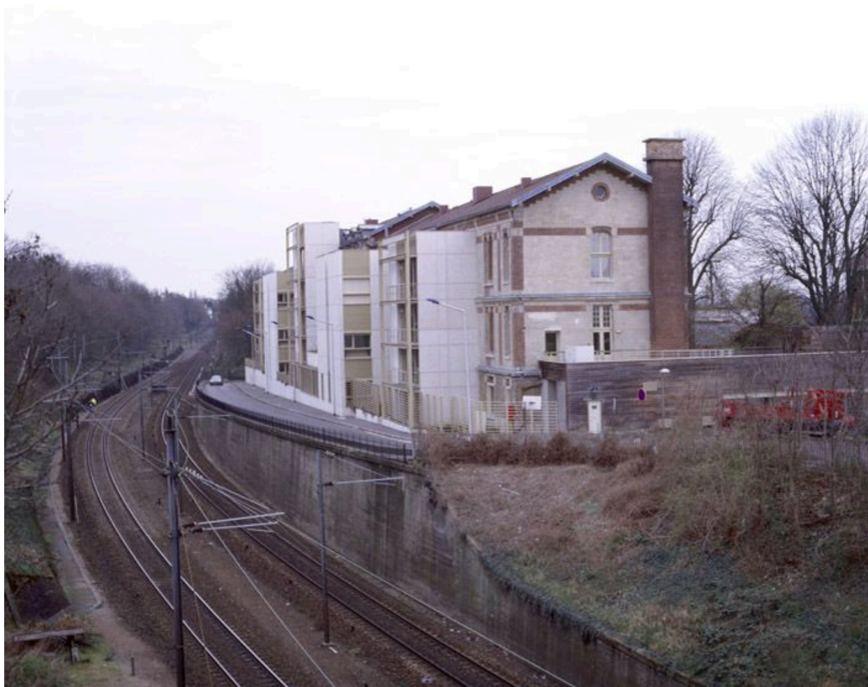
Vue du bâtiment inaugurée en 1899 depuis les voies de chemin de fer bordant le haut de la parcelle.
