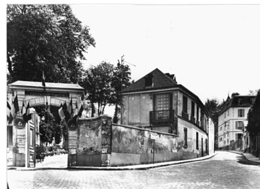
Entrée et commons du manoir aménagés en hospice. Carte postale. (Soc. hist. de Villiers-sur-Marne et de la Brie française) Autr. Louis Rémy Sabattier IVR11_19849400690XB
