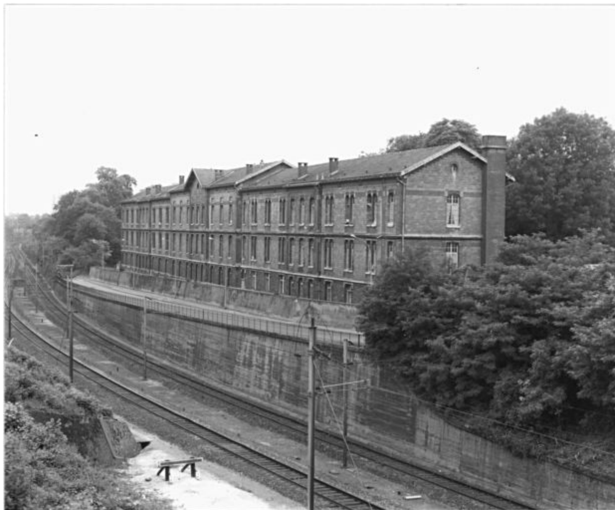
Bâtiment construit en 1898 vu du nord-est.
