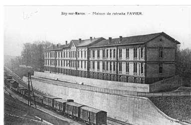
Bâtiment construit en 1898 vu du nord-est. Carte postale. (AD Val-de-Marne) Autr. Louis Rémy Sabattier IVR11_19849401540XB
