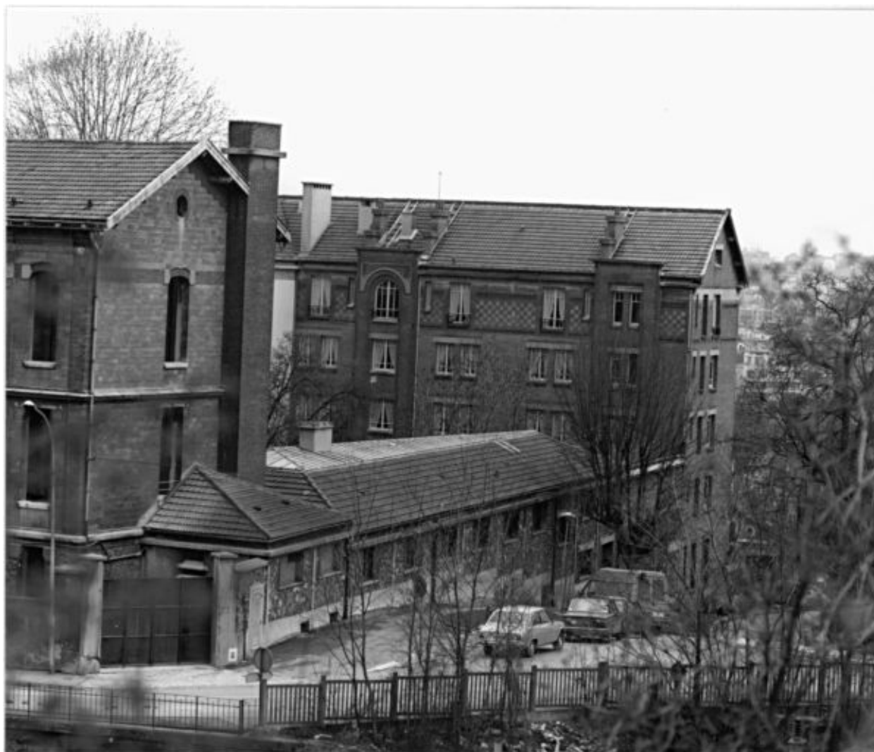
Un des bâtiments de l'hospice vu du nord-est.
