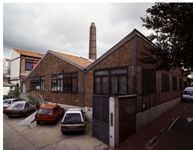
Vue des ateliers depuis la rue Paul Eluard. Phot. Jean-Bernard Vialles IVR11_20019300337XA
