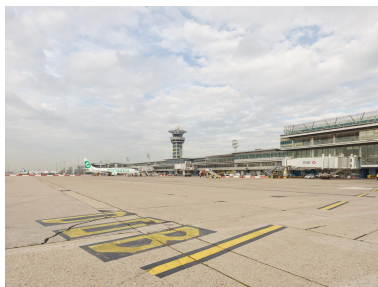
2018, le chantier d'Orly 3, la jetée ouest et la tour de contrôle vues depuis le sud est. Phot. Stéphane Asseline IVR11_20209400289NUC6A
