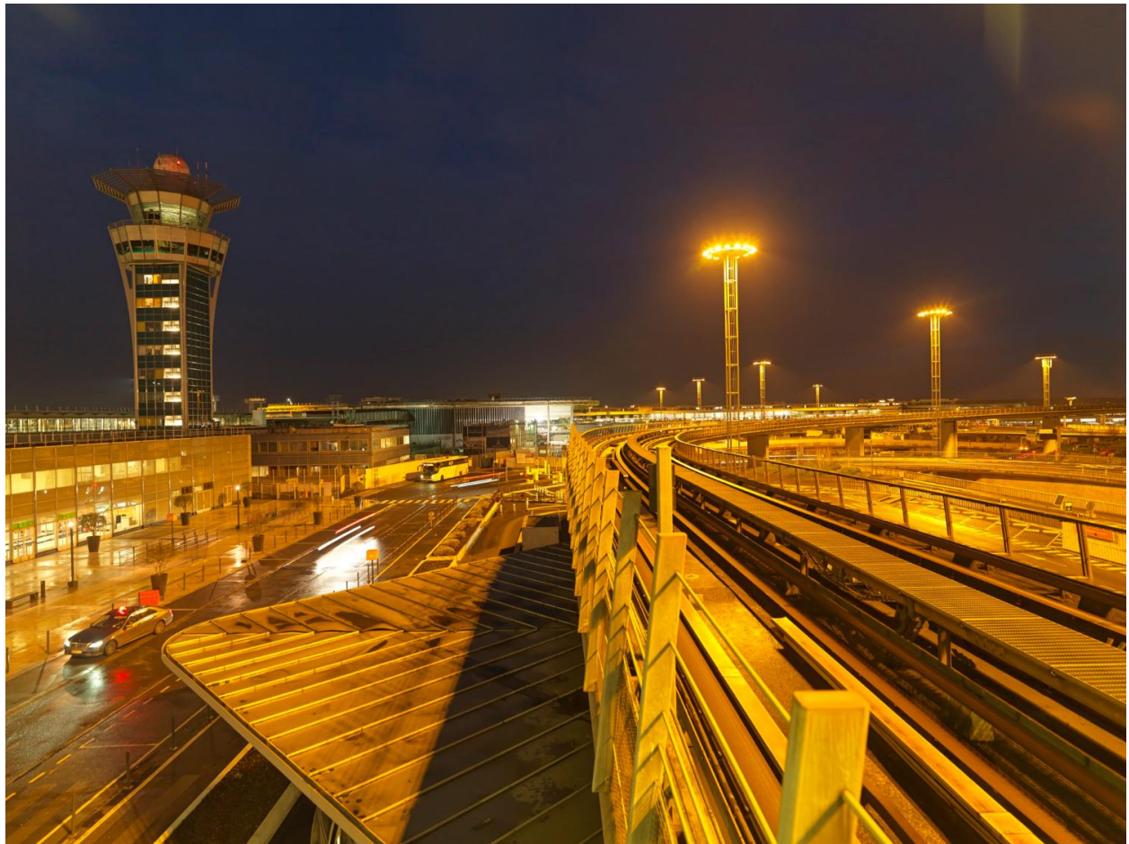
2018, la tour de contrôle et le chantier de construction d'Orly 3, vus depuis la passerelle d'accès ouest à la station d'Orlyval Orly-Sud, vue prise depuis l'est.
