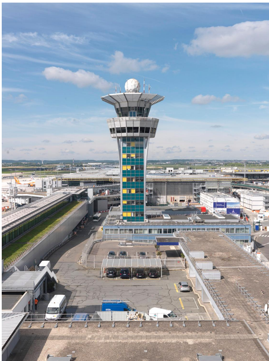
2018, la jetée ouest, le satellite ouest, la tour de contrôle et le chantier de construction d'Orly 3, vus des terrasses d'Orly-Sud, vue prise depuis l'est.
