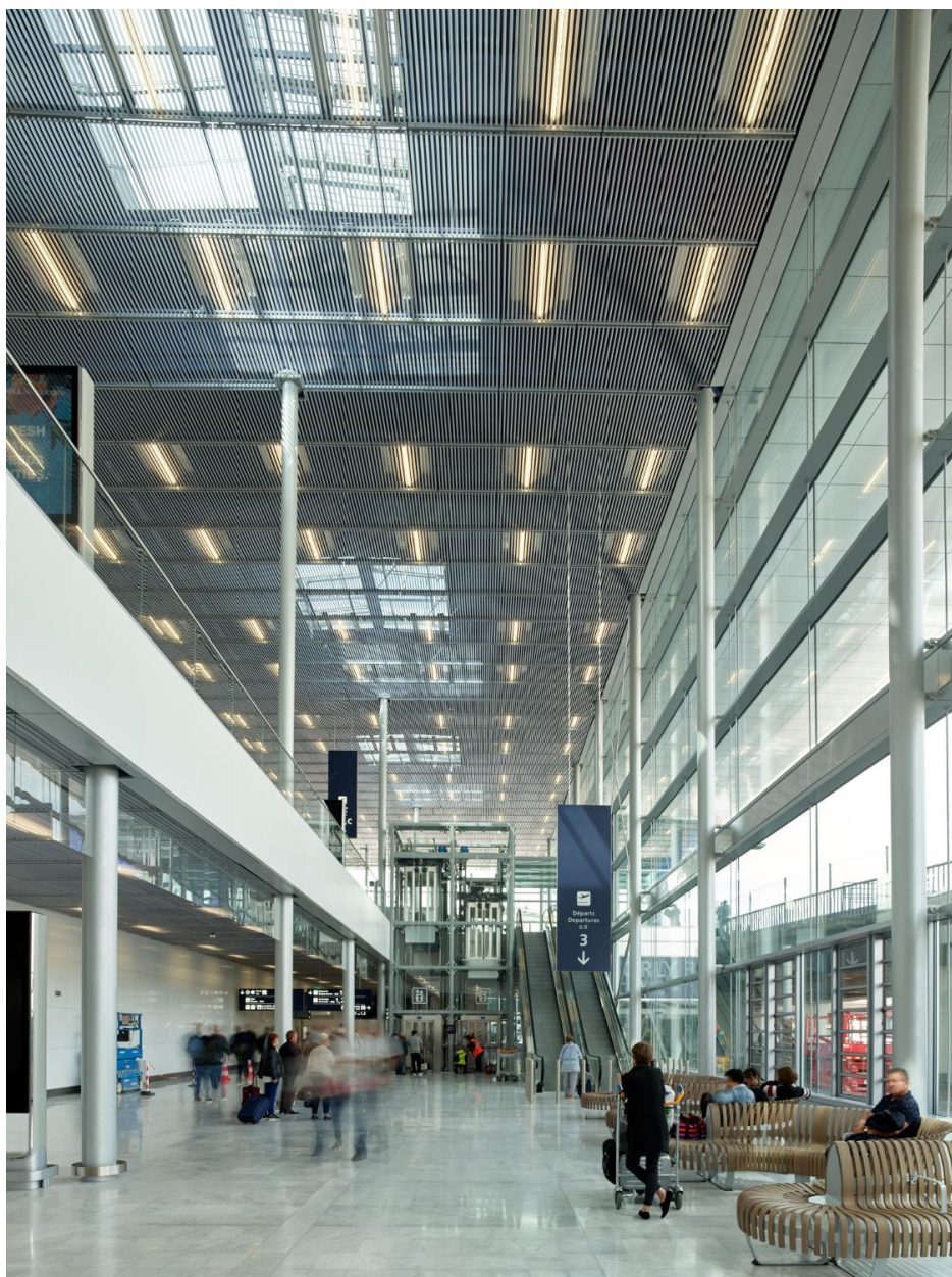
2019, Orly 3, hall arrivées au niveau 0.
