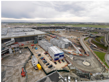
2018, le chantier d'Orly 3 et Orly-Ouest vus depuis la tour de contrôle, vue prise depuis l'est. Autr. François Tamisier IVR11_20209400138NUC4A
