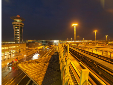
2018, la tour de contrôle et le chantier de construction d'Orly 3, vus depuis la passerelle d'accès ouest à la station d'Orlyval Orly-Sud, vue prise depuis l'est. Phot. Stéphane Asseline IVR11_20209400250NUC4A
