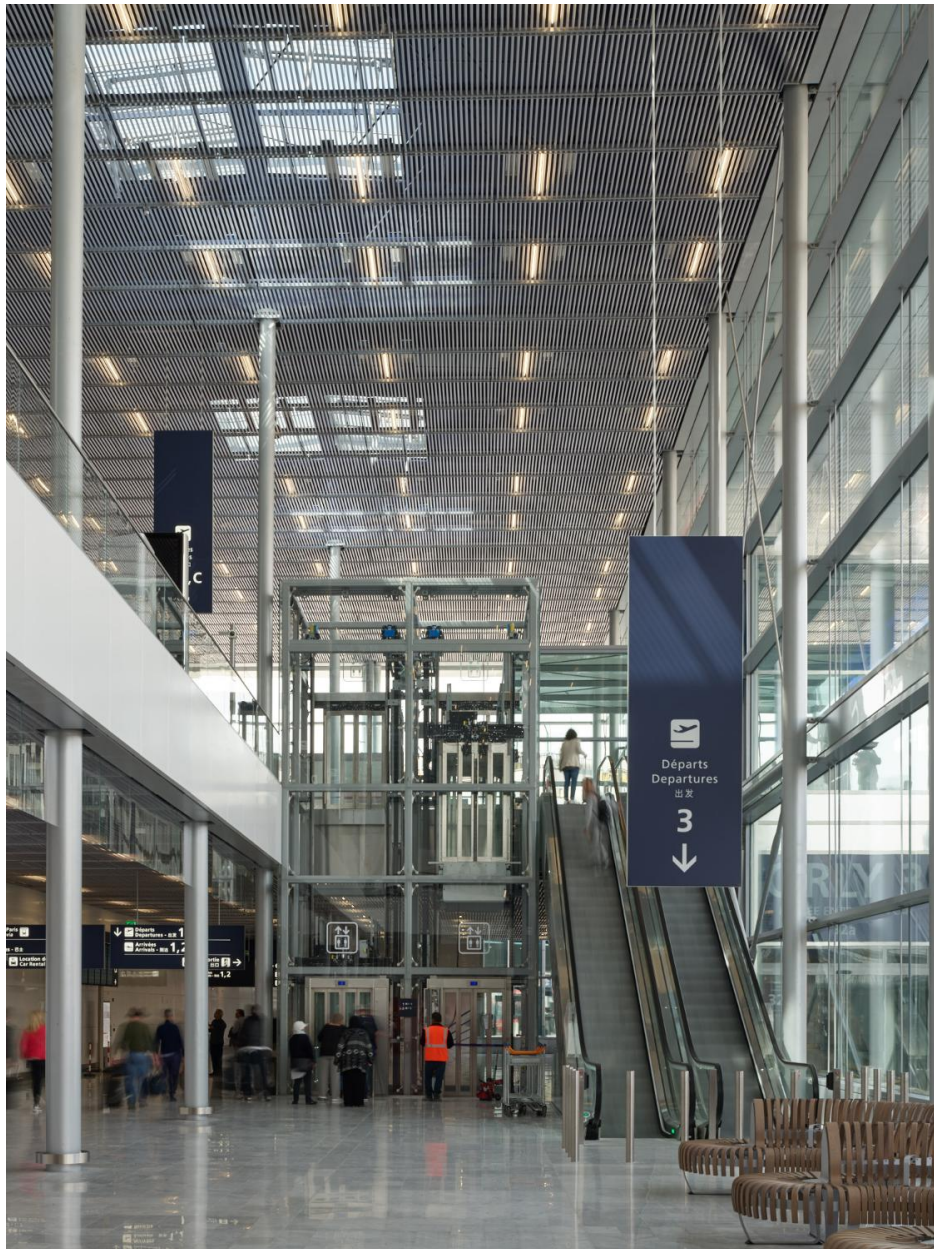
2019, Orly 3, hall arrivées au niveau 0.
