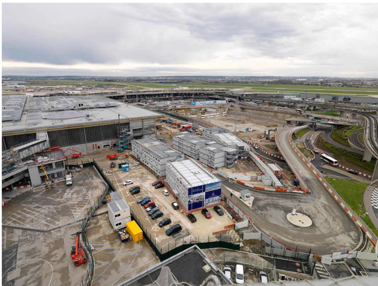
2018, le chantier d'Orly 3 et Orly-Ouest vus depuis la tour de contrôle, vue prise depuis l'est.
