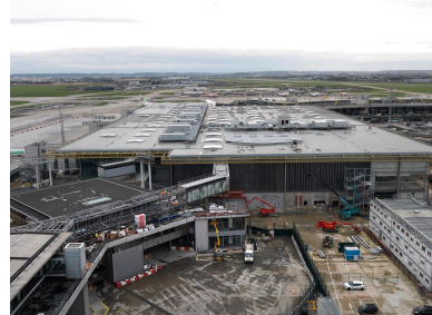
2018, le chantier d'Orly 3 vu depuis la tour de contrôle, vue prise depuis l'est. Phot. Stéphane Asseline IVR11_20209400140NUC4A
