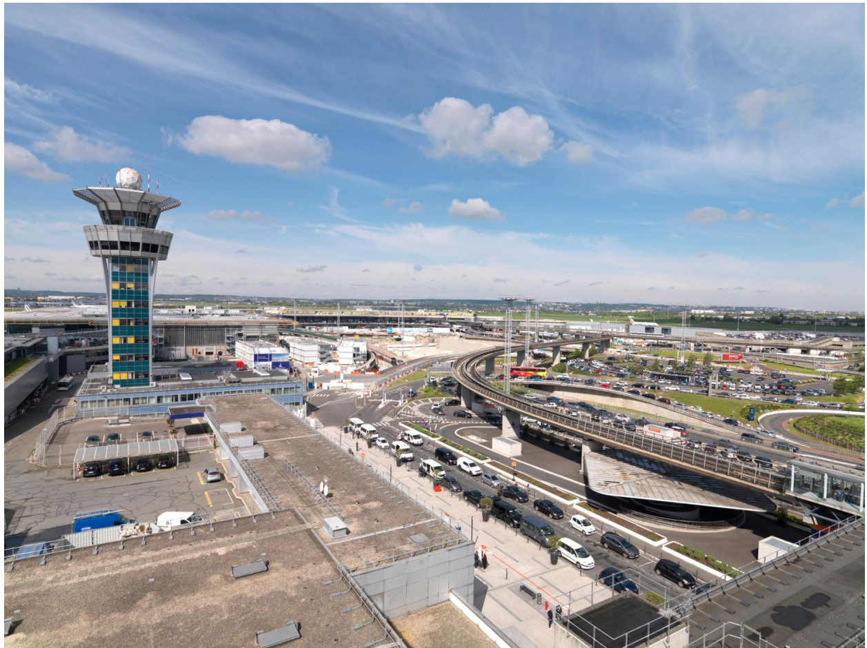
2018, la tour de contrôle, le chantier de construction d'Orly 3 et Orly-Ouest, vus des terrasses d'Orly-Sud, vue prise depuis l'est.
