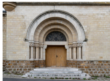
Détail du portail de l'église.
