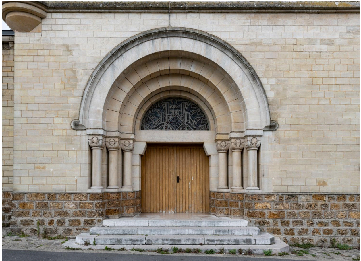
Détail du portail de l'église.
