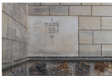
Date de pose de la première pierre. Phot. Laurent Kruszyk IVR11_20229500432NUC4A
