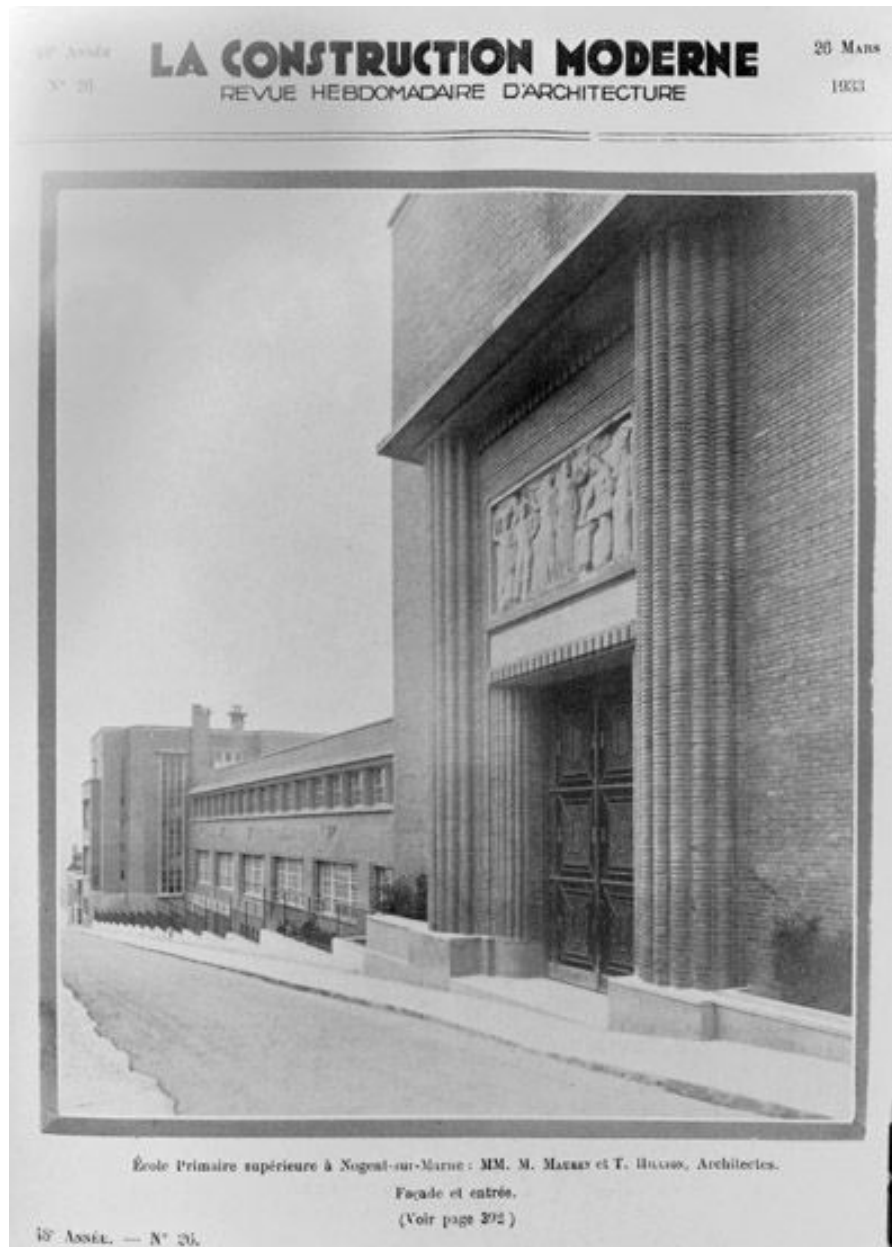
Façade antérieure et porte d'entrée avec bas-relief. Tiré de : La construction moderne, 1932-1933, t.1. (
