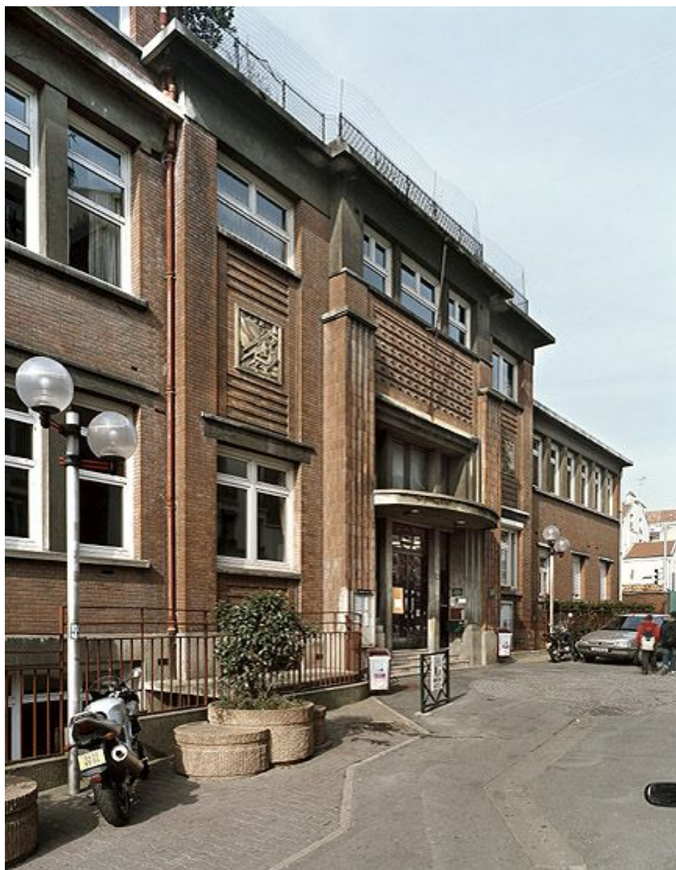
Vue d'ensemble de la façade.
