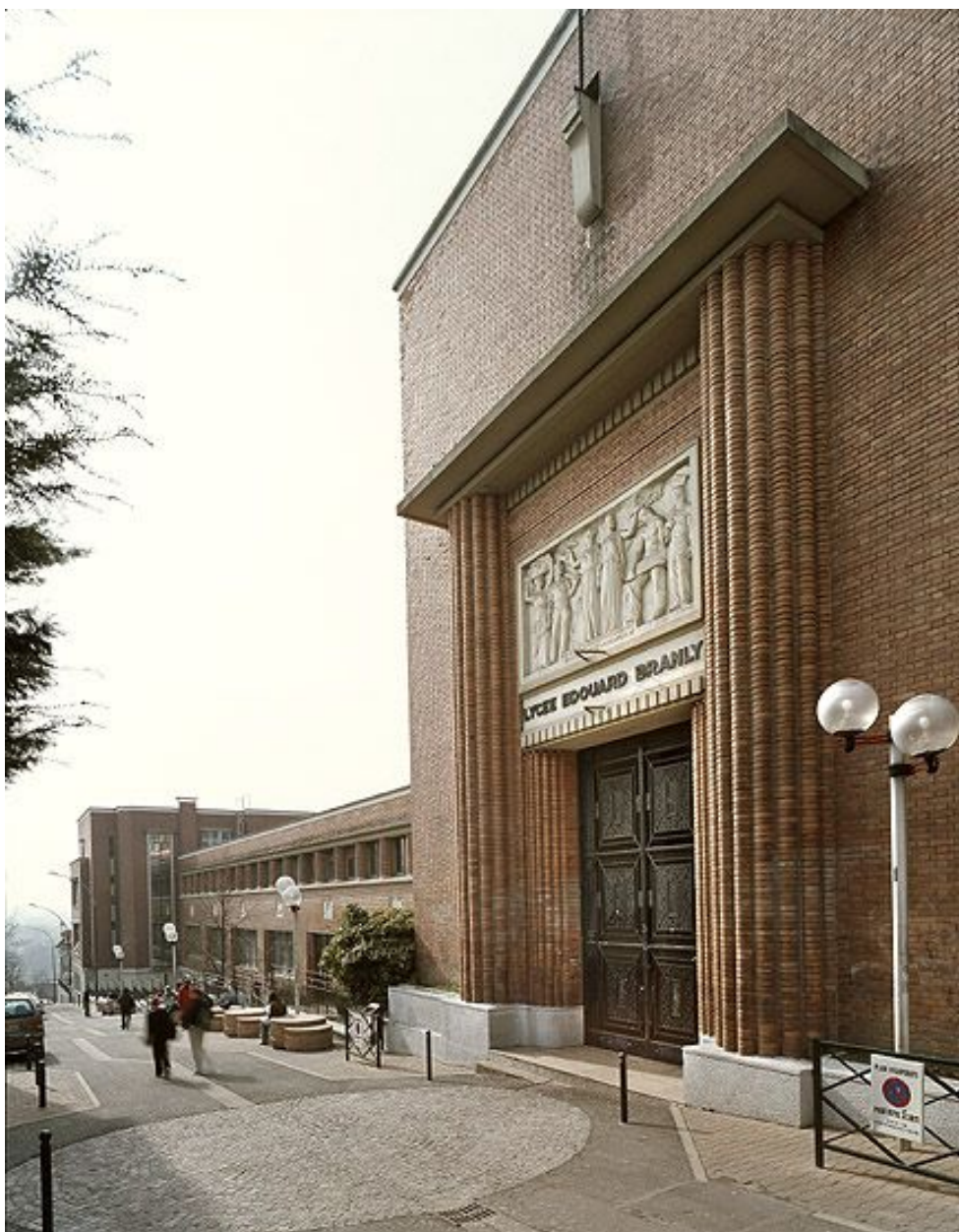
Vue d'ensemble de la porte d'entrée surmontée du bas-relief de Maurice Saulo.
