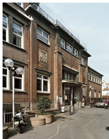
Vue d'ensemble de la façade.
