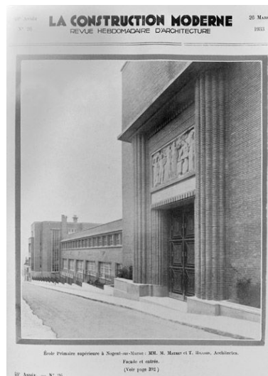
Façade antérieure et porte d'entrée avec bas-relief. Tiré de : La construction moderne, 1932-1933, t.1. ( IVR11_19849401131XB
