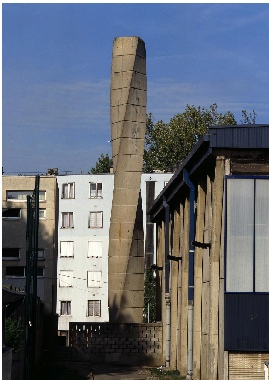
Elévation extérieure sud et cheminée
