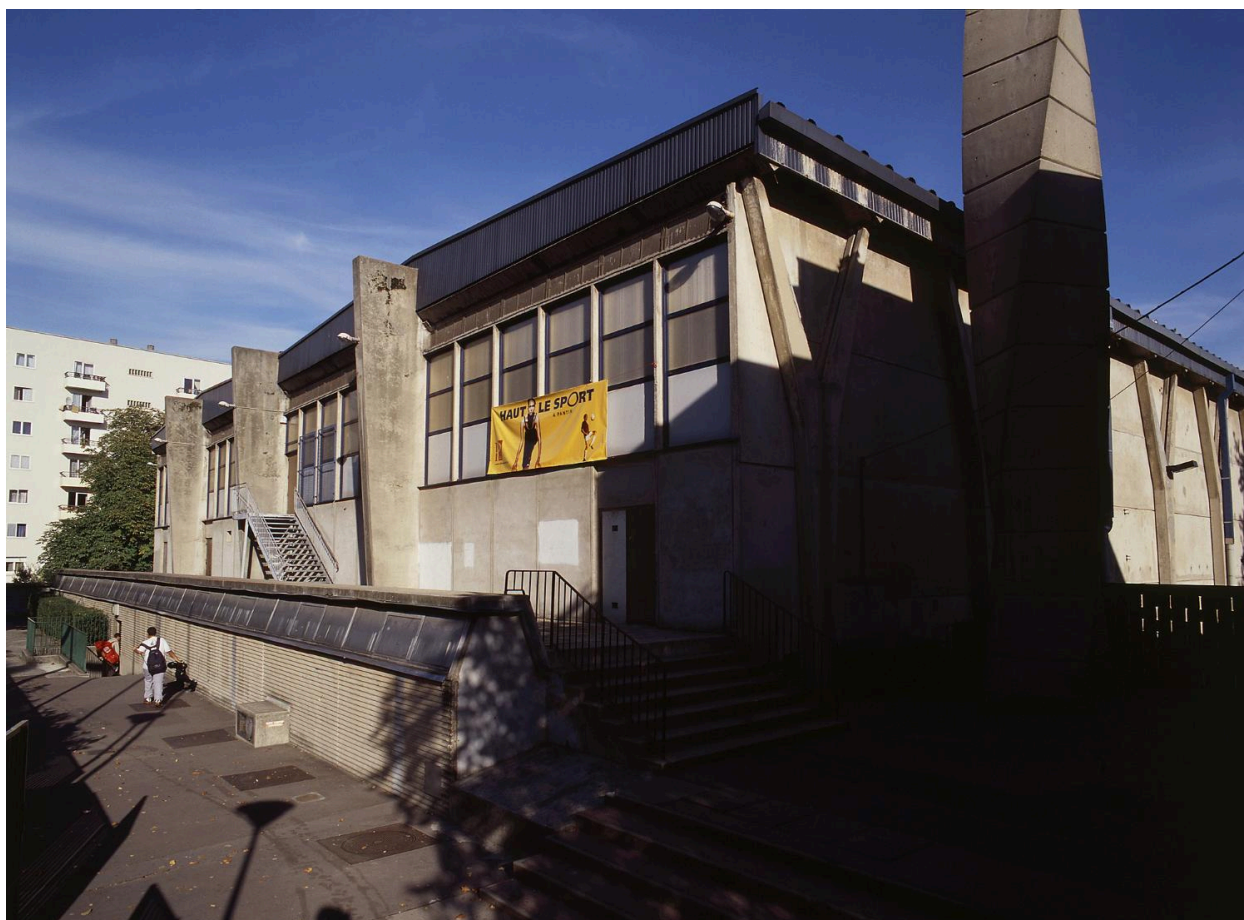
Elévation extérieure sud-ouest.
