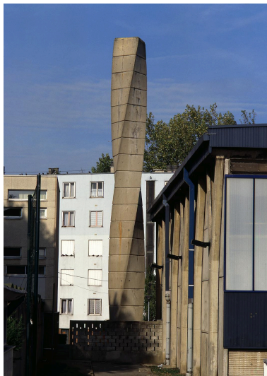
Elévation extérieure sud et cheminée Phot. Jean-Bernard Vialles IVR11_20029300361XA
