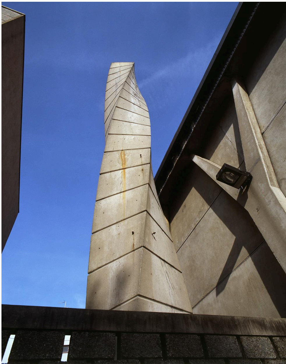
Détail de la cheminée
