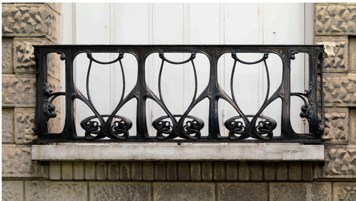
Vue de l'un des garde-corps d'une fenêtre, modèle d'Hector Guimard.
