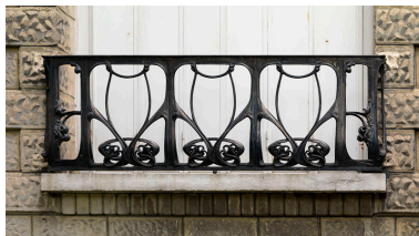
Vue de l'un des garde-corps d'une fenêtre, modèle d'Hector Guimard. Phot. Jean-Bernard Vialles IVR11_20099500645NUC4A
