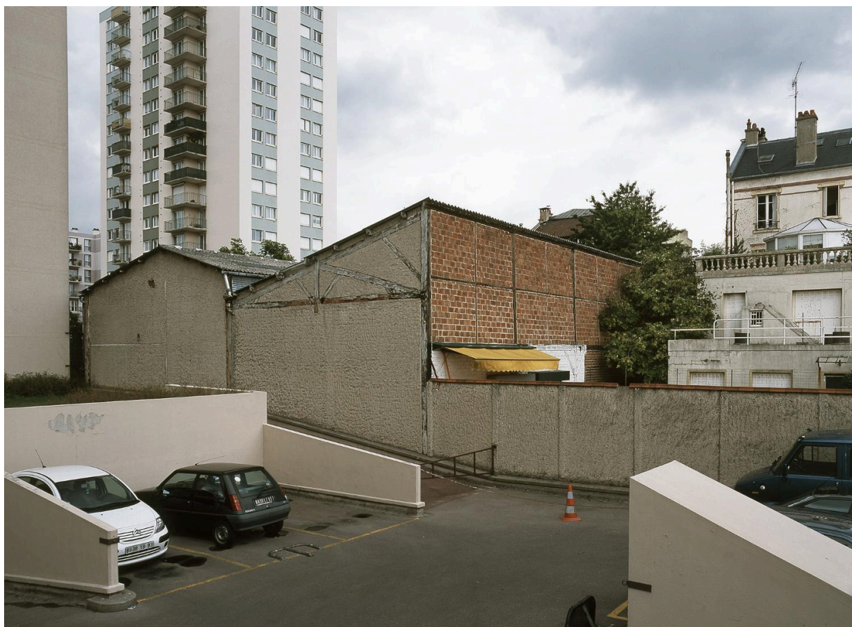
Le magasin (à droite) et l'atelier de fabrication (à gauche), vus depuis la rue de La Rochefoucault.
