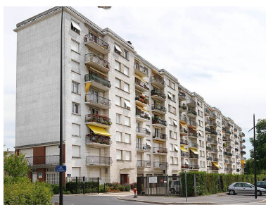
Résidence de l'Eglise", ensemble construit dans les années 1950-1960 à l'angle de l'avenue Henri Dunant et de la rue Sébastien de Brossard, face à l'église Saint-Jean-Bosco. Vue de la façade arrière, sur la rue Sébastien de Brossard, avec balcon en fer forgé et auvent. Phot. Stéphane Asseline IVR11_20097701105NUC4A
