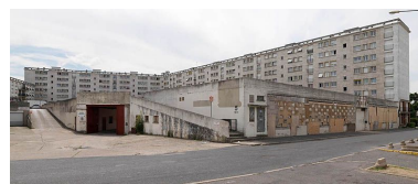
Résidence de l'Eglise", ensemble construit dans les années 1950-1960 à l'angle de l'avenue Henri Dunant et de la rue Sébastien de Brossard, face à l'église Saint-Jean-Bosco. Vue du côté ouest de la cour intérieure, et entrée des garages. Phot. Stéphane Asseline IVR11_20097701096NUC4A
