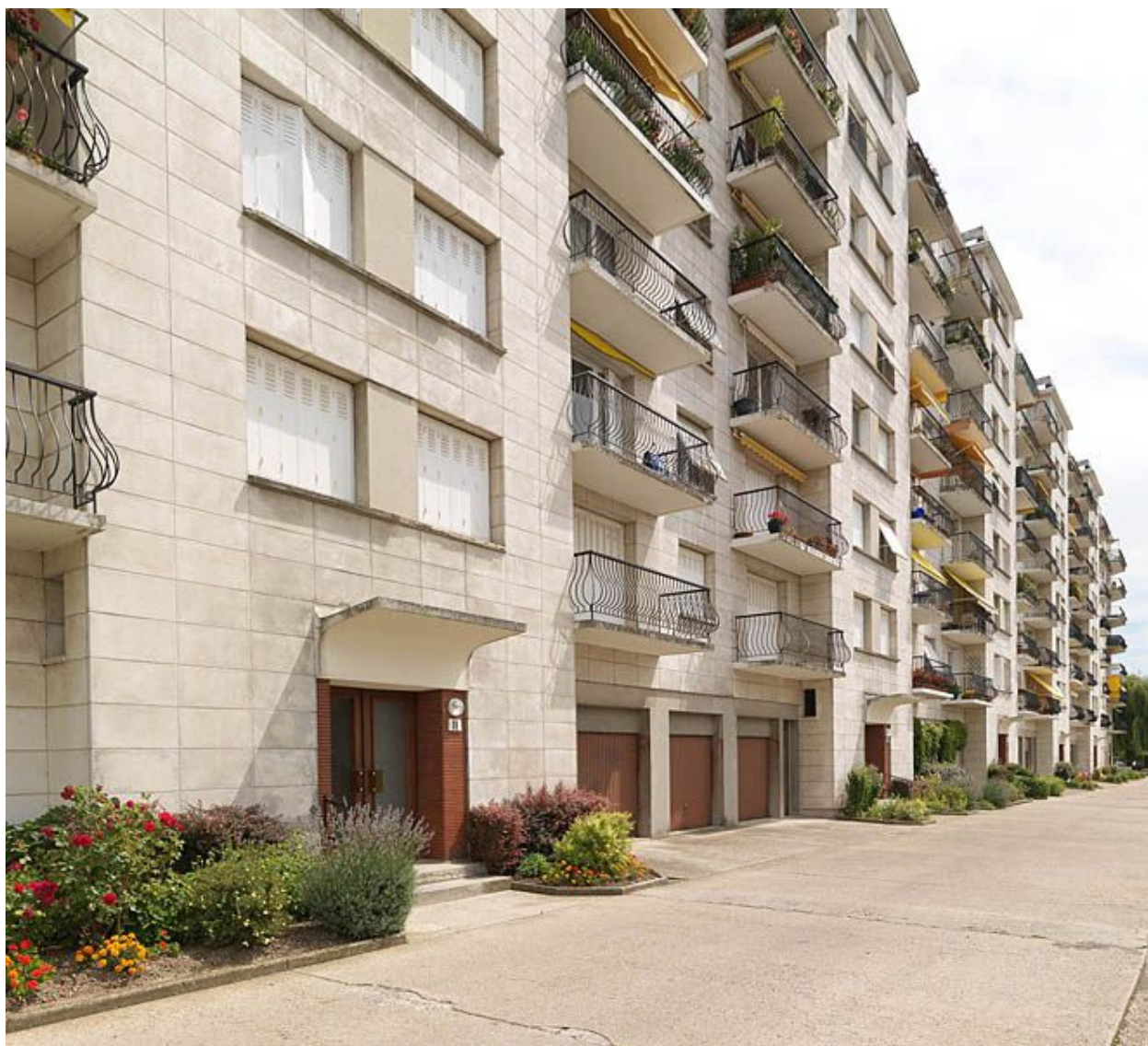
Résidence de l'Eglise", ensemble construit dans les années 1950-1960 à l'angle de l'avenue Henri Dunant et de la rue Sébastien de Brossard, face à l'église Saint-Jean-Bosco. Vue de la façade arrière, avec ses balcons en fonte.
