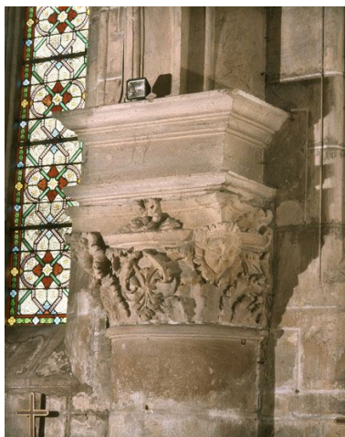
Vue d'ensemble du chapiteau (j). Phot. Laurent Kruszyk IVR11_20067800604XA
