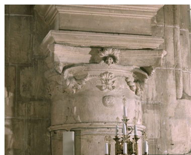
Vue d'ensemble du chapiteau (h). Phot. Laurent Kruszyk IVR11_20067800606XA
