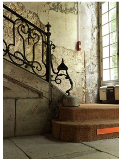
La très belle console de départ avec un amortissement pyramidal. Phot. Philippe Ayrault IVR11_20107500391NUC4A
