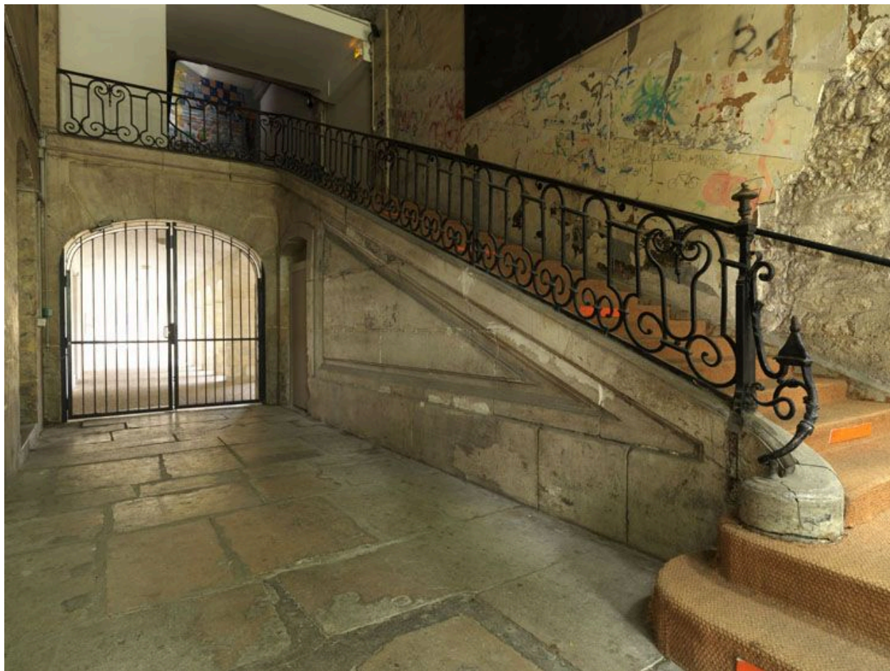
Vue d'ensemble de l'escalier.
