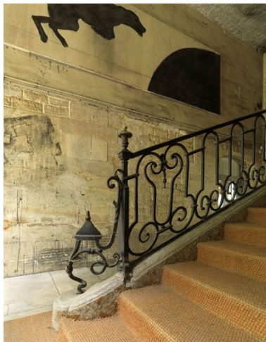
Le départ de l'escalier est soigné : console de départ et panneau de volutes affrontées. Phot. Philippe Ayrault IVR11_20107500390NUC4A
