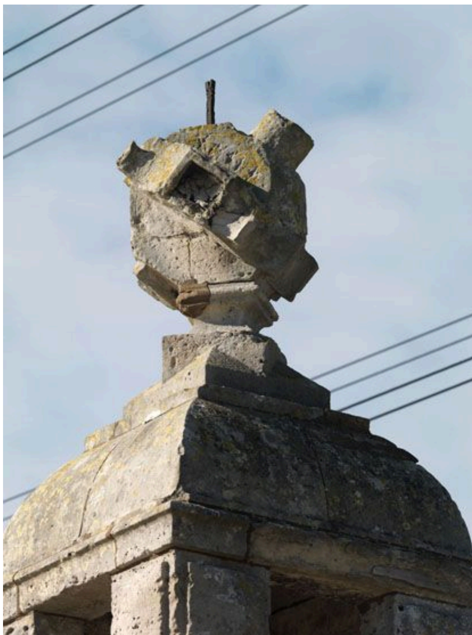
Fresnes, Chemin des Otages (rond-point du). Vue sur l'acrotère ou bloc gnomonique du regard III : angle nord-est.
