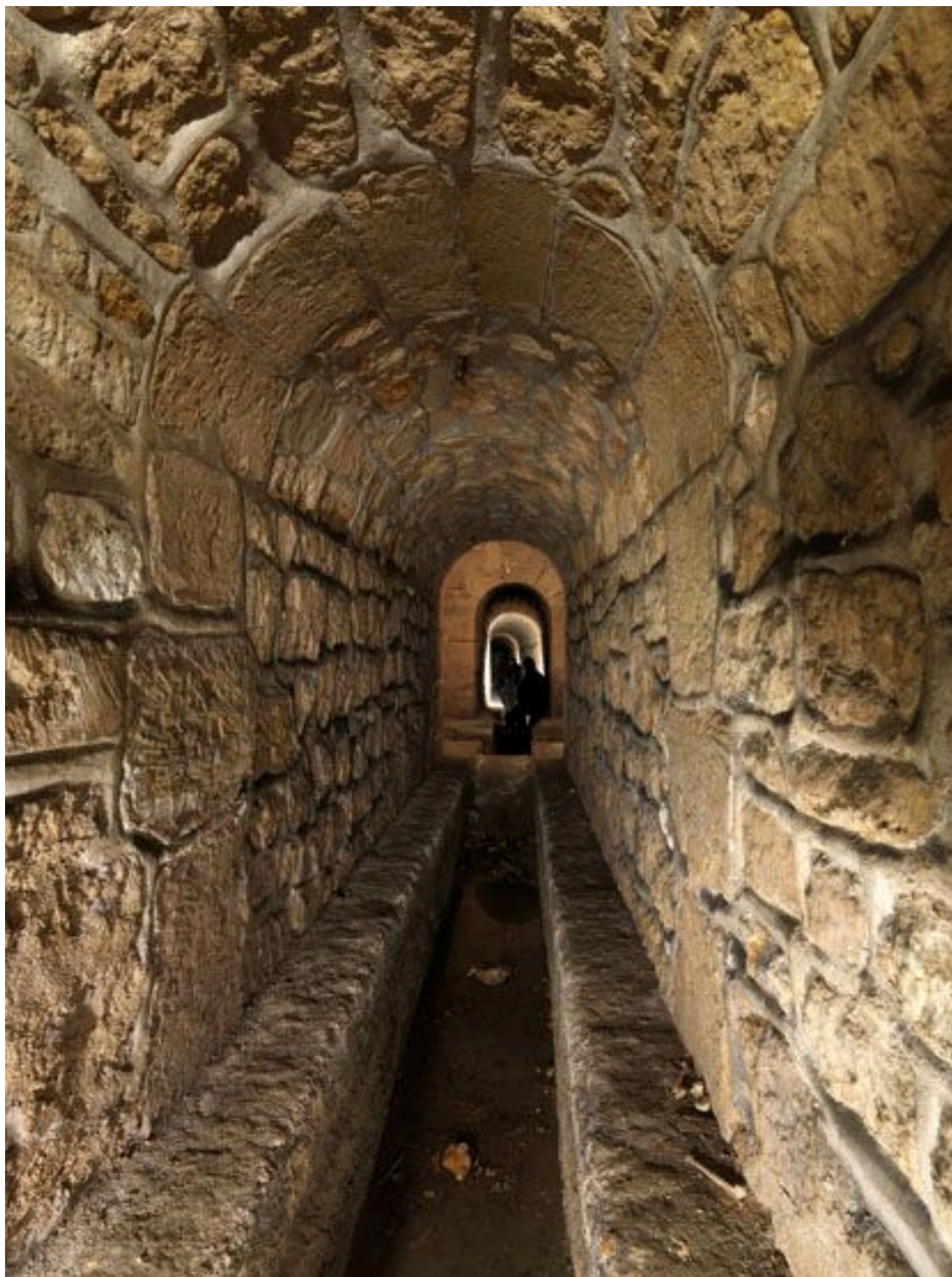
Paris 14e, René-Coty (avenue) 10. Galerie de l'aqueduc dans l'enceinte de l'hôpital de la Rochefoucauld.
