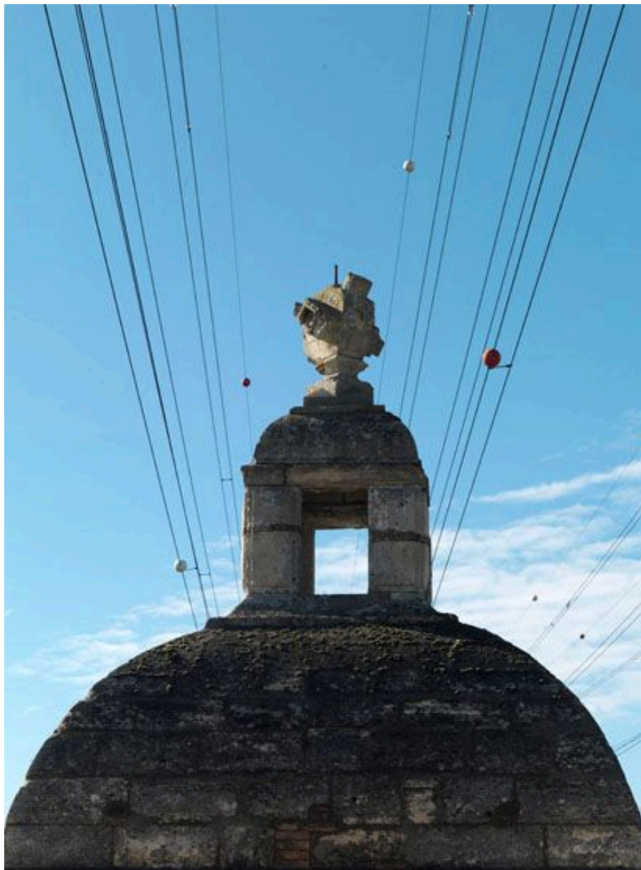
Fresnes, Chemin des Otages (rond-point du). Vue sur le regard III avec son lanterneau et acrotère : façade nord de l'édicule.
