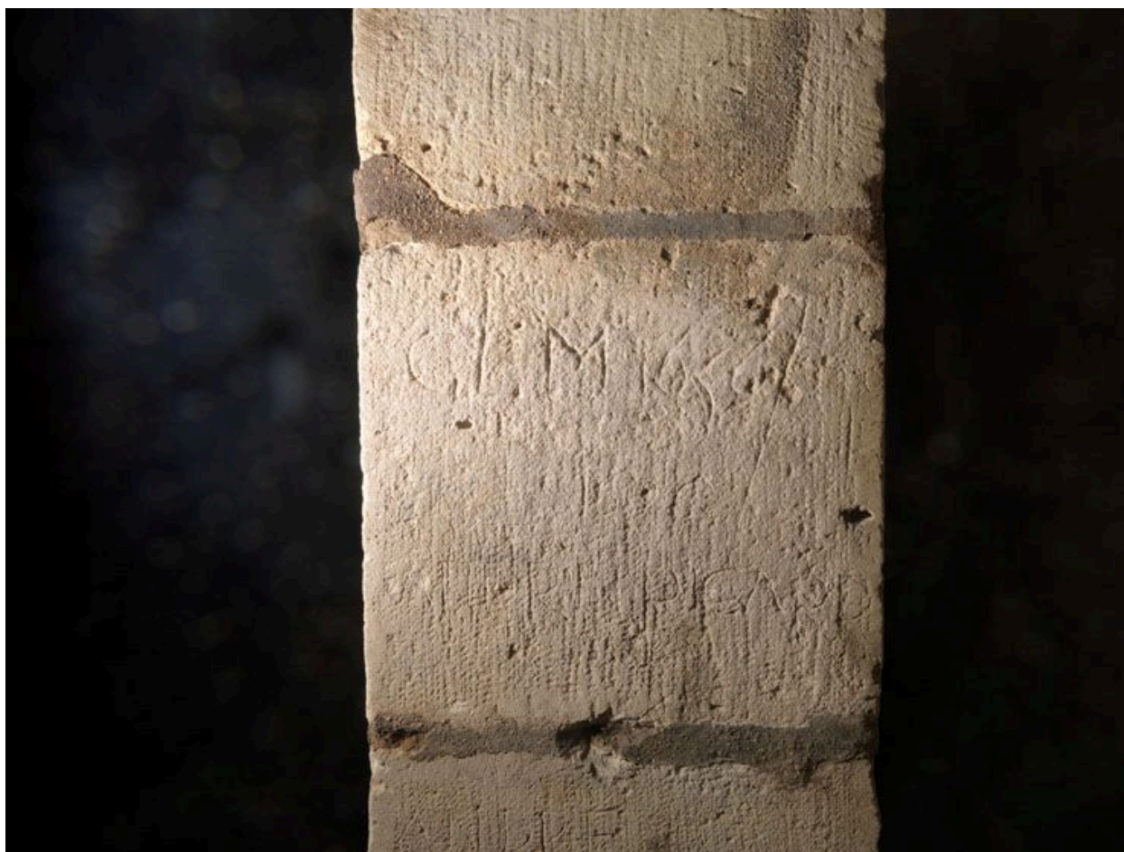
Fresnes, Chemin des Otages (rond-point du). Graffiti gravé sur un pillier du regard III.
