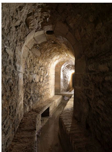
Rungis, Ecoliers (passage des). Banquettes de circulation aménagées dans la galerie amenant l'eau des sources dans le ""Carré des eaux"" à Rungis. Phot. Laurent Kruszyk IVR11_20129400120NUC4A
