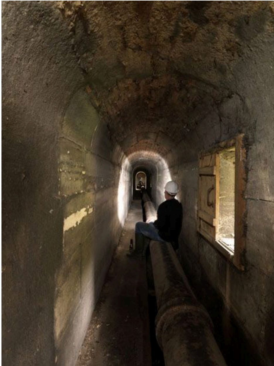
Arcueil. Vue de l'intérieur de la galerie du pont-aqueduc avec sa conduite forcée.
