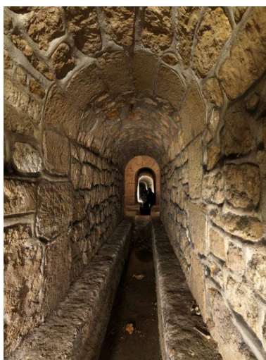
Paris 14e, René-Coty (avenue) 10. Galerie de l'aqueduc dans l'enceinte de l'hôpital de la Rochefoucauld. Phot. Laurent Kruszyk IVR11_20127501798NUC4A
