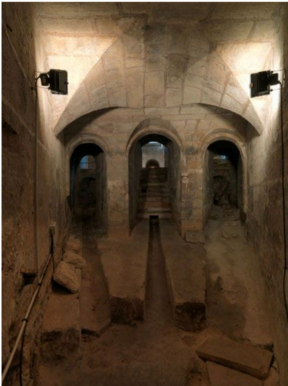
Paris 14e, Observatoire (avenue de l') 44. Maison du Fontainier : départ des trois conduites en patte-d'oie depuis les bassins dus sous-sol.
