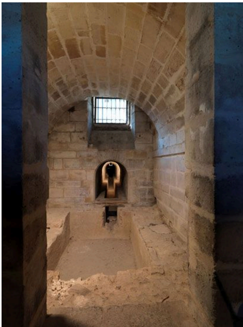
Paris 14e, Observatoire (avenue de l') 44. Maison du Fontainier : arrivée de l'aqueduc et bassin des entrepreneurs ou des Carmélites, dans le sous-sol de la maison.
