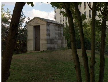
Paris 14e, Thomas-Francine (square). Regard XXIII dit de la "'ferme de la Santé'". Regard détruit puis reconstruit après les travaux de la ZAC-Alésia Montsouris en 1996. L'édicule en surface ayant disparu au 19e siècle, il s'agit ici d'une copie du XXV.
