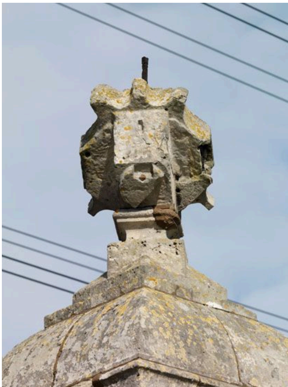
Fresnes, Chemin des Otages (rond-point du). Vue sur l'acrotère ou bloc gnomonique du regard III : angle sud-est.
