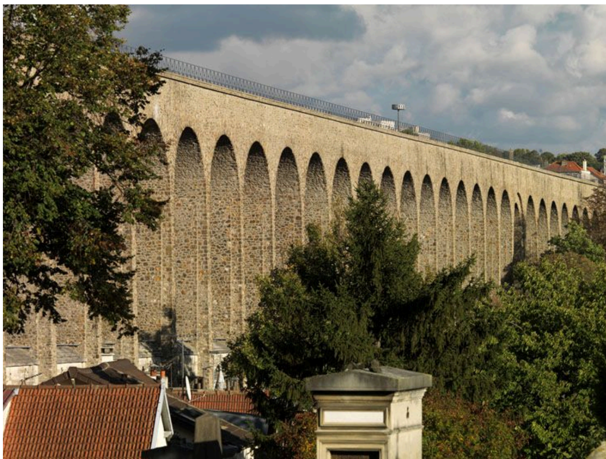
Arcueil. Vue sur le pont-aqueduc de la Vanne à Arcueil-Cachan.
