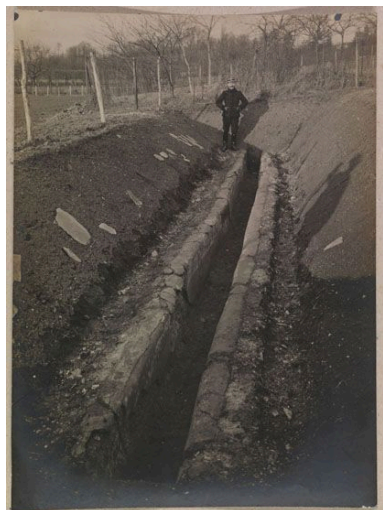
Haÿ-les-Roses (L'). Aqueduc romain. Photographie, 1907. (Archives de Paris) Phot. Laurent Kruszyk, Autr. Sarret IVR11_20129400269NUC4AB
