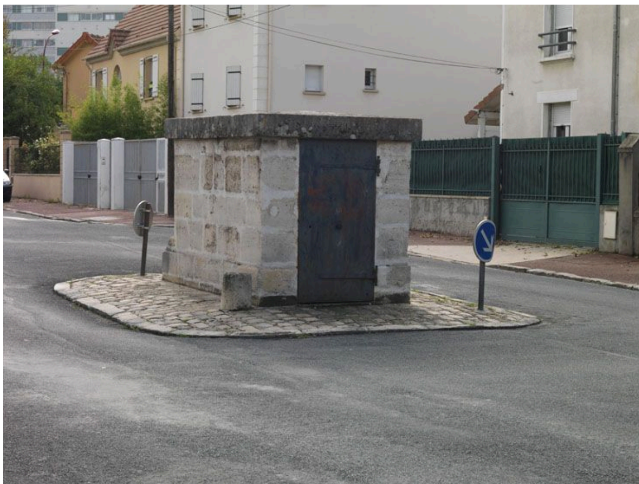
Fresnes, Regard (rue du) 17. Vue sur la façade nord et l'entrée du regard IV.
