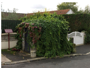
Haÿ-les-Roses (L'), Thuret (rue de) 20. Vue sur le regard VI. Phot. Laurent Kruszyk IVR11_20129400092NUC4A
