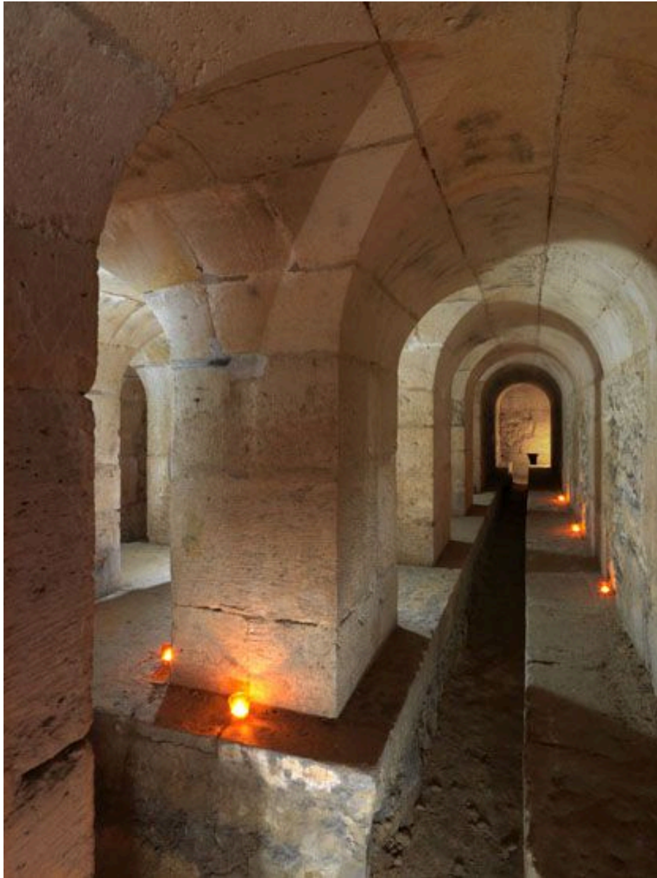
Rungis, Fontaines (petite voie des ) 7. Vue de l'intérieur du regard des Sources : piliers et cunette.
