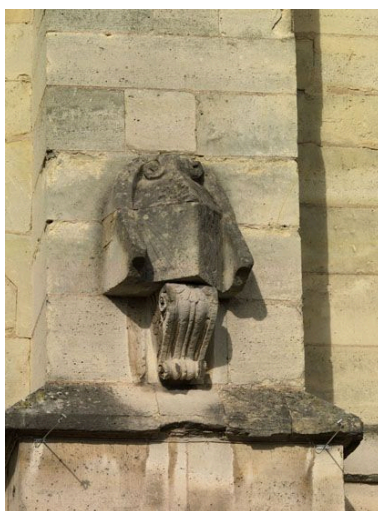
Arcueil. Cadran solaire ajouté au XVIII e siècle sur une des piles du pont-aqueduc. Phot. Laurent Kruszyk IVR11_20129400103NUC4A
