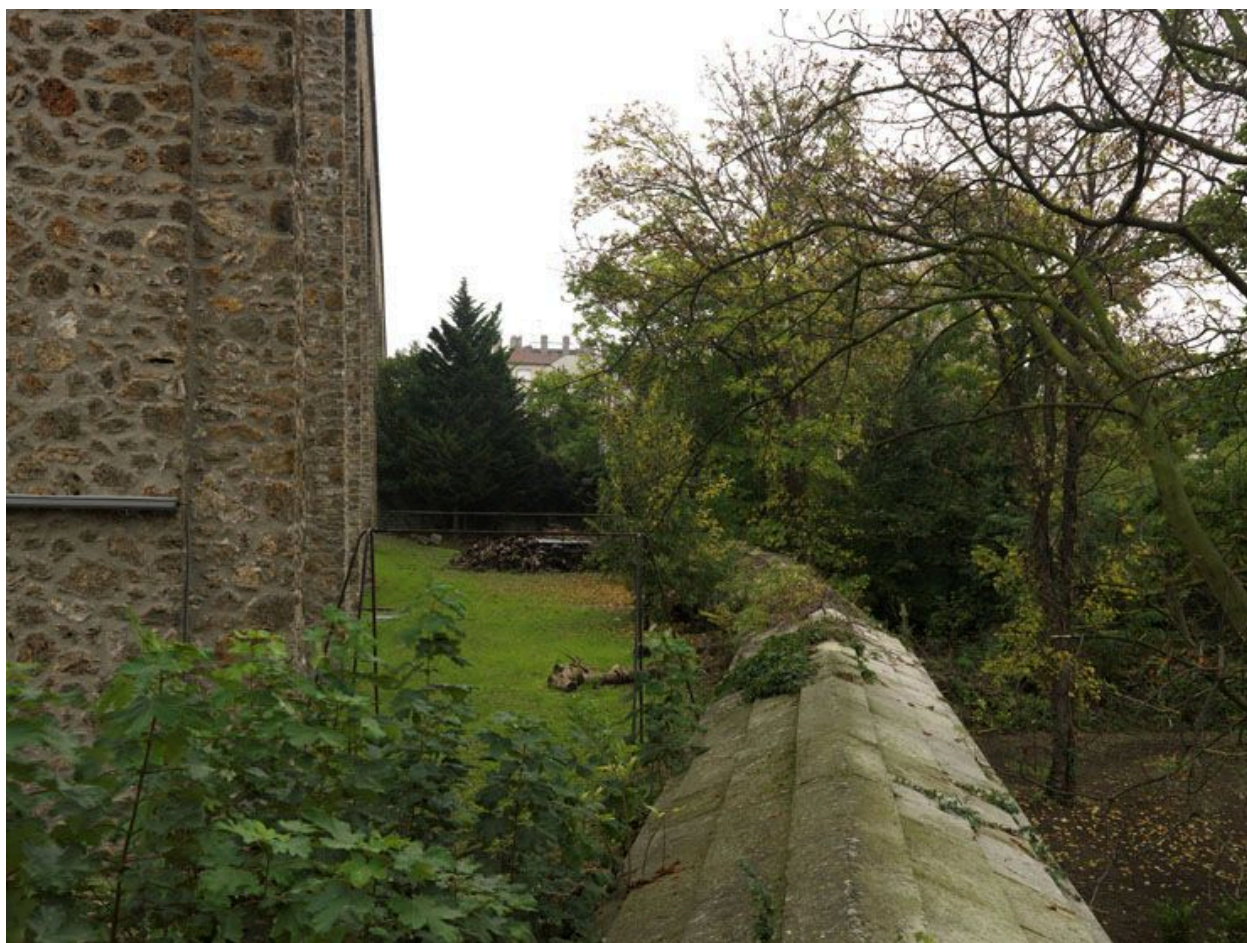
Arcueil. Vue sur les arcades du pont-aqueduc de la Vanne et sur le toit de la galerie du Médicis.
