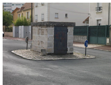
Fresnes, Regard (rue du) 17. Vue sur la façade nord et l'entrée du regard IV. Phot. Laurent Kruszyk IVR11_20129400090NUC4A
