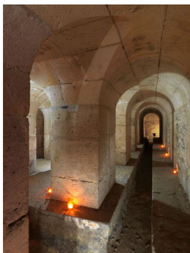
Rungis, Fontaines (petite voie des ) 7. Vue de l'intérieur du regard des Sources : piliers et cunette. Phot. Laurent Kruszyk IVR11_20129400122NUC4A
