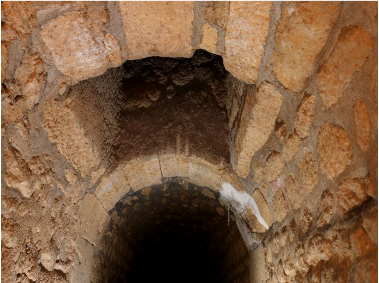
Rungis. Vue d'une cheminée à l'intérieur de la galerie entre le regard I et II.
