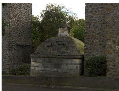
Arcueil, Jacques-Debrosses (boulevard). Vue sur la façade nord du regard XIV. Phot. Laurent Kruszyk IVR11_20129400095NUC4A
