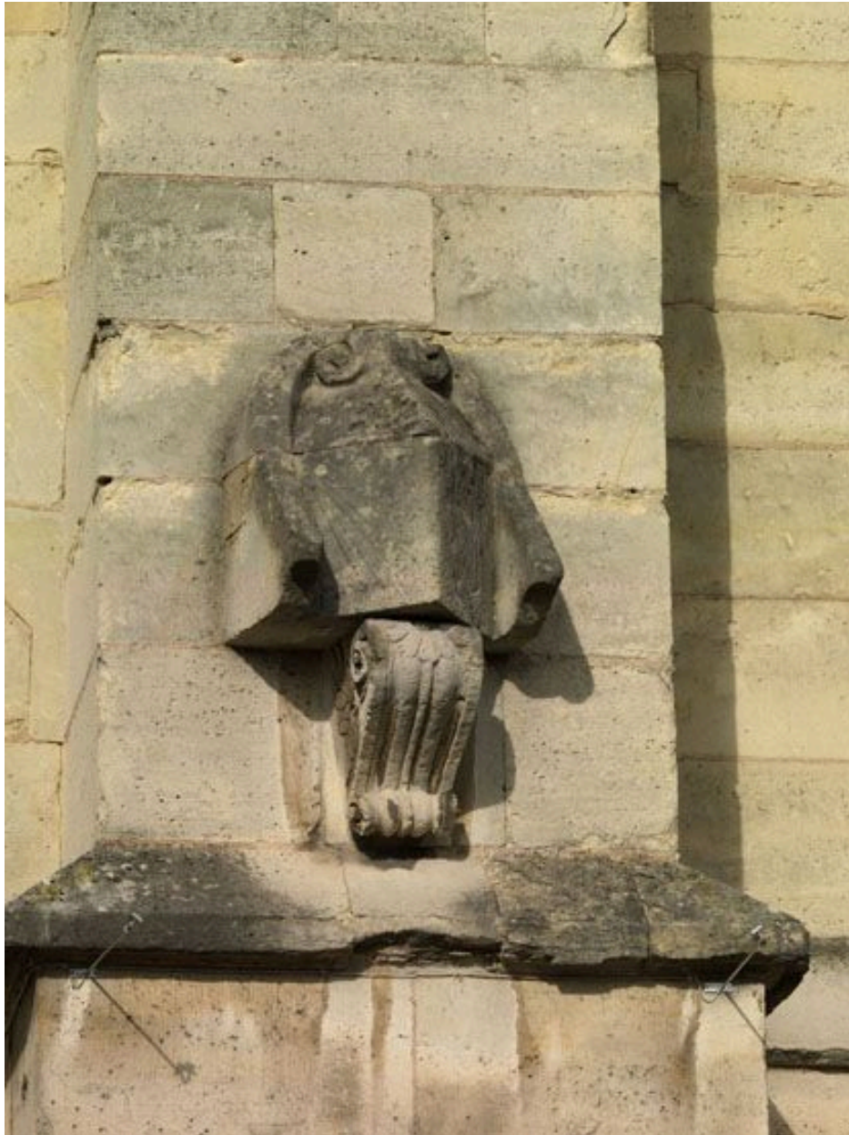
Arcueil. Cadran solaire ajouté au XVIIIe siècle sur une des piles du pont-aqueduc.
