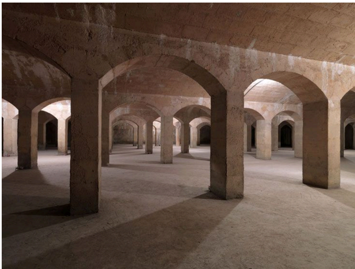
Paris 14e, Observatoire (avenue de l') 44. Maison du Fontainier : réservoir créé au XIXe siècle par les ingénieurs Mary et Lefort.
