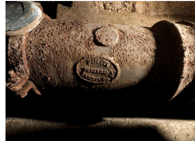
Paris 14e, Jourdan (boulevard) 17. Conduite forcée en fonte (XIXe siècle) de l'aqueduc sous la Cité Universitaire.
