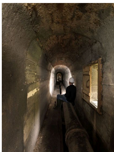
Arcueil. Vue de l'intérieur de le galerie du pont-aqueduc avec sa conduite forcée. Phot. Laurent Kruszyk IVR11_20129400133NUC4A
