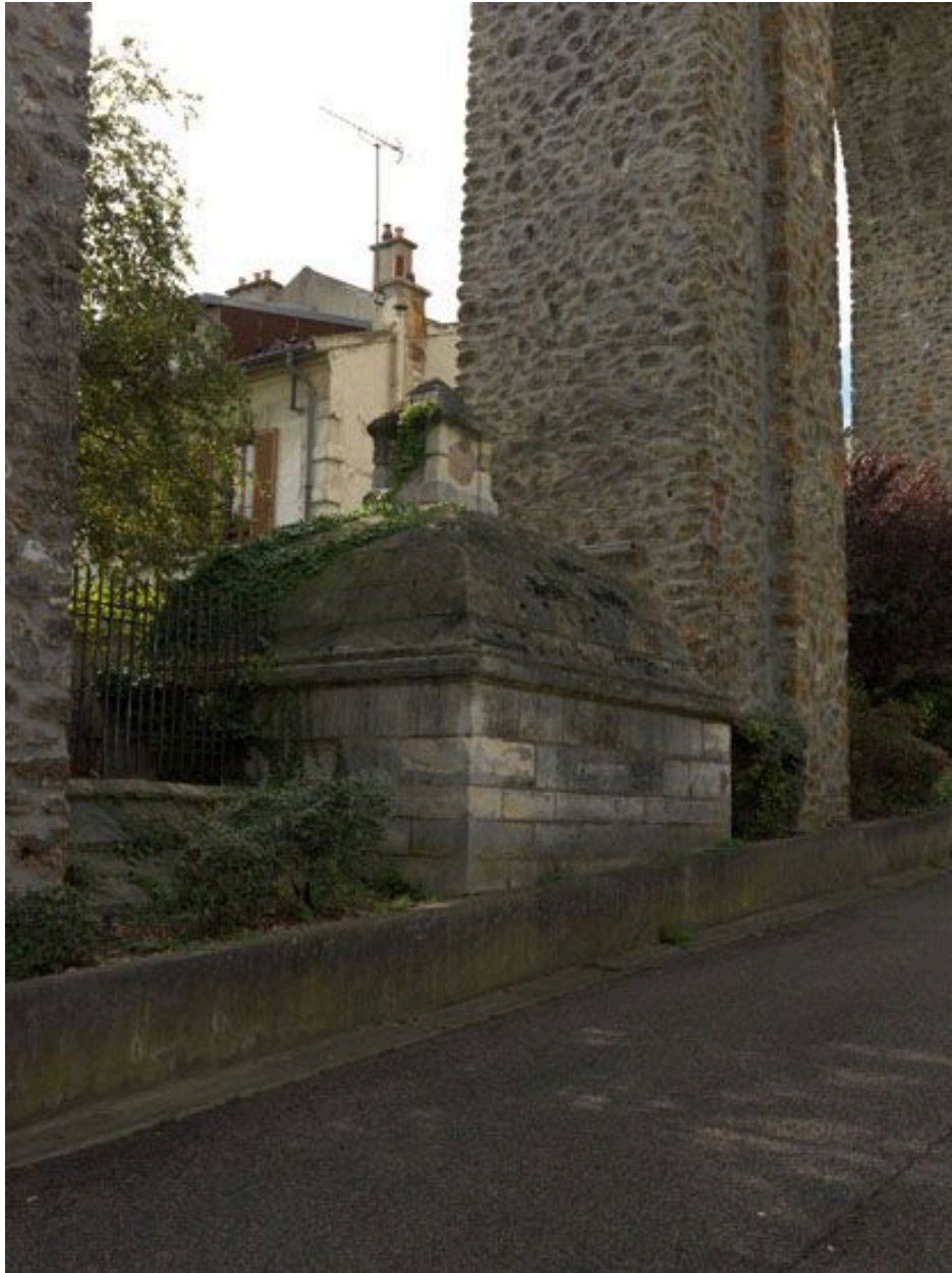
Arcueil, Jacques-Debrosses (boulevard). Vue sur la façade est du regard XIV.
