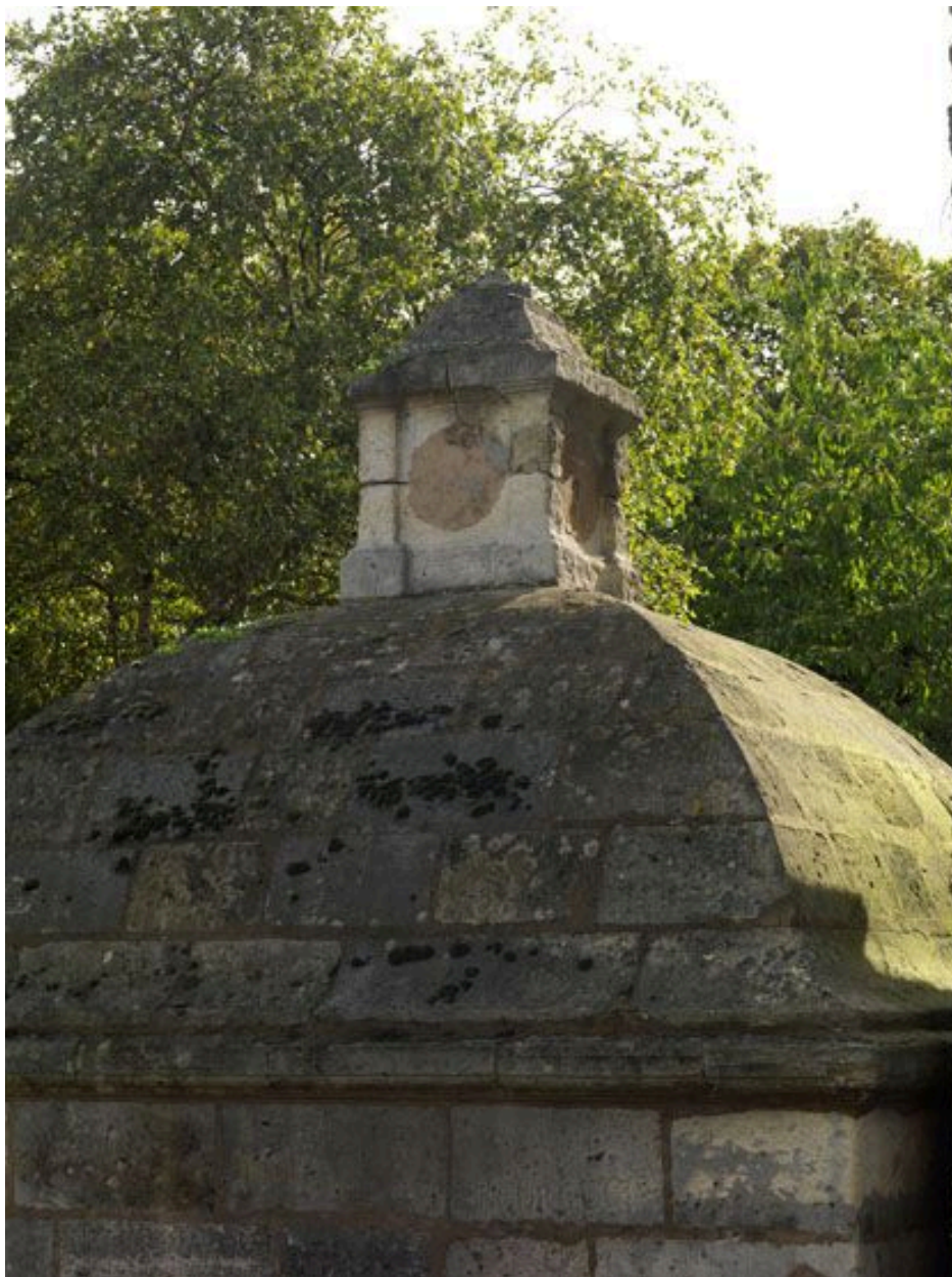
Arcueil, Jacques-Debrosses (boulevard). Vue sur le lanterneau du regard XIV.
