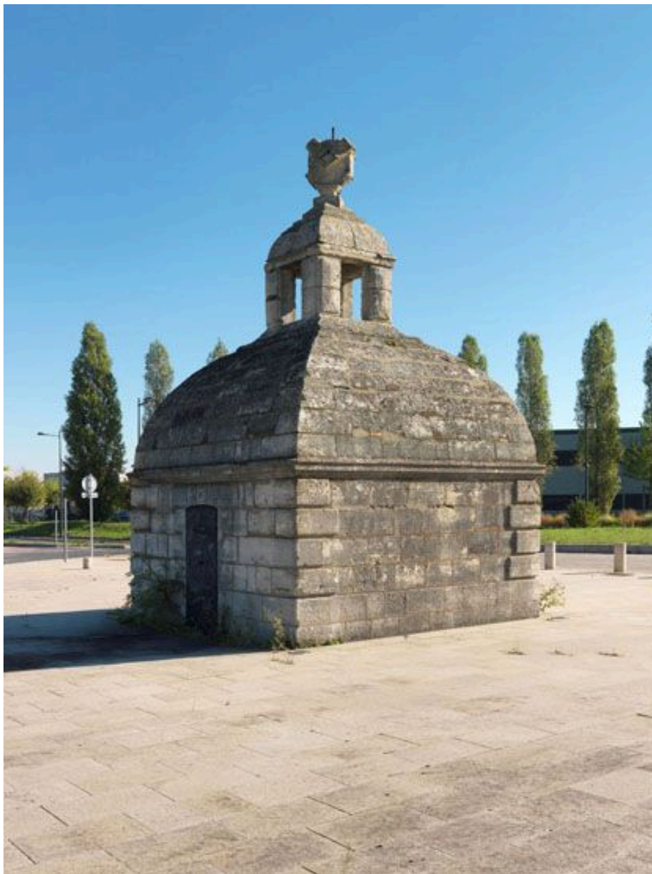
Fresnes, Chemin des Otages (rond-point du). Vue sur le regard III : angle sud-ouest.
