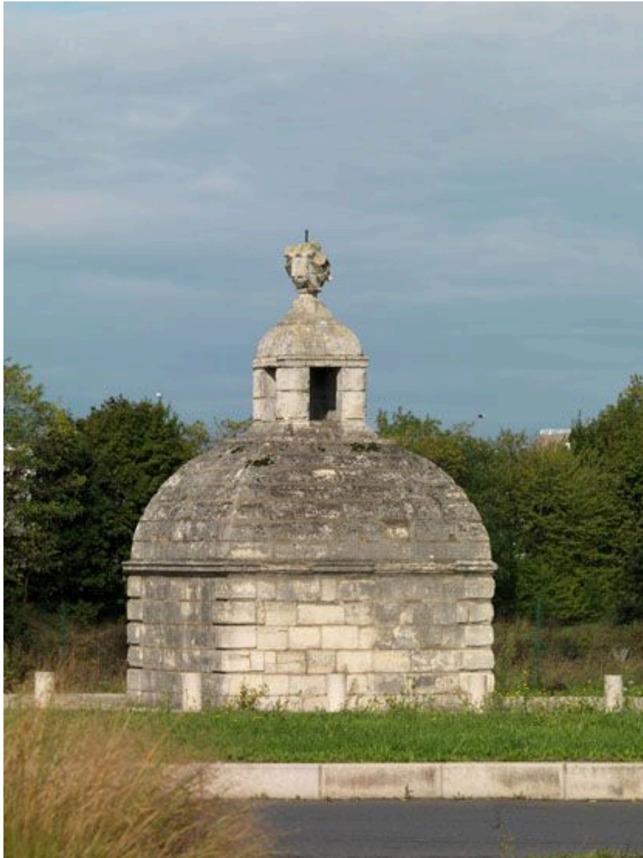
Fresnes, Chemin des Otages (rond-point du). Vue sur le regard III.
