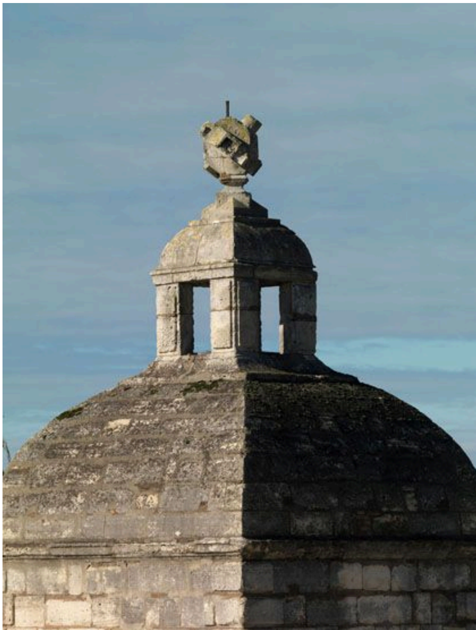
Fresnes, Chemin des Otages (rond-point du). Vue sur le regard III avec son lanterneau et acrotère : angle nord-est. Le sommet du lanterneau est une représentation de cadran solaire.
