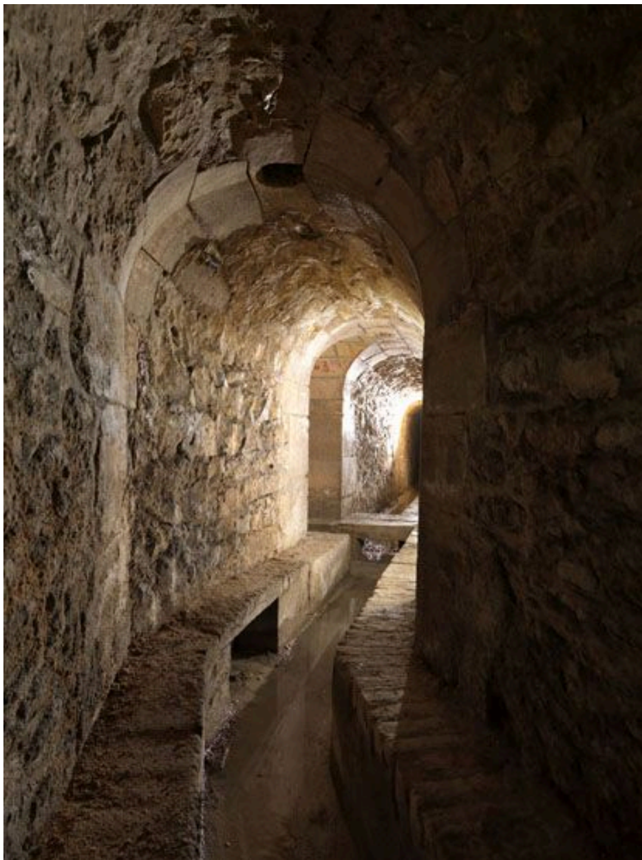
Rungis, Ecoliers (passage des). Banquettes de circulation aménagées dans la galerie amenant l'eau des sources dans le ""Carré des eaux"" à Rungis.
