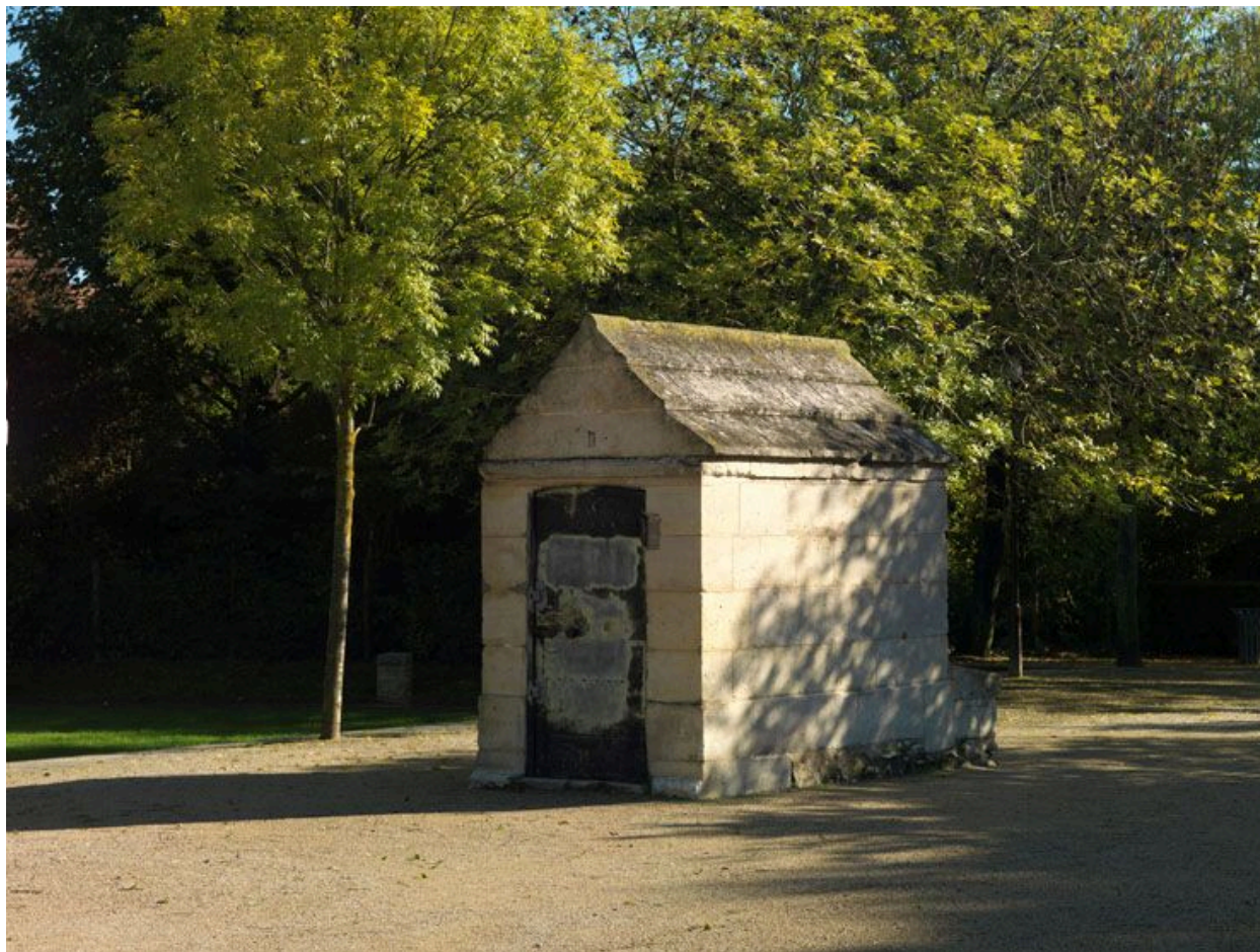
Rungis, Aqueduc (promenade de ). Regard II.
