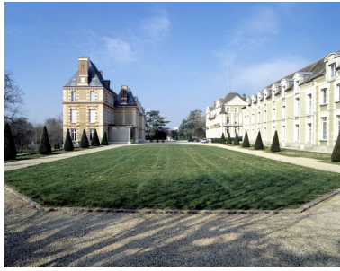
Vue d'ensemble, depuis l'est : à gauche, l'ancien logis abbatial (aujourd'hui préfecture) ; au premier plan à droite, l'hôtel du département.
