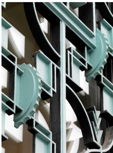
Détail de la façade, ferronneries de Raymond Subes Phot. Stéphane Asseline
