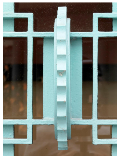
Détail de la façade, ferronneries de Raymond Subes Phot. Stéphane Asseline IVR11_20189200093NUC4A
