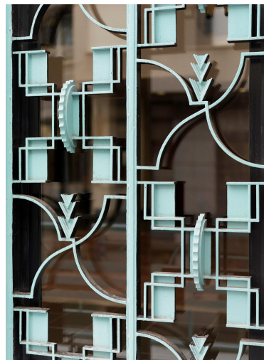
Détail de la façade, ferronneries de Raymond Subes Phot. Stéphane Asseline IVR11_20189200089NUC4A
