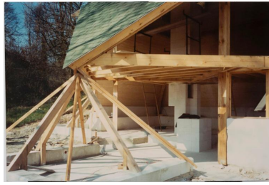
Vue du chantier. Phot. Laurent Kruszyk IVR11_20179100132NUC4A
