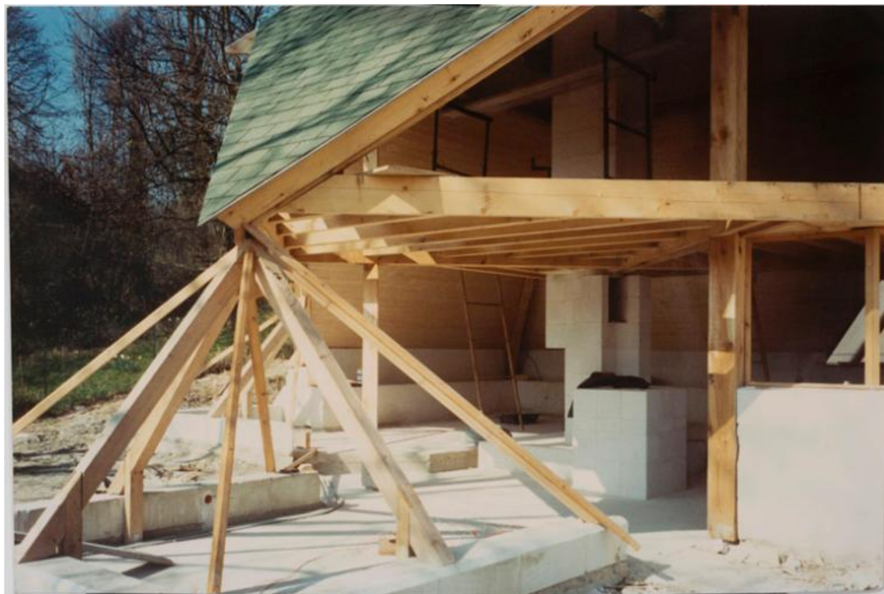
Vue du chantier.
