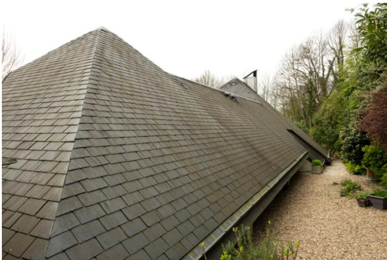
Vue générale de la façade postérieure.
