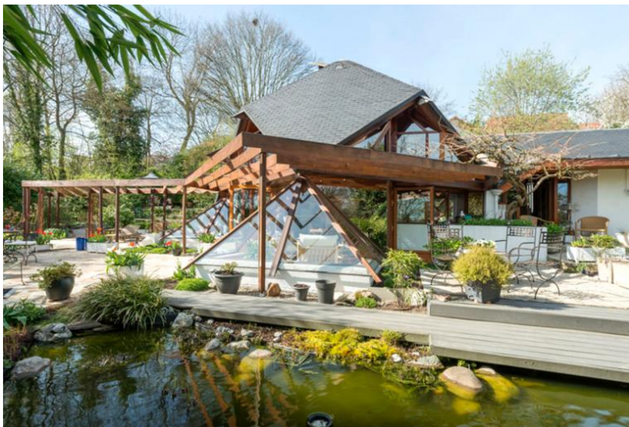
Vue de la façade principale : avant-corps Ouest et système de pergolas.
