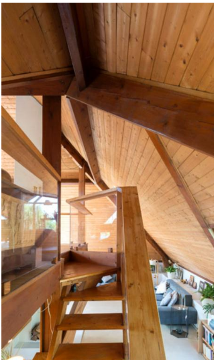
Vue de l'escalier desservant la mezzanine.
