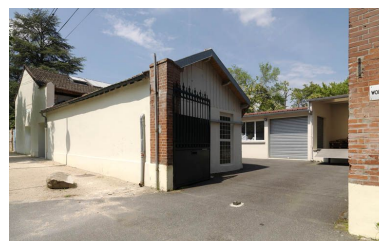
Vue générale. Phot. Philippe Ayrault IVR11_20097700526NUC4A
