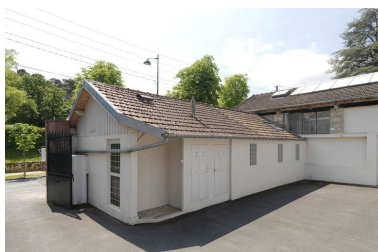
Vue, depuis la cour intérieure, des anciens bureaux et de la salle des machines en retour, devenus vestiaires et douches du gymnase. Phot. Philippe Ayrault IVR11_20097700522NUC4A
