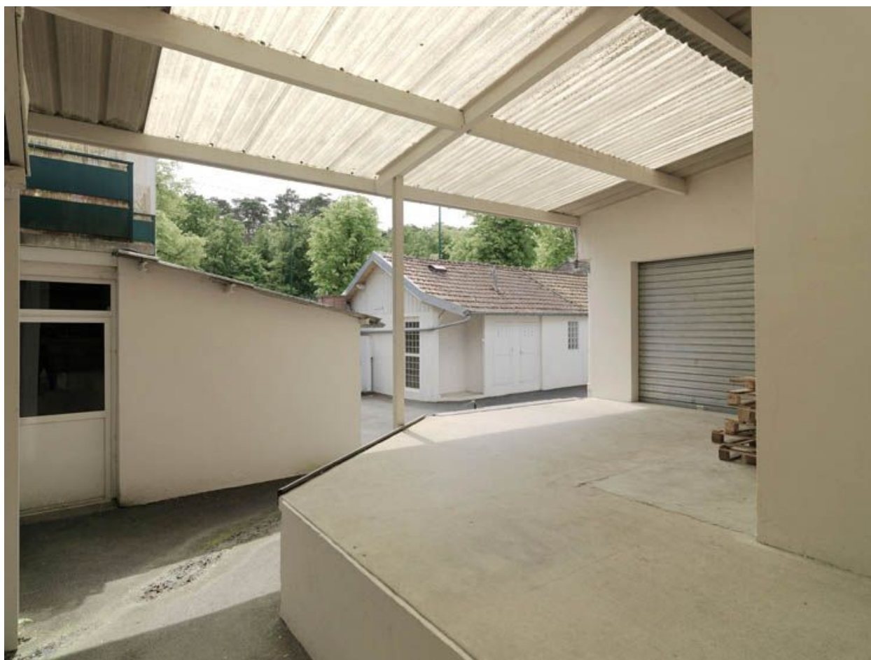
Quai de chargement.
