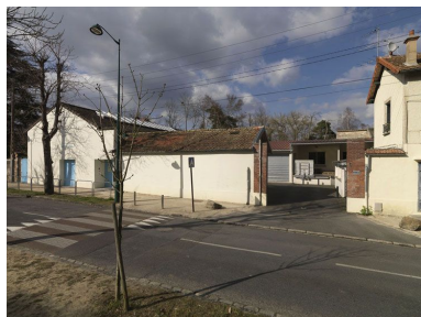
Vue générale. Phot. Laurent Kruszyk IVR11_20097700390NUC4A
