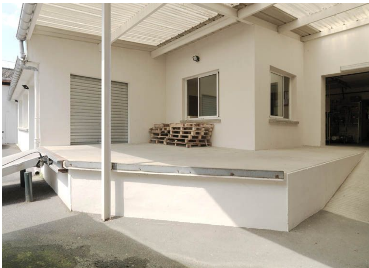
Quai de chargement.
