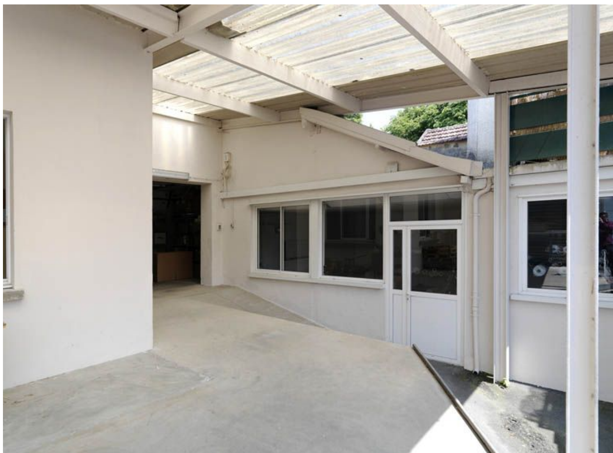
Vue de l'ancien atelier d'essais depuis le quai de chargement.
