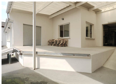
Quai de chargement.
