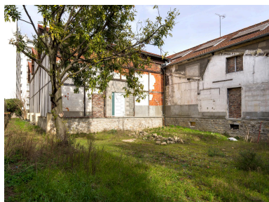
Derrière l'usine. À gauche, bâtiment aux trois sheds, à droite, chaudronnerie plastique.
