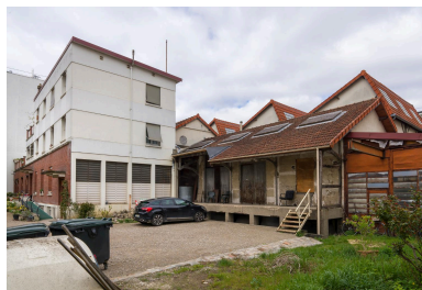
À droite, le quai de déchargement. À l'arrière, bâtiment à 3 sheds, dernier lieu de fabrication de la société du Lysol, actuellement atelier de thermoformage et espace de stockage.
