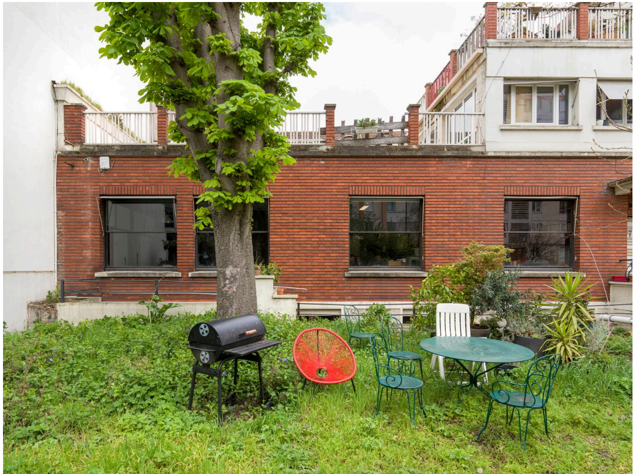
Façade des bureaux livrés fin 1959.
