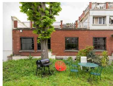
Façade des bureaux livrés fin 1959.
