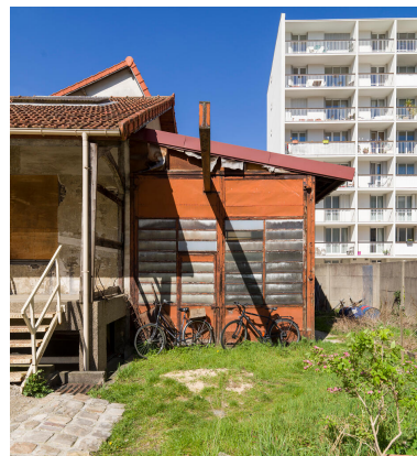
Palan de manutention et porte d'accès au sous-sol. Sortie de charges lourdes (machines) depuis les ateliers au sous-sol.
