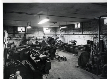
Atelier de mécanique générale (usinage). Tirage photographique noir et blanc, 18 x 24 cm, années 1950, Studio Louisianne, 152 avenue Danielle Casanova, Ivry-sur-Seine (collection Ateliers de Technochimie). Repro. Stéphane Asseline IVR11_20239400230NUC4A
