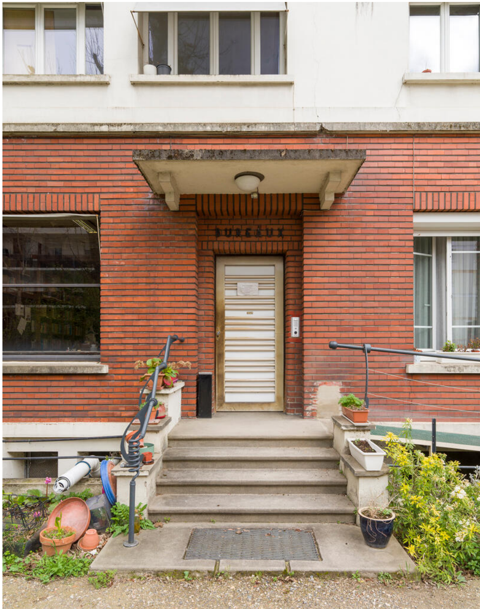
Perron des bureaux et porte en PVC, fabrication Ateliers de Technochimie.
