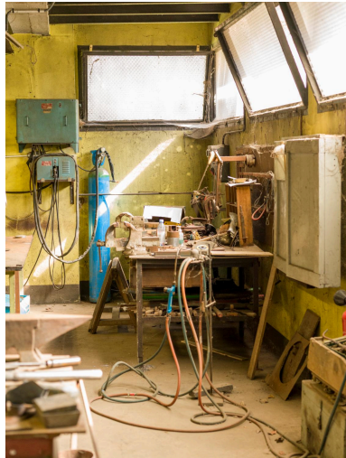
Chaudronnerie métallique. Poste à souder. Phot. Stéphane Asseline IVR11_20239400166NUC4A
