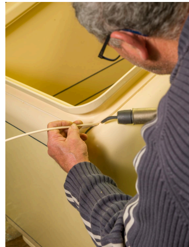
Chaudronnerie plastique. Fabrication d'une enceinte de confinement en PVC. Assemblage des éléments par soudure à air chaud. Phot. Stéphane Asseline IVR11_20239400342NUC4A
