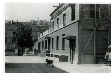
Transformation du pavillon d'habitation surélevé d'un étage (travaux achevés en 1964). Tirage photographique noir et blanc, 6,5 x 9,5 cm, août 1961, sans mention d'auteur (collection Ateliers de Technochimie). Phot. Stéphane Asseline
