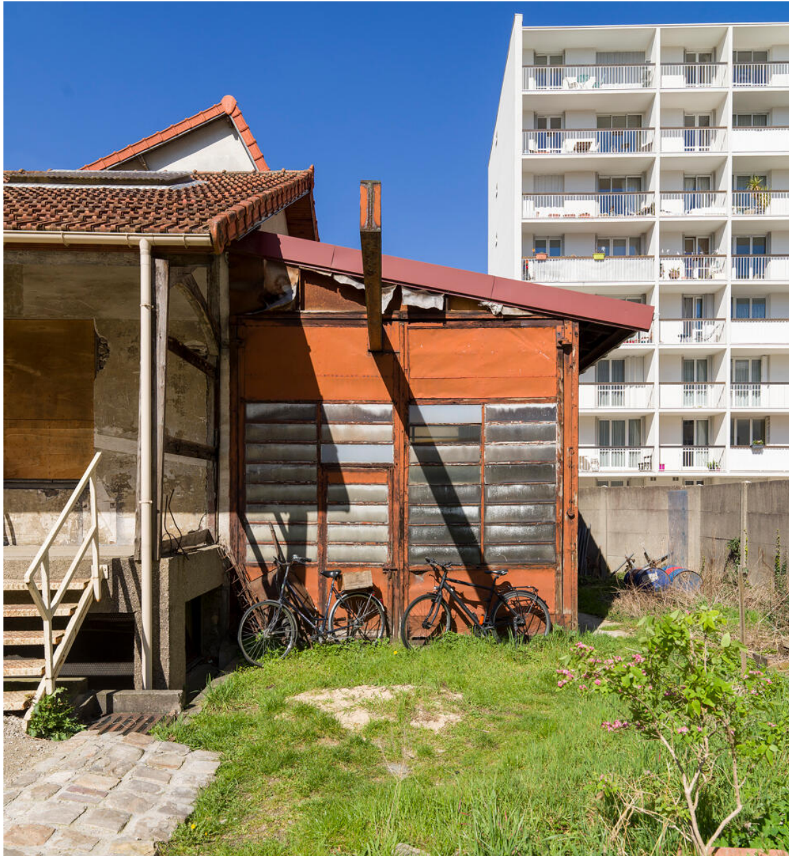
Palan de manutention et porte d'accès au sous-sol. Sortie de charges lourdes (machines) depuis les ateliers au sous-sol.
