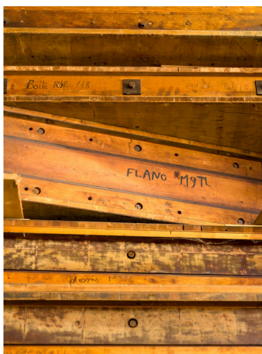
Bâtiments aux trois sheds. Moules de fabrication. Phot. Stéphane Asseline IVR11_20239400193NUC4A
