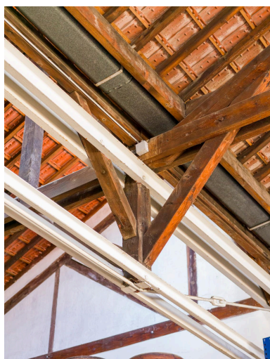
Bâtiment aux trois sheds. Détail de la charpente autoporteuse métallique datant vraisemblablement du début du XXe siècle. Phot. Stéphane Asseline IVR11_20239400190NUC4A
