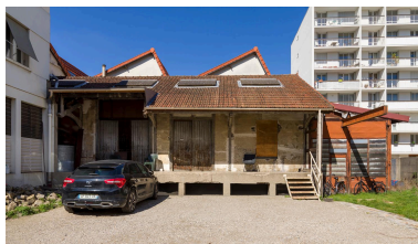
Quai de déchargement. À l'arrière, bâtiment à 3 sheds, dernier lieu de fabrication de la société du Lysol, actuellement atelier de thermoformage et espace de stockage.
