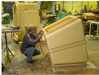
Chaudronnerie plastique. Fabrication d'une enceinte de confinement en PVC. Assemblage des éléments par soudure à air chaud. Phot. Stéphane Asseline IVR11_20239400340NUC4A
