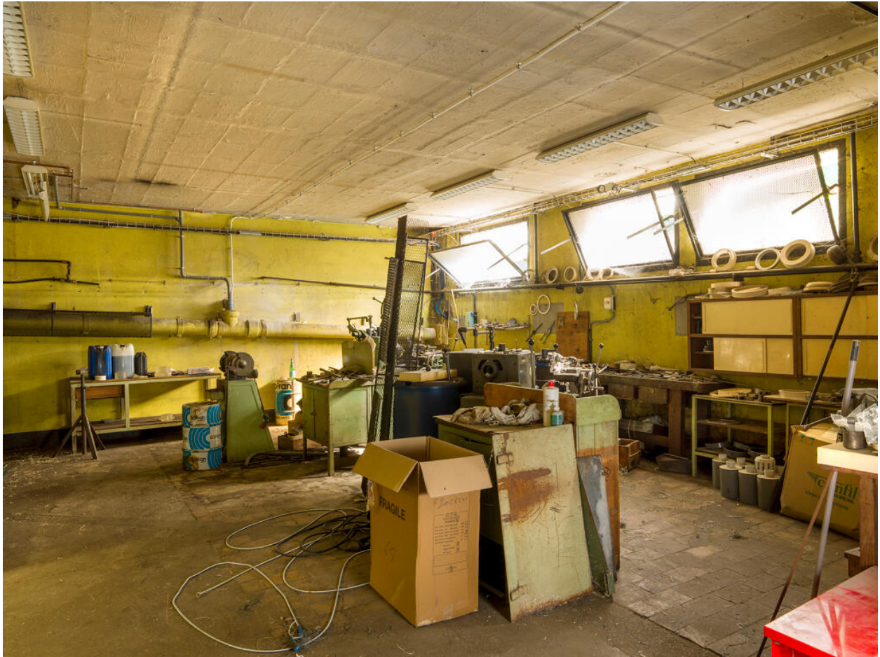
Atelier de mécanique générale (usinage), au sous-sol.
