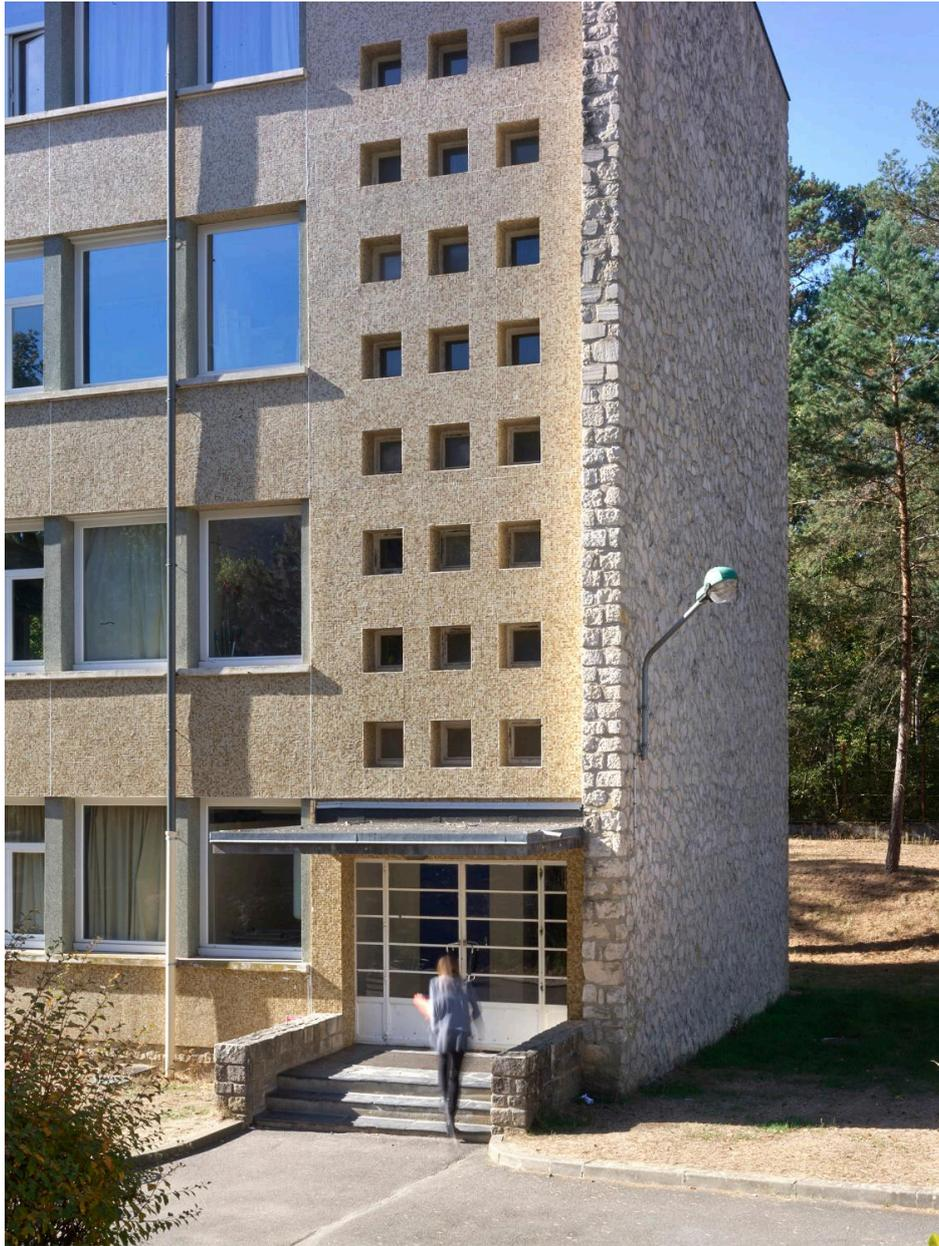
Détail des percements éclairant une cage d'escalier, reportée à l'extrémité d'une façade.
