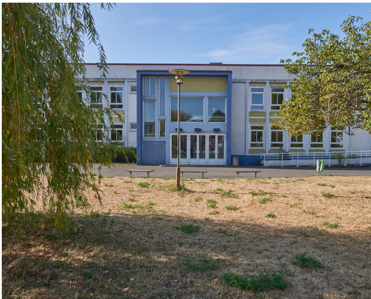
Le bâtiment des réfectoires et des cuisines, avec l'une de ses entrées monumentales, légèrement hors-œuvre.
