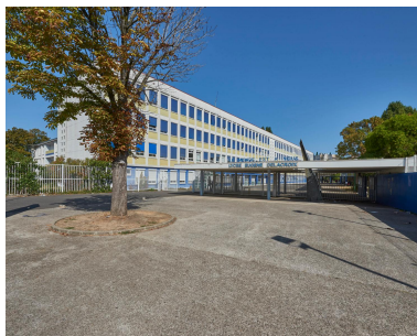
L'entrée du lycée et l'externat des garçons. Phot. Philippe Ayrault IVR11_20209300521NUC4A
