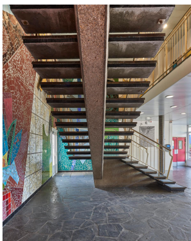
Détail de la pile de l'escalier conduisant aux bureaux de l'administration. Phot. Philippe Ayrault IVR11_20209300510NUC4A
