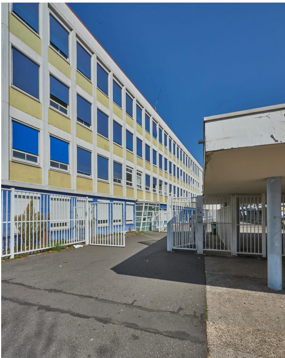
L'entrée du lycée avec le portique faisant le lien entre l'externat des garçons et le bâtiment du réfectoire et des cuisines.
