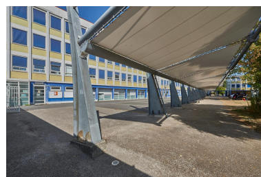
Une galerie couverte transversale, faisant à la fois office de circulation et de préau linéaire, a été érigée dans la cour de l'établissement au moment de la réhabilitation du lycée conduite entre 1993 et 1998. Phot. Philippe Ayrault IVR11_20209300525NUC4A
