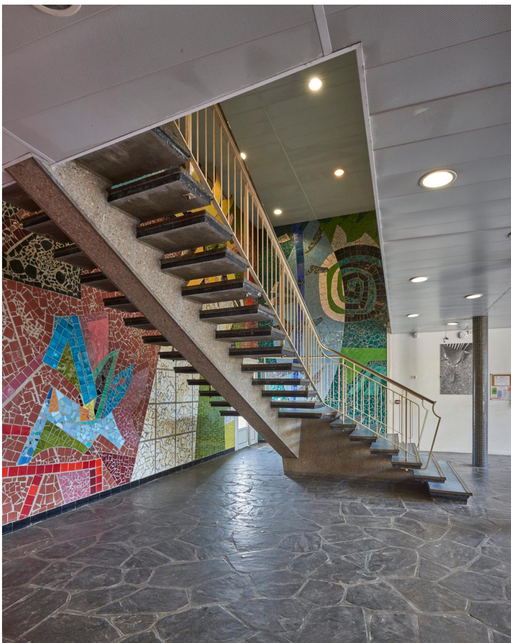
L'escalier et son unique pile en béton gravillonné servant de support aux marches.
