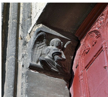
Détail de la console supportant l'extrémité gauche du linteau : ange tenant un encensoir.
