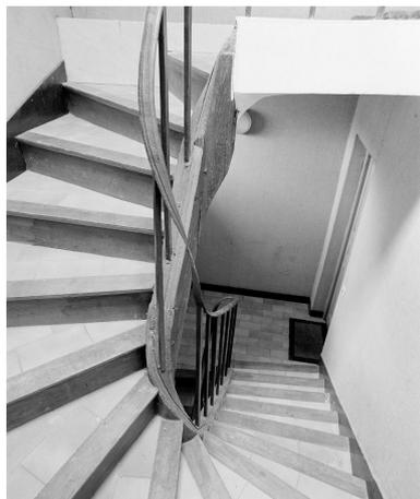
Vue de l'escalier intérieur ; il date de la deuxième moitié du 18e siècle. Les barreaux de section carré reposent sur une plate-bande fixée sur le limon.
