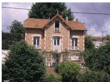
Vue d'ensemble ; un garage occupe le côté droit du rez-de-chaussée, tandis qu'à gauche des pilotis supportent le 1er étage, sous un toit en dévers.
