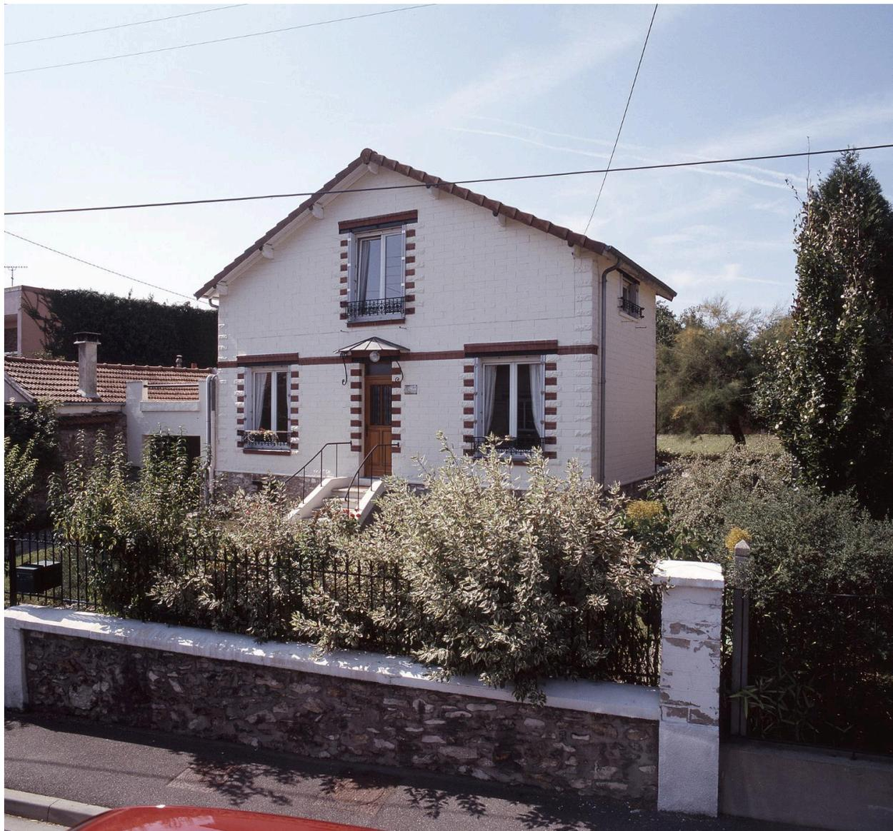
Elévations en parpaings du pavillon avec effet de bossage aux angles et à l'encadrement des baies.
