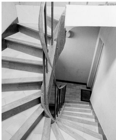
Vue de l'escalier intérieur ; il date de la deuxième moitié du 18e siècle. Les barreaux de section carré reposent sur une plate-bande fixée sur le limon.
