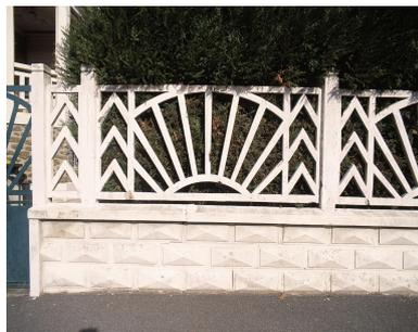
Clôture en ciment. Les panneaux ajourés reposent sur un muret en parpaings moulés ; le motif de ces panneaux est repris en métal à la porte d'entrée.
