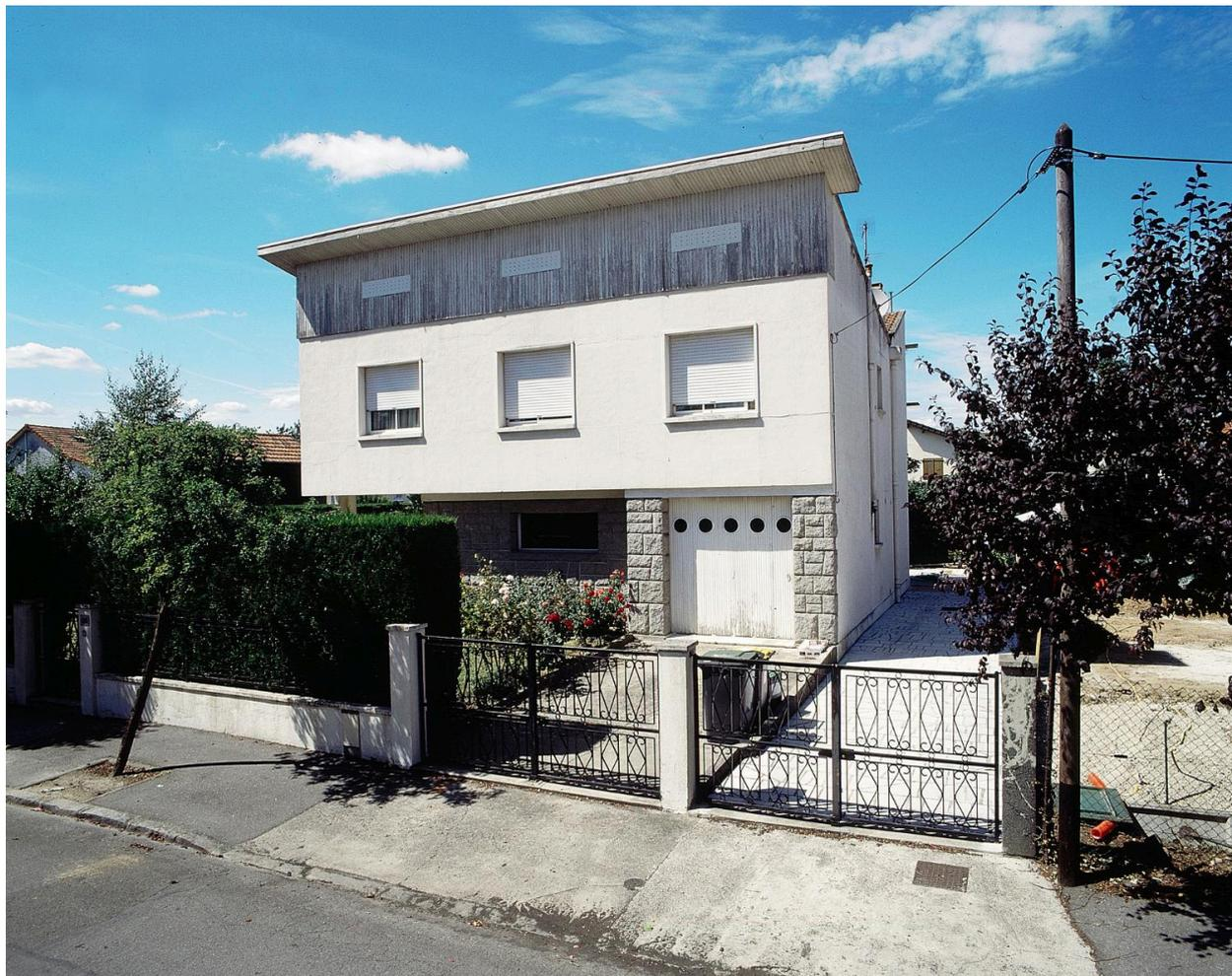
Vue d'ensemble ; un garage occupe le côté droit du rez-de-chaussée, tandis qu'à gauche des pilotis supportent le 1er étage, sous un toit en dévers.
