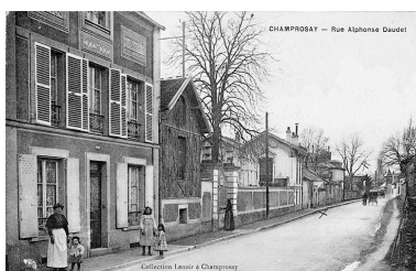
Vue de la rue Alphonse-Daudet, au débouché de la rue de l'Ermitage, en direction de Draveil-centre. Carte postale, vers 1910.. (Collection particulière) Phot. Philippe Ayrault, Autr. Collection Lenoir (Tabac) IVR11_20059100442XB
