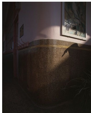
Détail du revêtement de granito sur la partie basse des murs.
