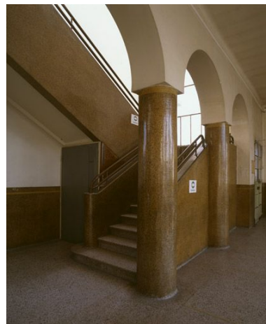
Escalier menant aux classes de l'étage de l'école des garçons donnant par une colonnade à claire-voie sur le hall. L'escalier, les colonnes et le sol sont revêtus de granito.
