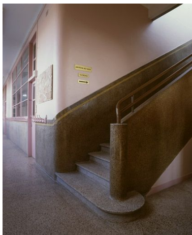
Départ d'un escalier revêtu de granito comme la partie inférieure des murs et le sol.
