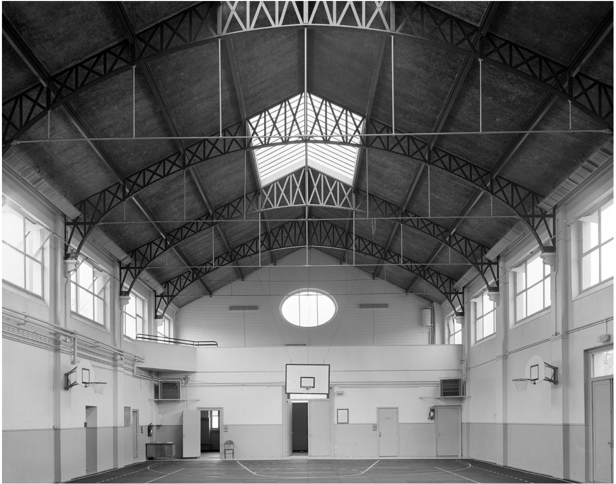
Vue intérieure vers l'entrée. gymnase Paul et René Colas
