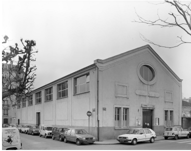
Vue depuis la rue Edmé Perrier? gymnase Paul et René Colas Phot. Christian Décamps IVR11_19879200146VS
