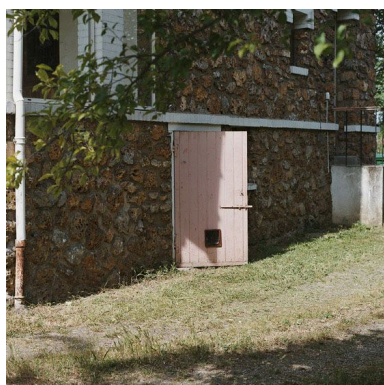
Pavillon construit au 39, rue des Deux-Cèdres, par l'architecte Robert Gilles : vue de la porte d'accès à la cave située sur la façade latérale. Phot. Philippe Ayrault IVR11_20069100261XE
