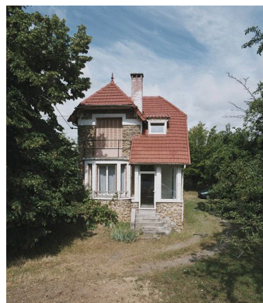
Vue d'ensemble du pavillon construit au 39, rue des Deux-Cèdres par l'architecte Robert Gilles et l'entrepreneur Henri Maillard. Ceux-ci ont réalisé trois autres pavillons du même type pour une même famille. Ce modèle est caractérisé par un plan en L (façade principale composée d'une partie pignon et d'une autre gouttereau), une entrée sous un porche, et la présence sur le pignon de la façade antérieure d'un bow-window surmonté d'un balcon.
