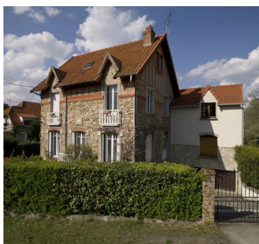
Vue d'ensemble de la maison, 35 allée des Vergers. Elle a été agrandie d'un corps de bâtiment avec garages en rez-de-chaussée. Phot. Philippe Ayrault IVR11_20089100364NUC4A
