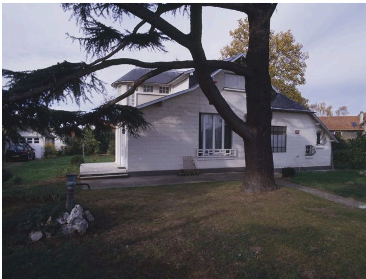
Vue d'ensemble de la maison, 15 allée de Villeneuve. Les murs sont construits en parpaings enduits.
