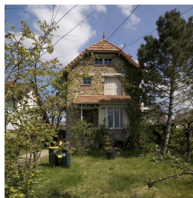
Maison construite en 1922, 13 allée des Vergers. Le devis prévoyait des murs en agglomérés creux remplacés par de la meulière.
