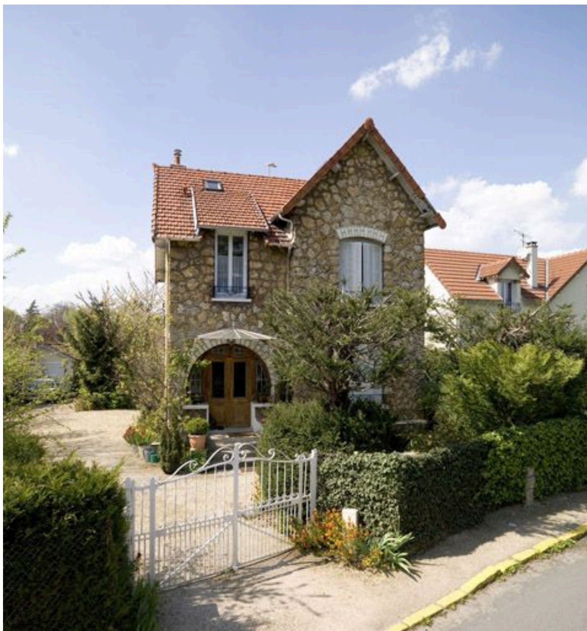
Vue d'ensemble du pavillon, 42 allée des Vergers.
