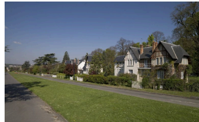
Pavillons doubles, 31-33 allée de la Perspective. Ces pavillons ont été édifiés selon les servitudes imposées pour cette allée (mitoyenneté et alignement à distance obligatoire de l'allée, barrières en béton peint de type ""haras""). Phot. Philippe Ayrault IVR11_20089100322NUC4A
