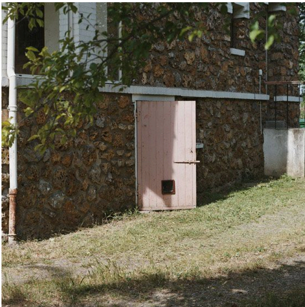
Pavillon construit au 39, rue des Deux-Cèdres, par l'architecte Robert Gilles : vue de la porte d'accès à la cave située sur la façade latérale.
