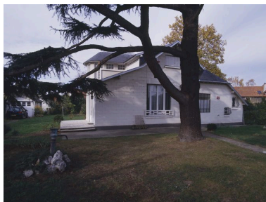
Façade arrière de la maison, 15 allée de Villeneuve.
