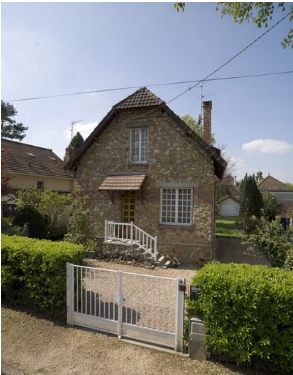
Vue d'ensemble de la maison, 24 allée des Vergers. Elle a été édifée en 1924 par Roger Vasseur et Pierre Prunet, architectes à Gentilly (15, rue Lafouge).
