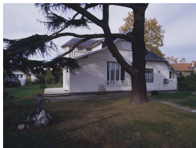
Vue d'ensemble de la maison, 15 allée de Villeneuve. Les murs sont construits en parpaings enduits.
