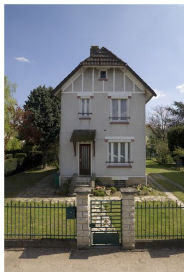
Maison, 4 allée de la Cité-Nouvelle. Elle a été édifée en 1923 par E. Lafont, architecte à Paris 20e. La plupart des pavillons réalisés par
