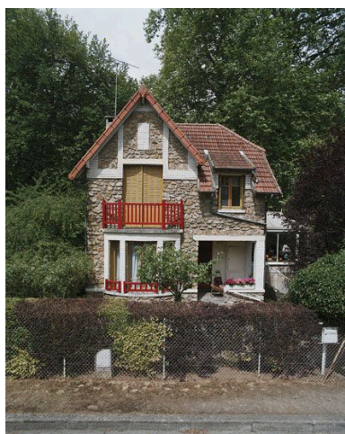
Vue d'ensemble du pavillon, 17 allée du Nord-au-Sud. Il a été vraisemblablement construit par l'architecte Robert Gilles, comme celui du 43, allée des Deux-Cèdres. Phot. Philippe Ayrault
