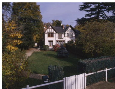
Vue d'une maison depuis l'allée des Deux-Cèdres. Phot. Philippe Ayrault IVR11_20069101080XA
