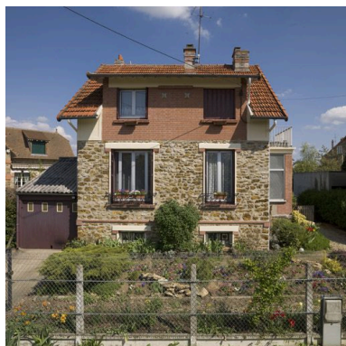
Vue d'ensemble du pavillon construit en 1925, 47 allée des Vergers. La brique est utilisée par cet architecte pour les éléments de construction secondaire (chien assis) ou pour souligner les fenêtres (5, allée du Cloître). Phot. Philippe Ayrault IVR11_20089100351NUC4A
