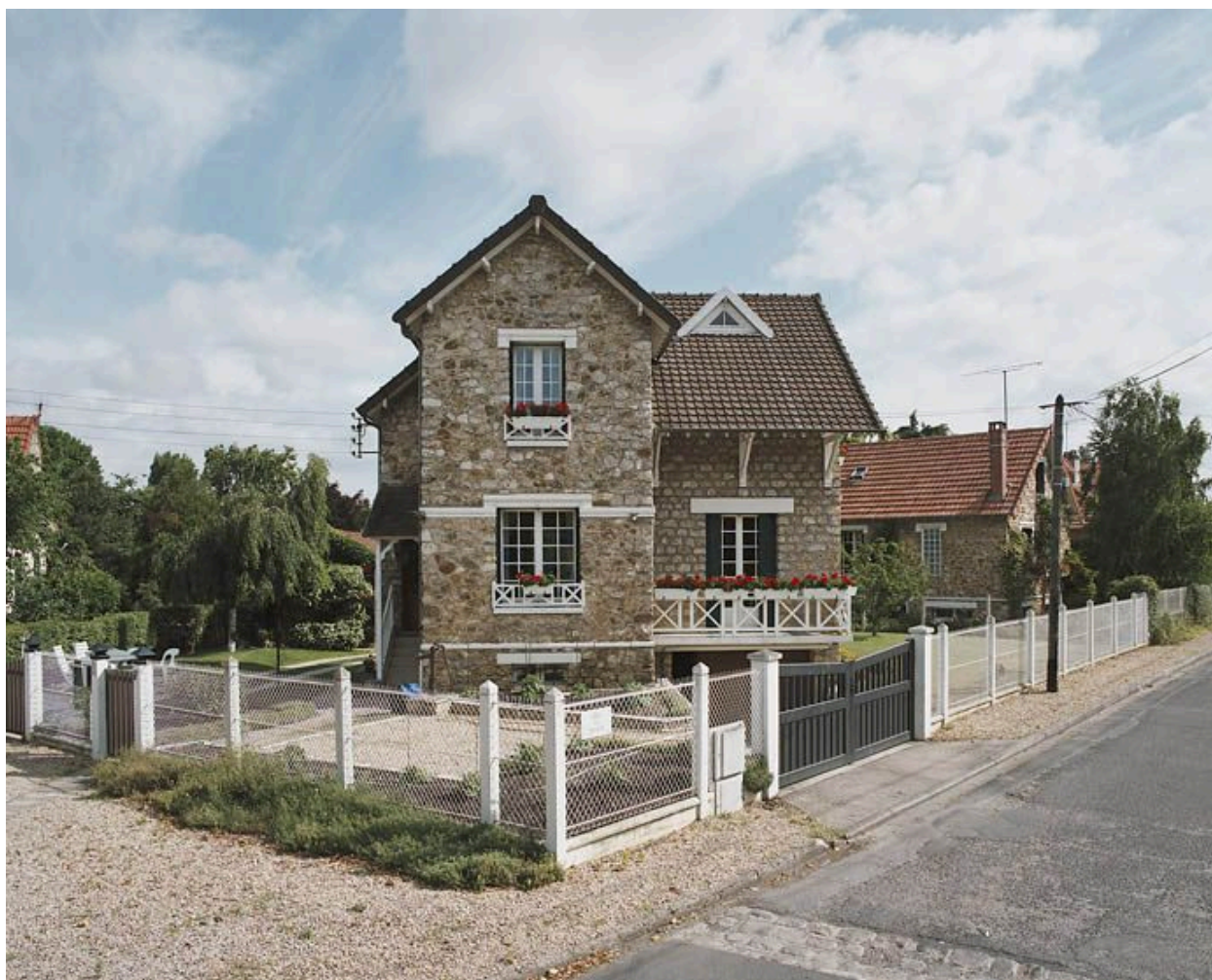
Vue latérale du pavillon, 7 place des Vergers. Construit en 1923, il a été agrandi en 1955 (par l'adjonction d'un corps de bâtiment sur la façade arrière).
