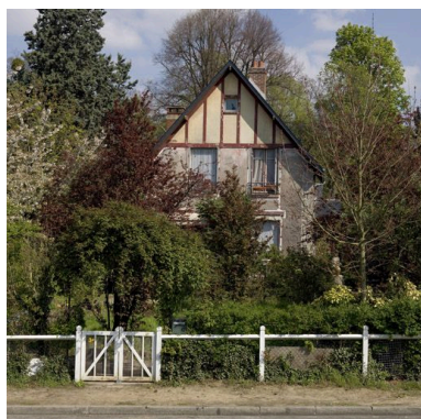
Maison, 25 allée de la Perspective. Ce pavillon d'un étage carré, dont la distribution est analogue à celui du 13, allée des Vergers, a été construit en agglomérés de sable et ciment par l'entrepreneur André Comolo de Vigneux-sur-Seine. La réalisation n'est pas tout à fait conforme au plan : il manque le bow-window latéral.
