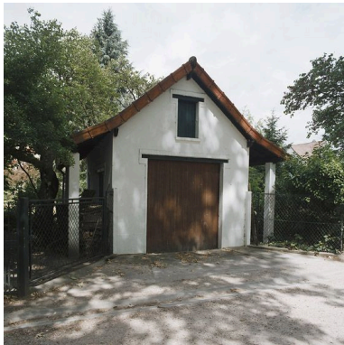
Cabanon-garage au bord de l'étang des Platanes. Phot. Philippe Ayrault IVR11_20069100272XE
