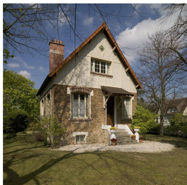
Maison à l'angle de l'allée du Sud- au-Nord (n°25) et de l'allée des Vergers (n°10). La plupart des pavillons dus à Marcel Legros ont un soubassement et un rez-de- chaussée en meulière, sous un étage de comble ou en surcroît enduit et décoré de faux pans de bois. Phot. Philippe Ayrault IVR11_20089100334NUC4A
