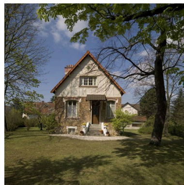
Maison à l'angle de l'allée du Sud- au-Nord (n°25) et de l'allée des Vergers (n°10). Elle a été construite par Marcel Legros, architecte à Villejuif (2bis, Grande Rue) en 1925. Phot. Philippe Ayrault IVR11_20089100335NUC4A
