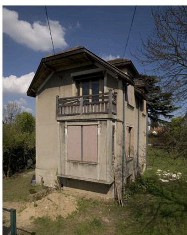
Vue d'ensemble de la maison, 3 allée aux Biches. Elle a été construite selon les plans dessinés par son propriétaire M. Castets.
