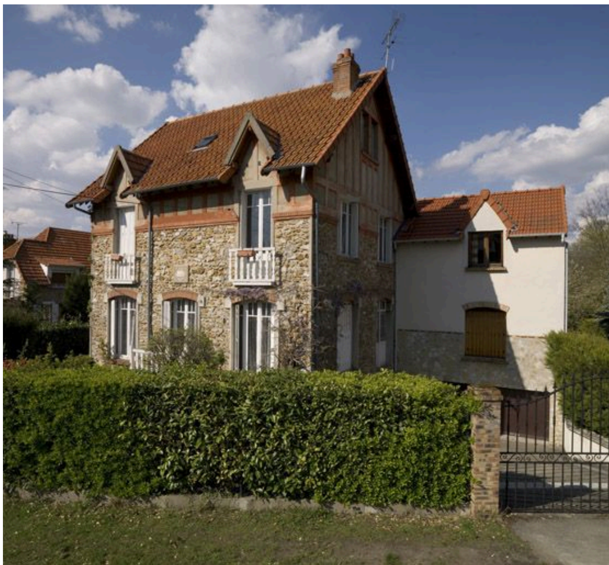
Vue d'ensemble de la maison, 35 allée des Vergers. Elle a été agrandie d'un corps de bâtiment avec garages en rez-de-chaussée.
