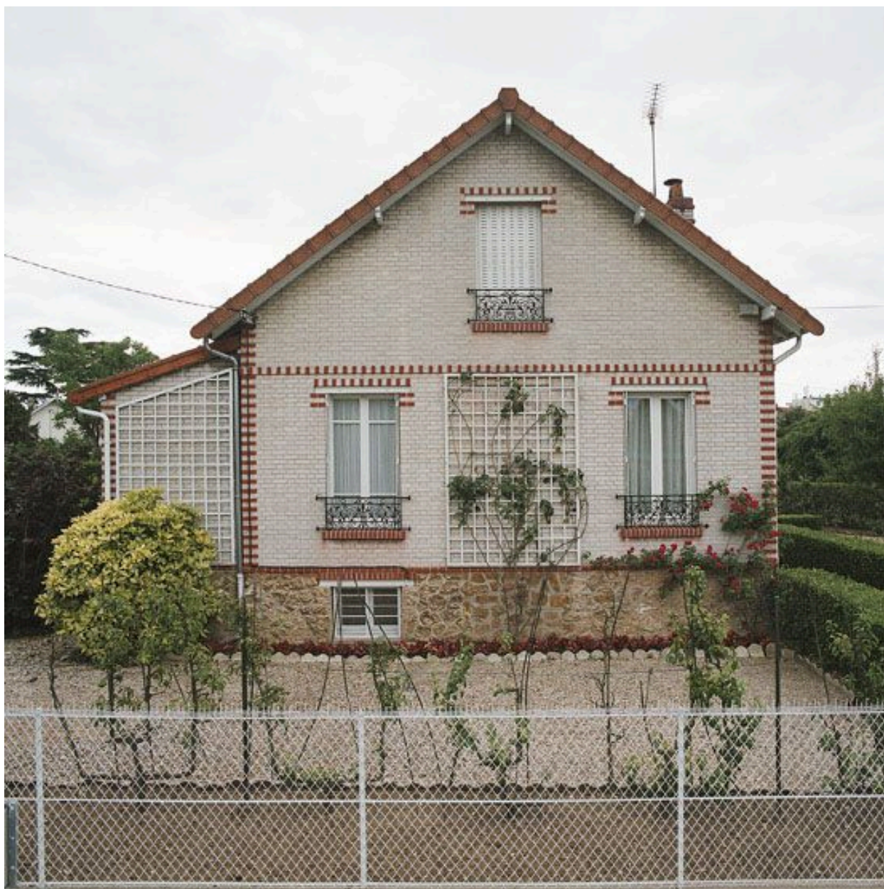
Vue d'ensemble de la maison, 8 allée des Sports. Elle a été construite en 1924 par l'architecte Louis Martin. Les nombreux pavillons édiés par cet architecte présentent une grande variété de plan et de décor.
