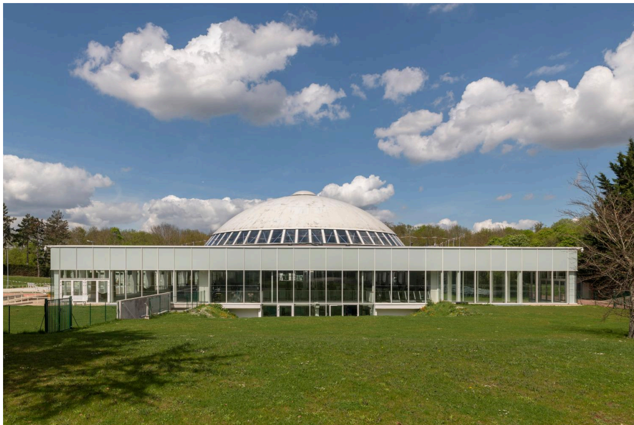
Vue de la face sud de la piscine du dôme de Saint-Germain-en-Laye
