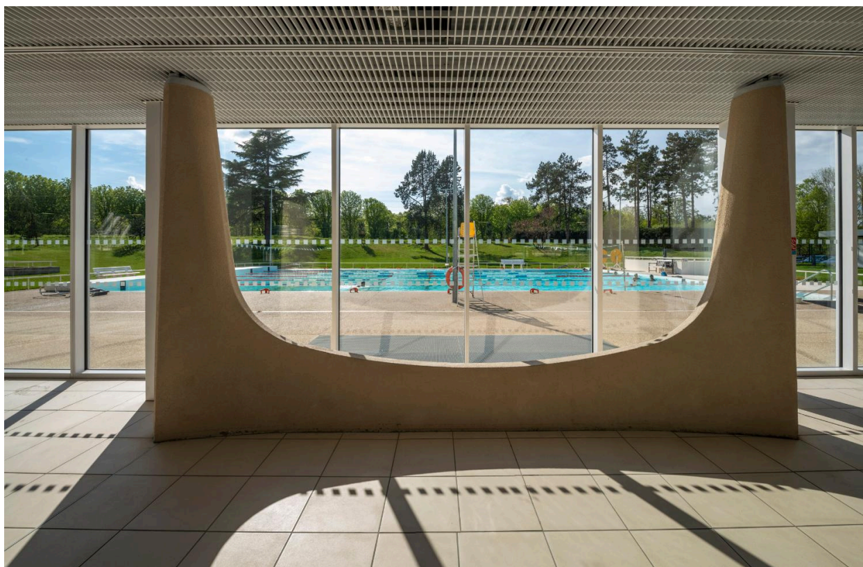
Vue intérieure d'un double pilier en anse de panier inversé et du mur-rideau
