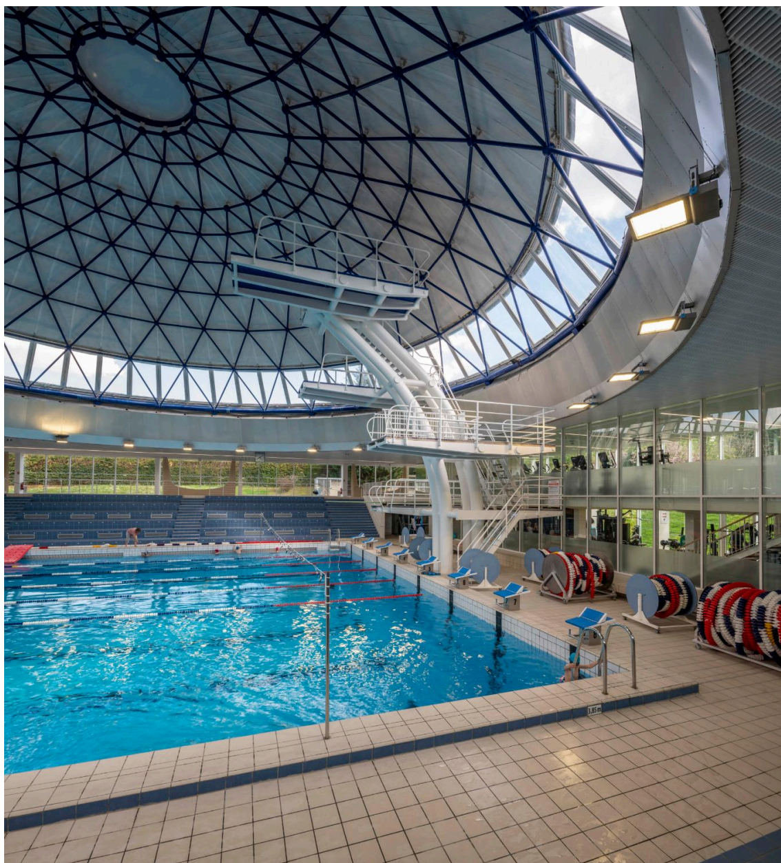
Bassin olympique, plongeurs et dôme, vue intérieure depuis l'ouest
