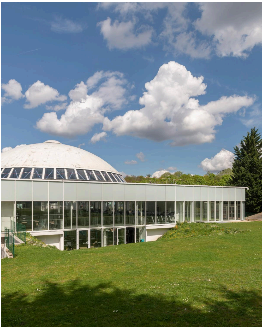
Vue de la face sud de la piscine du dôme de Saint-Germain-en-Laye
