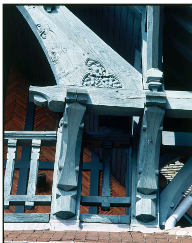
Le "'Château'". Détail de la façade postérieure sur champ de courses, ferme débordante de la travée latérale : aisselier, blochet, et base de l'arbalétrier. Phot. Christian Décamps IVR11_19879200286XA
