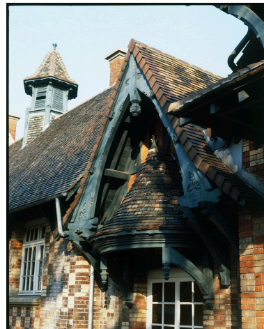
Le "château". Façade antérieure sur cour. Détail d'un auvent. Phot. Christian Décamps IVR11_19879200209XA
