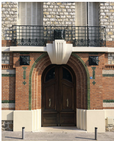
Vue de l'entrée au numéro 8 Phot. Jean-Bernard Vialles IVR11_20089500525NUC4A
