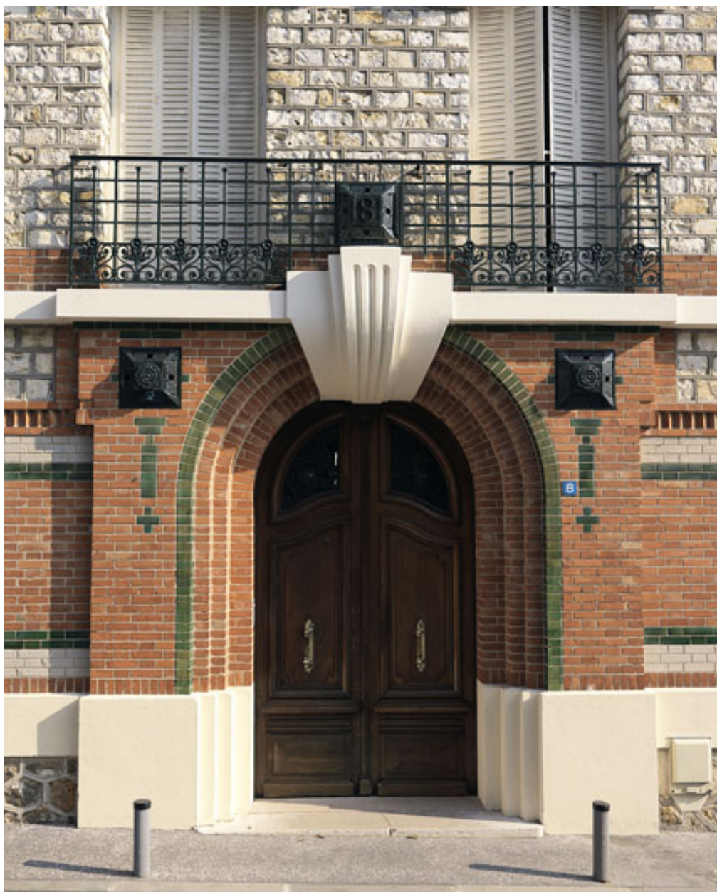
Vue de l'entrée au numéro 8
