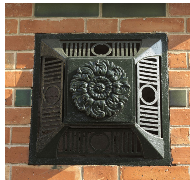
Détail de l'une des plaques de métal ornant l'entrée au numéro 8. Phot. Jean-Bernard Vialles IVR11_20089500524NUC4A
