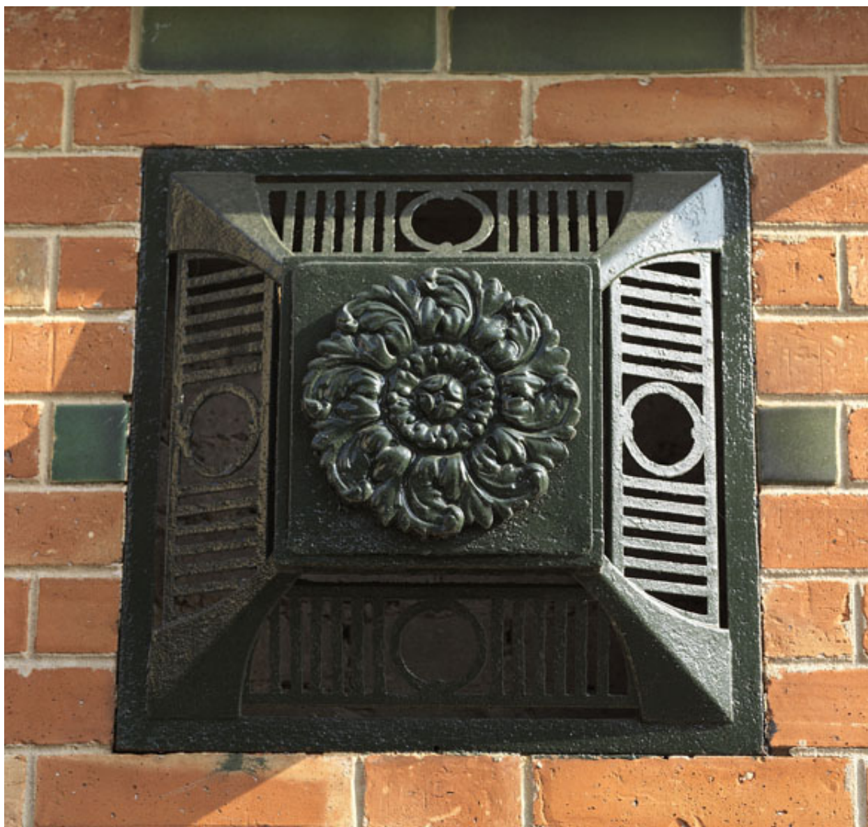
Détail de l'une des plaques de métal ornant l'entrée au numéro 8.
