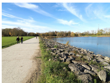
La partie sud-ouest du lac de Vaires, vue de l'est. Phot. Jean-Bernard Vialles IVR11_20157700256NUC4A
