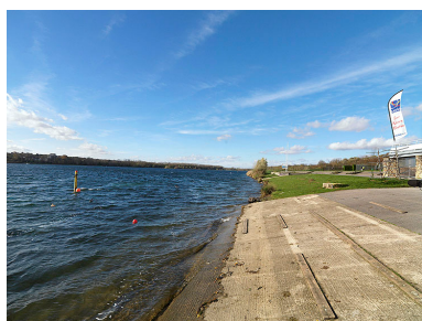
La rampe au pied du bâtiment de l'UCPA. Phot. Jean-Bernard Vialles IVR11_20157700216NUC4A
