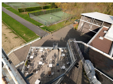
Vue panoramique sur la partie nord du site de Vaires, depuis le sommet de la tour d'arrivée. Phot. Jean-Bernard Vialles IVR11_20157700201NUC4A
