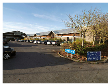
Les gymnases, vus du sud-est. Phot. Jean-Bernard Vialles IVR11_20157700221NUC4A
