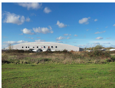
Le hangar à bateaux, vu de l'est. Phot. Jean-Bernard Vialles IVR11_20157700233NUC4A
