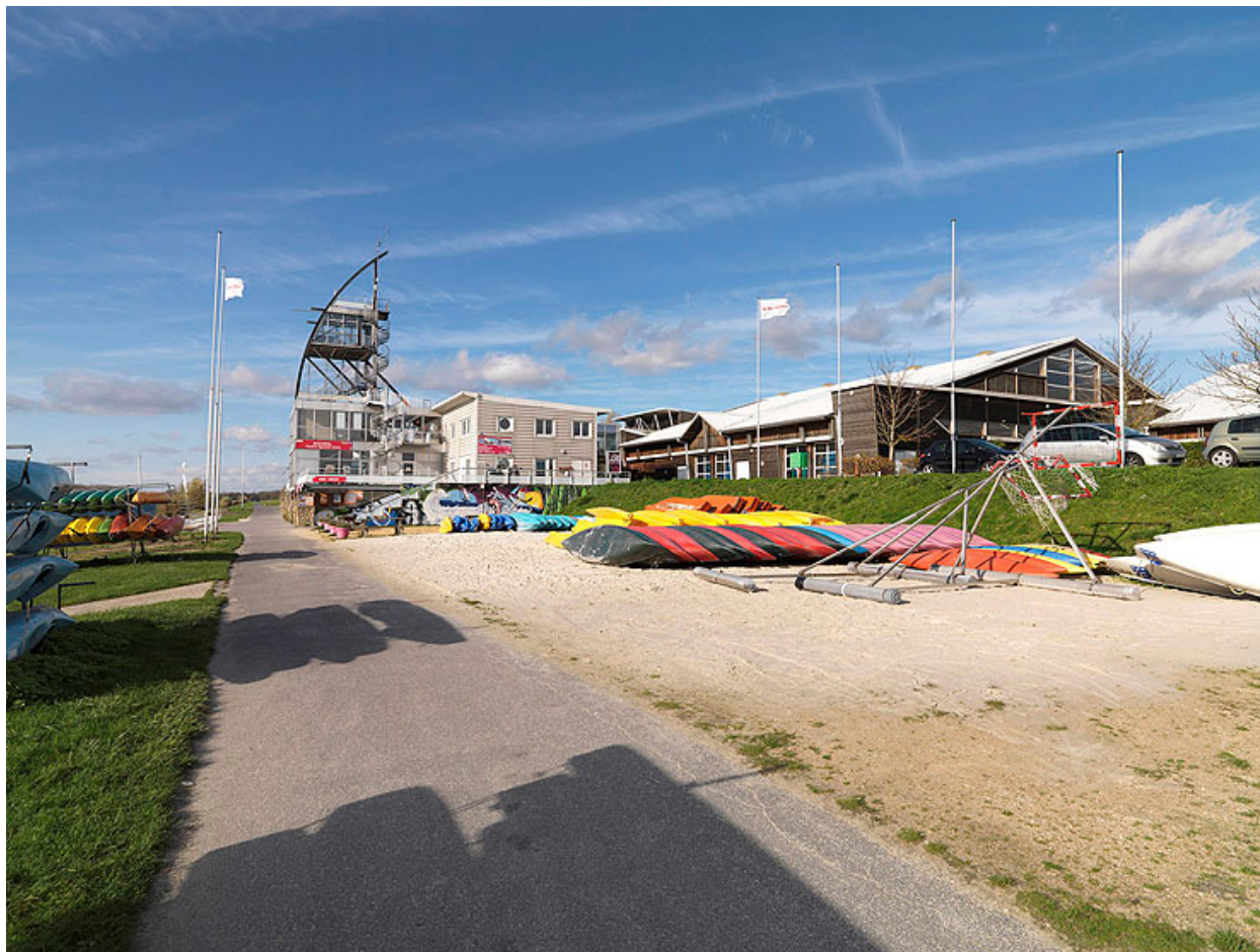
Les bâtiments au nord du lac de Vaires, vus depuis l'est : les gymnases et le bâtiment de l'UCPA, avec la tour d'arrivée pour les compétitions d'aviron.
