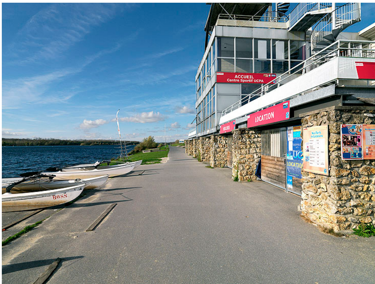
Le soubassement du bâtiment de l'UCPA.
