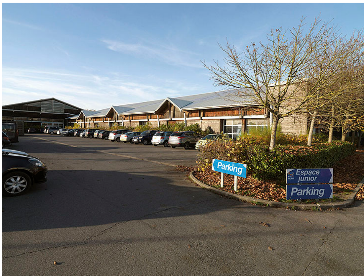
Les gymnases, vus du sud-est.
