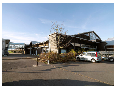
Le gymnase ouest. Au fond, la passerelle d'accès au bâtiment de l'UCPA. Phot. Jean-Bernard Vialles IVR11_20157700223NUC4A
