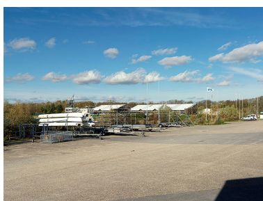
La tour d'arrivée et les gymnases vus du sud-est, depuis le parking du garage à bateaux. Phot. Jean-Bernard Vialles IVR11_20157700224NUC4A
