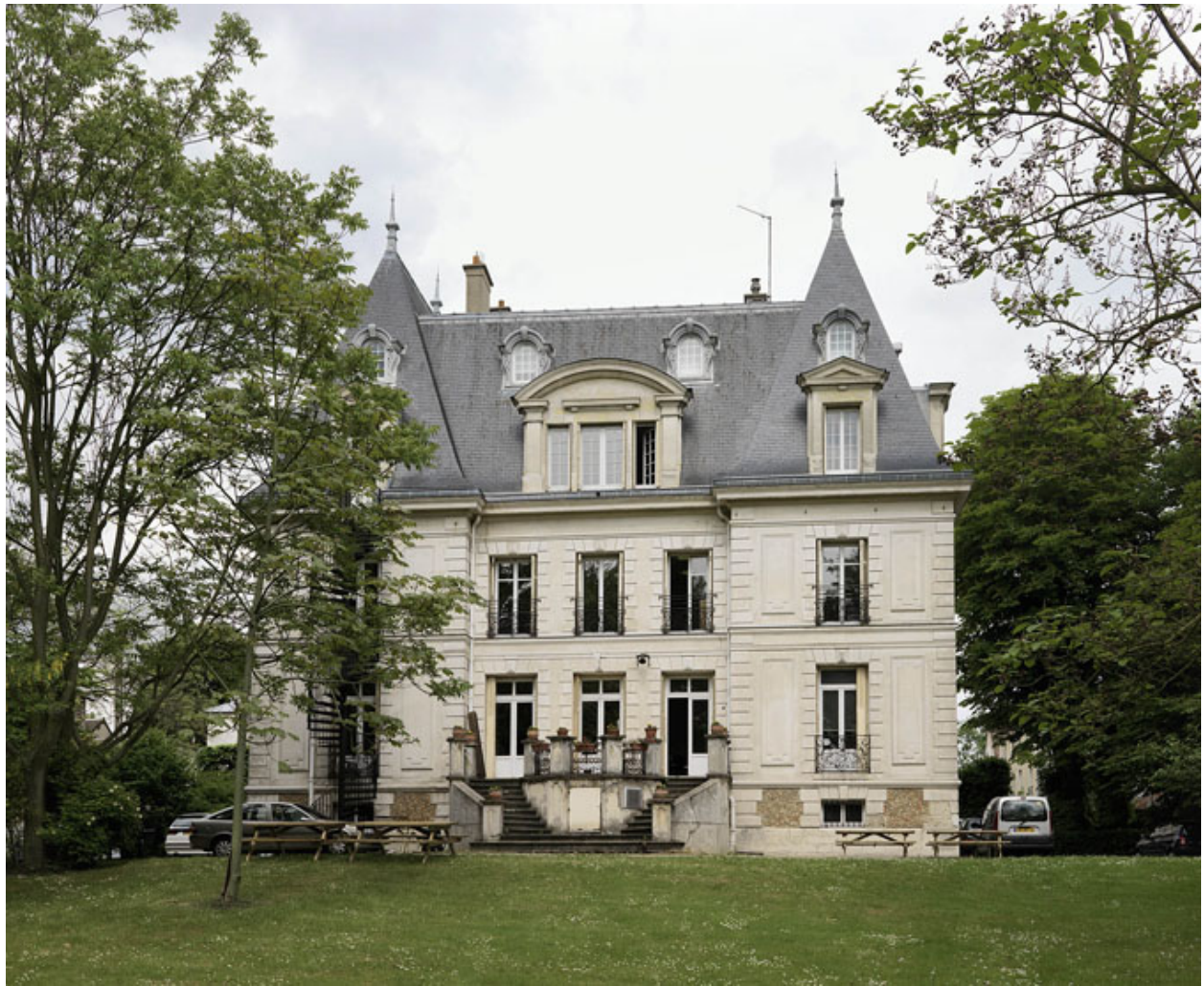
Vue d'ensemble de la façade sur jardin.
