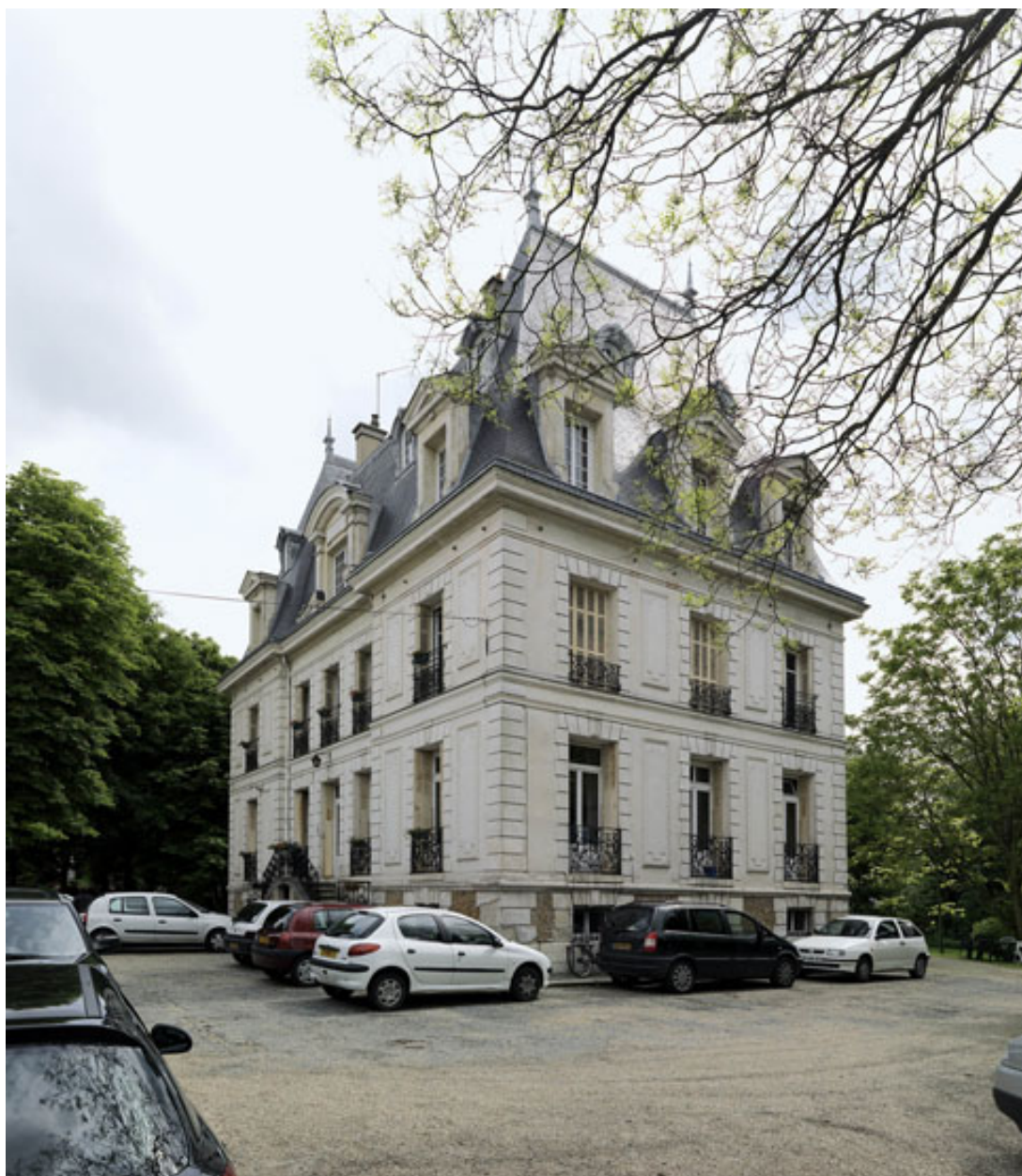
Vue en perspective des façades antérieure et latérale.
