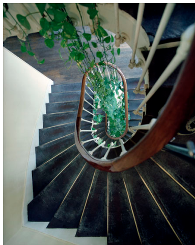
Vue du jour central de l'escalier. Phot. Jean-Bernard Vialles IVR11_20069500197XE
