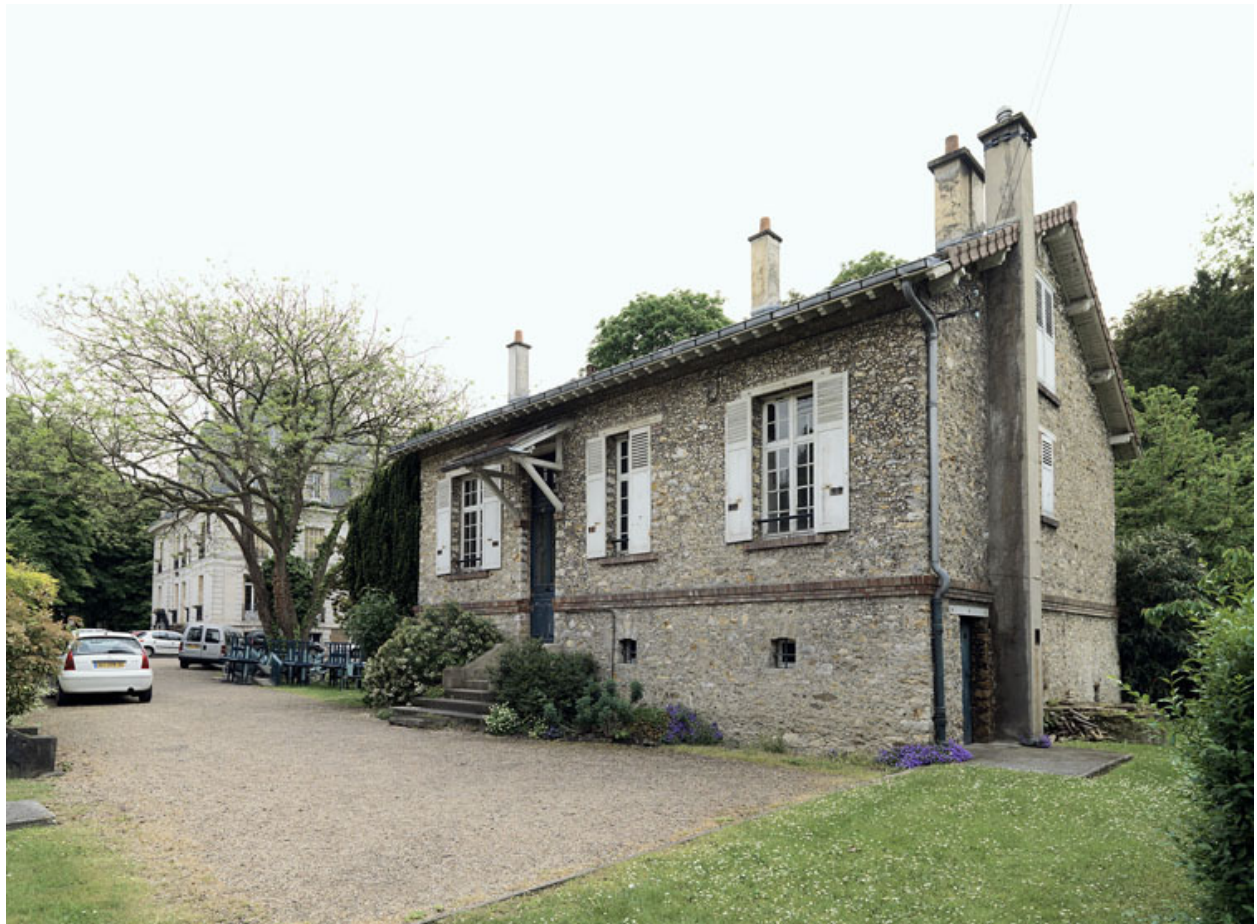
Vue des communs situés vers l'ancien jardin potager et verger : la maison du jardinier et remises.
