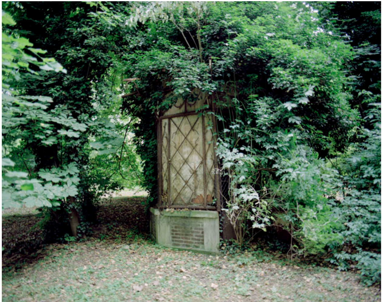
Jardin : détail du kiosque. L'élévation, sur petit mur bahut de brique est en métal imitant des branches d'arbre écotées.
