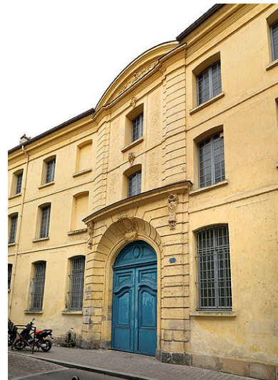
La façade de la rue Saint-Remy : la travée du portail oriental. Phot. Jean-Bernard Vialles IVR11_20127700830NUC4A
