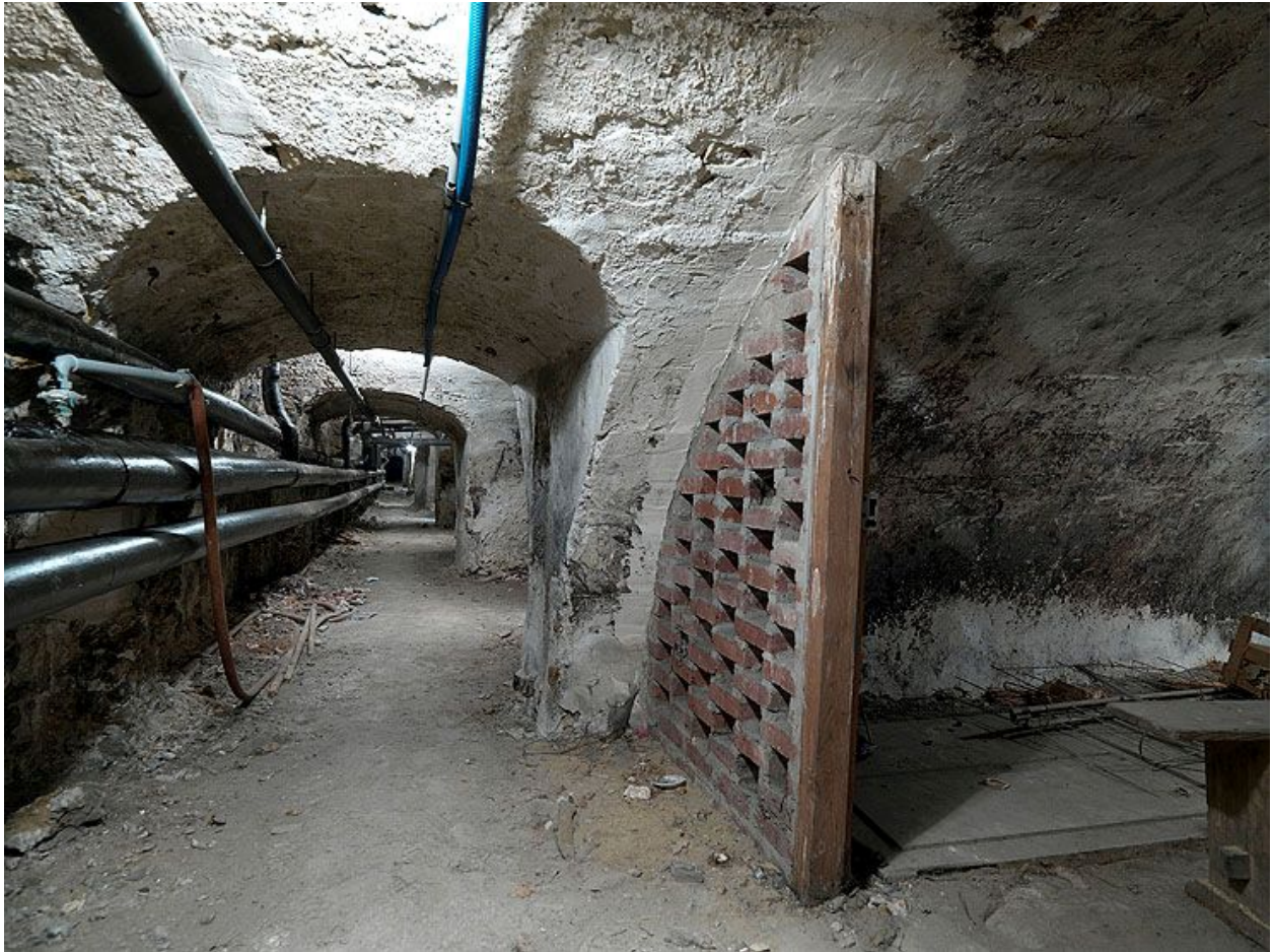
Aile sud de l'ancien séminaire : vue d'ensemble des caves, depuis l'ouest.
