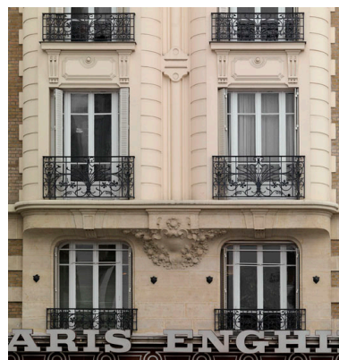
Détail des deux travées d'angle. Phot. Jean-Bernard Vialles IVR11_20099500629NUC4A
