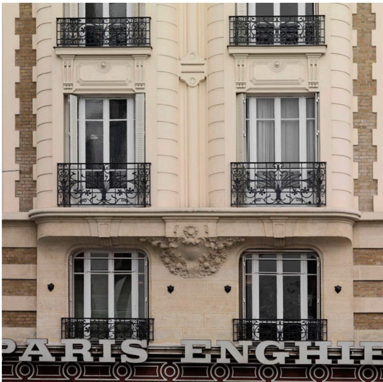
Détail des deux travées d'angle au niveau des premier et second étages.
