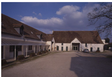
Les bâtiments agricoles disposés en équerre sur deux côtés de la cour. Phot. Philippe Ayrault IVR11_20089100502XA
