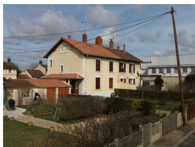
Les maisons de la cité Braustein sont accolées deux à deux. Elles ont un jardin à l'arrière. Phot. Philippe Ayrault IVR11_20127800126NUC4A
