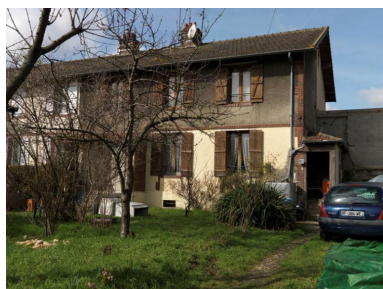
La cité Braustein : façade arrière d'une maison. Phot. Philippe Ayrault IVR11_20127800130NUC4A
