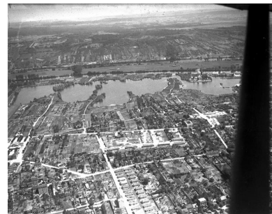
Vue aérienne vers 1950. On aperçoit la cité d'urgence et le lotissement des Castors en construction. (Fonds Bertin). Phot. Bertin IVR11_20177800641NUC2B
