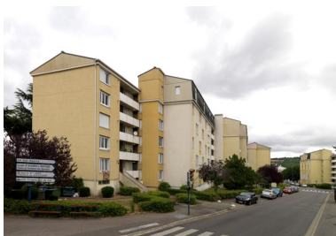
Les immeubles réalisés par Candilis rue de la Croix Ferrée ont été considérablement dénaturés.
