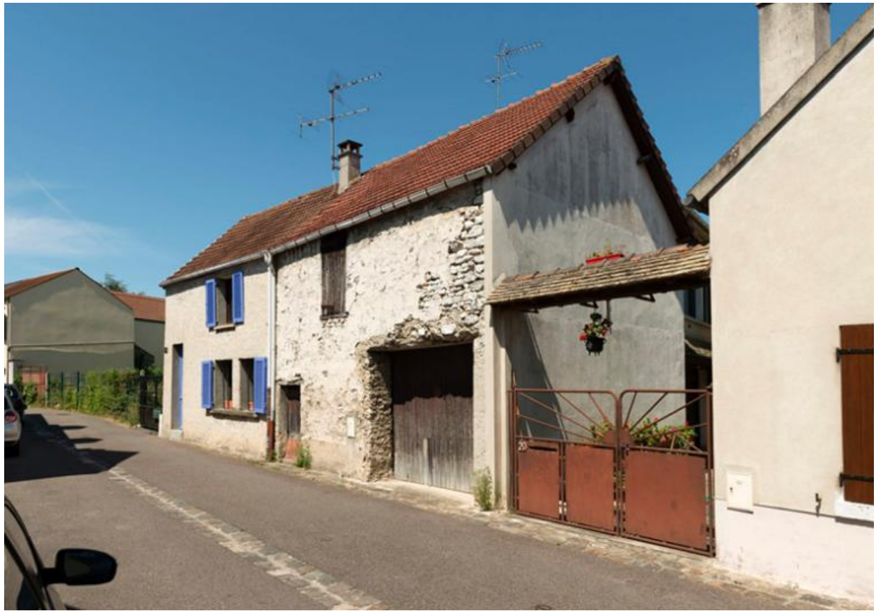
Anciennes maisons rurales rue Marceau.
