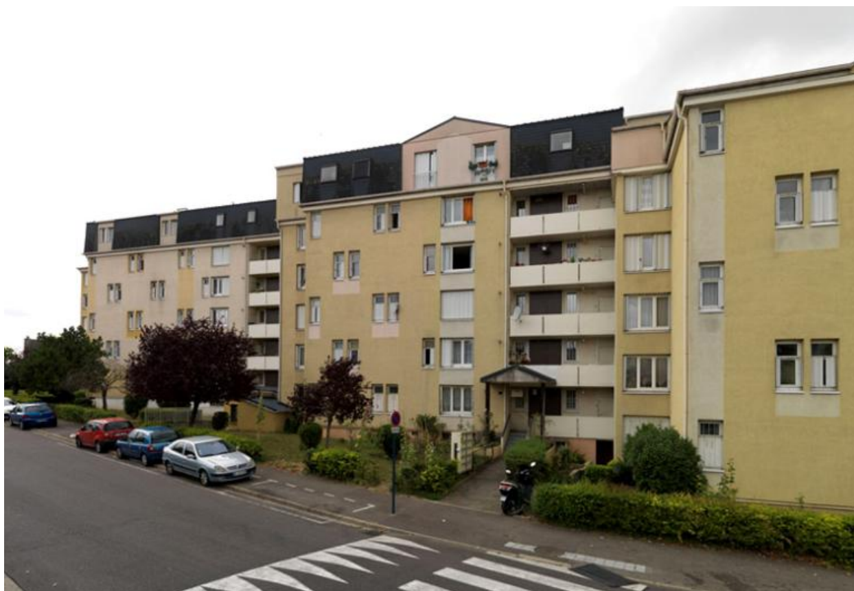
Les immeubles réalisés par Candilis rue de la Croix Ferrée et leur toit façon "Mansart" rajouté lors des rénovations.
