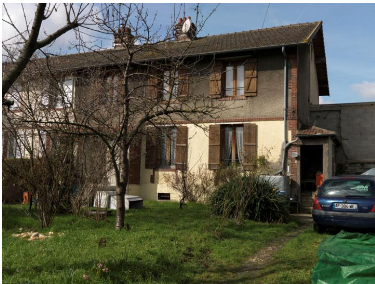
La cité Braustein : façade arrière d'une maison.
