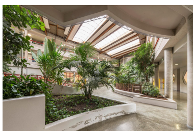
L'atrium et ses lanterneaux. Phot. Laurent Kruszyk IVR11_20199300479NUC4A
