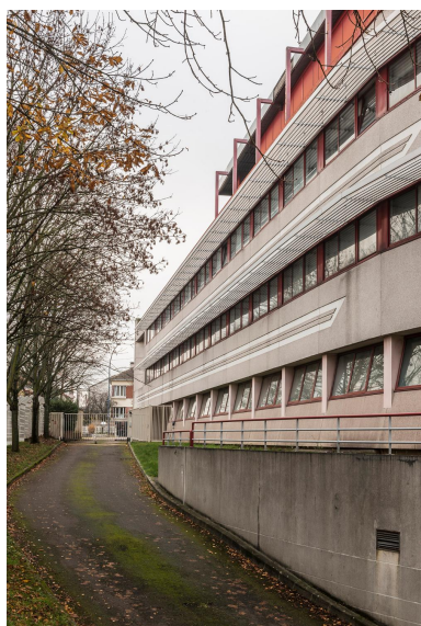
L'unité qui se dégage du lycée provient d'un "linéaire" de façade "formant front à rue", avec des fenêtres-bandeaux filant sur toute la longueur et des menuiseries en aluminium anodisé rouge. Phot. Laurent Kruszyk IVR11_20199300455NUC4A
