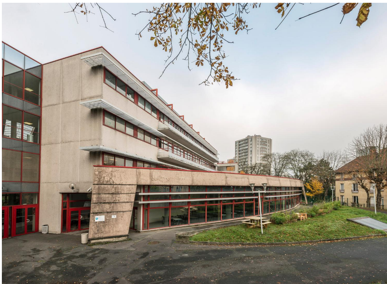
Vue générale sur le réfectoire.
