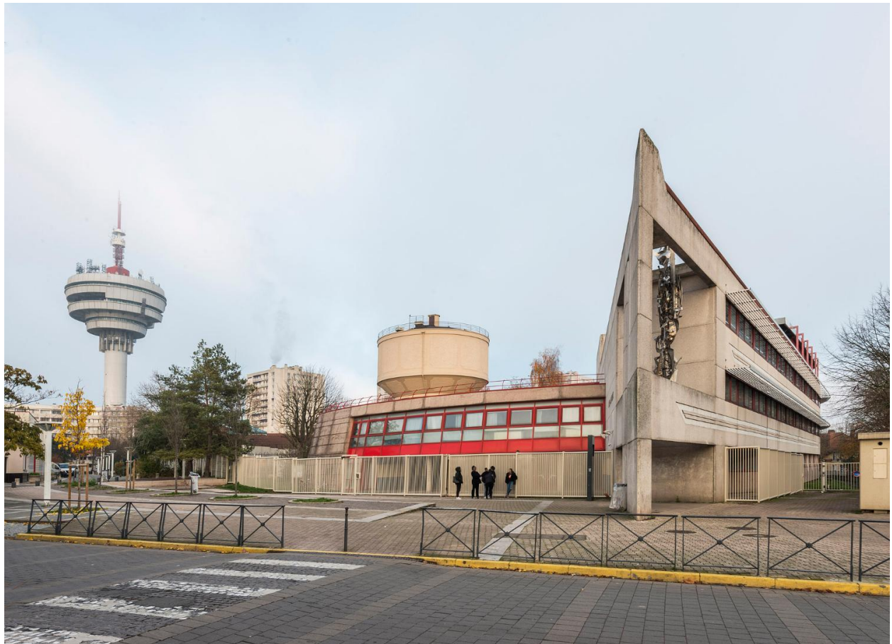
L'entrée du lycée Paul-Robert, avec au fond le château d'eau et à gauche, la tour hertzienne de Romainville.
