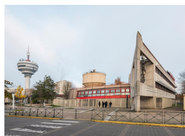
L'entrée du lycée Paul-Robert, avec au fond le château d'eau et à gauche, la tour hertzienne de Romainville. Phot. Laurent Kruszyk IVR11_20199300445NUC4A
