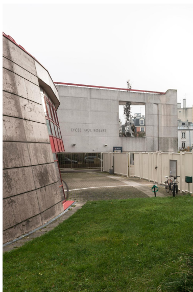
Vue sur l'entrée du lycée, avec la façade traitée en pointe et la sculpture d'Albert Féraud intégrée dans une fenêtre haute. Phot. Laurent Kruszyk IVR11_20199300447NUC4A
