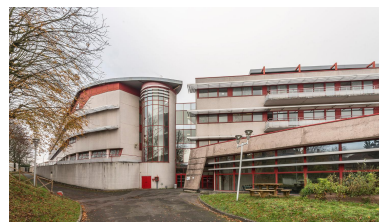
Le lycée, vue d'ensemble depuis le sud. Au premier plan, à droite, le réfectoire. Phot. Laurent Kruszyk IVR11_20199300451NUC4A
