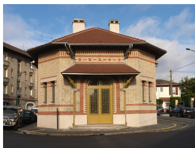
Vue générale du bâtiment, architecte, Georges Vaudoyer Phot. Stéphane Asseline IVR11_20189300003NUC4A
