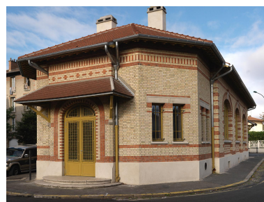
Vue générale du bâtiment, architecte Georges Vaudoyer Phot. Stéphane Asseline IVR11_20189300002NUC4A
