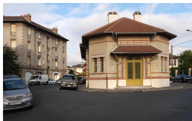
Vue générale du bâtiment, architecte Georges Vaudoyer Phot. Stéphane Asseline IVR11_20189300001NUC4A
