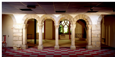
Arcade du cloître : vue d'ensemble, depuis l'est. Phot. Stéphane Asseline IVR11_20037700375VA
