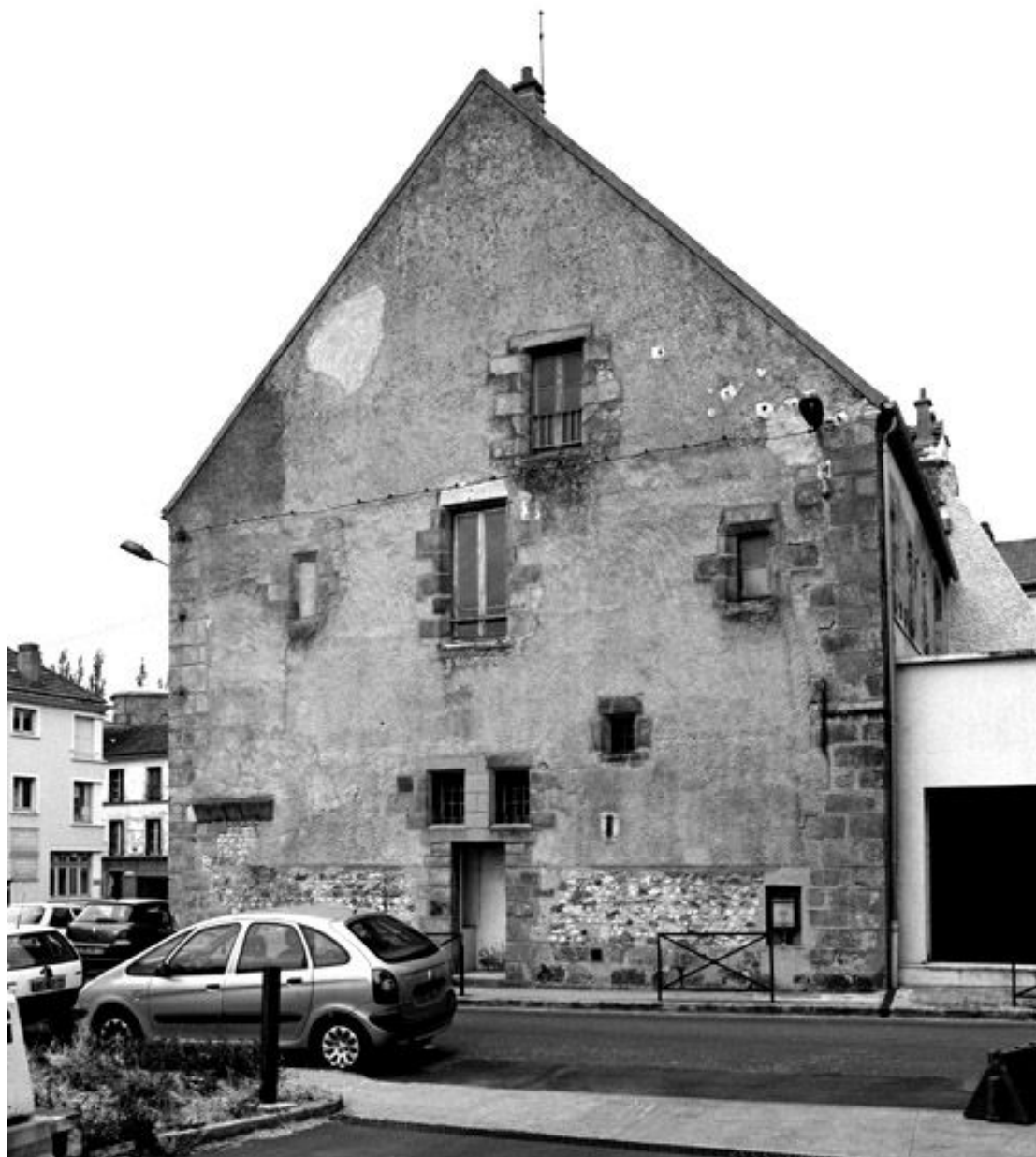
Mur pignon sud de la salle capitulaire.
