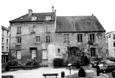
Elévation ouest : vue d'ensemble, depuis le square Jacqueline-Cottard. Phot. Stéphane Asseline IVR11_20037700402X
