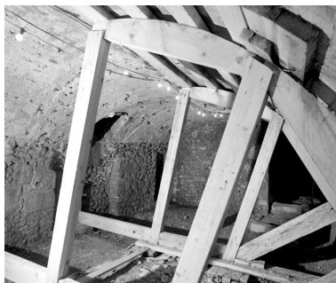
Vue du cellier à l'angle sud-est du prieuré, avec étais de confortement. Phot. Stéphane Asseline IVR11_20037700762X
