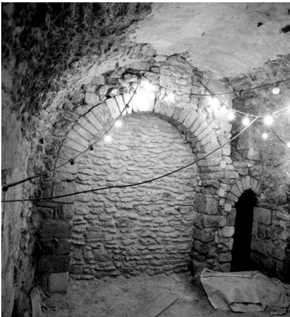
La crypte : élévation est de la salle sud. Sur la droite, l'accès au puits.
