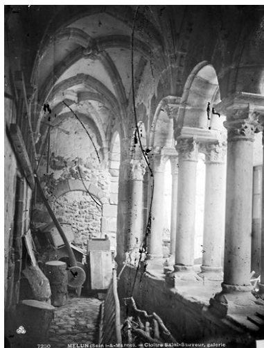
La galerie du cloître : vue intérieure. Photographie. (Médiathèque de l'architecture et du patrimoine, archives photographiques. MH 00007230) Phot. Archives photographiques (reproduction), Autr. Durand (photographe) IVR11_20027700470NUC
