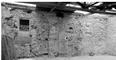
Grandes arcades de la nef, actuellement englobées dans le mur sud du hangar au n°3, rue du Château : vue prise du nord-est. Phot. Stéphane Asseline IVR11_20037700765X
