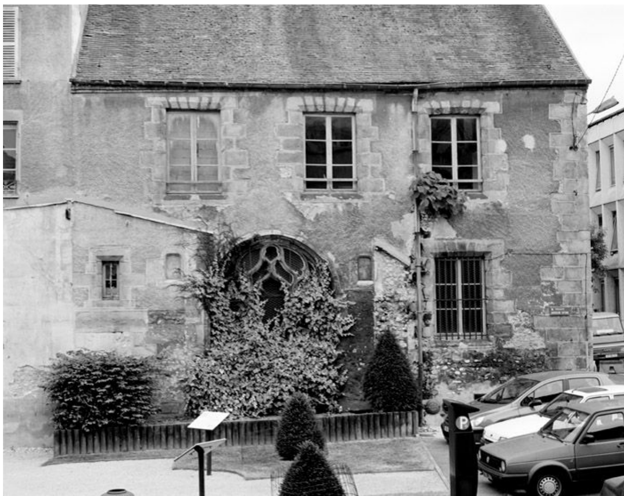
Elévation ouest de la salle capitulaire.
