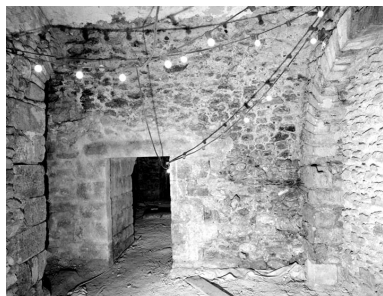
La crypte : élévation nord de la salle sud, avec l'accès à la salle centrale. Phot. Stéphane Asseline IVR11_20037700761X
