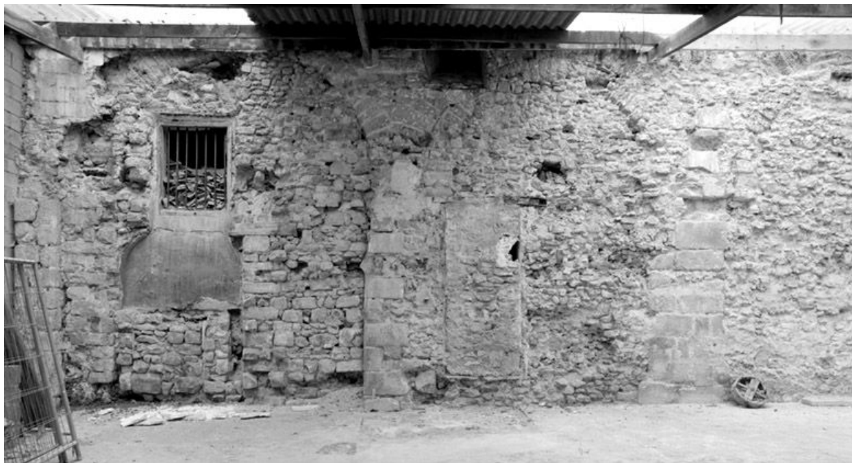
Grandes arcades de la nef, actuellement englobées dans le mur sud du hangar au n°3, rue du Château.
