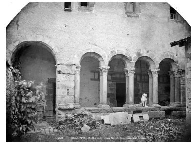
Vue de la galerie du cloître. Photographie. (Médiathèque de l'architecture et du patrimoine, archives photographiques. MH 00007229) Phot. Archives photographiques (reproduction), Autr. Durand (photographe) IVR11_20027700469NUC
