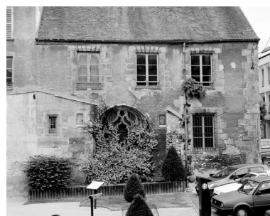
Elévation ouest de la salle capitulaire. Phot. Stéphane Asseline IVR11_20037700403X
