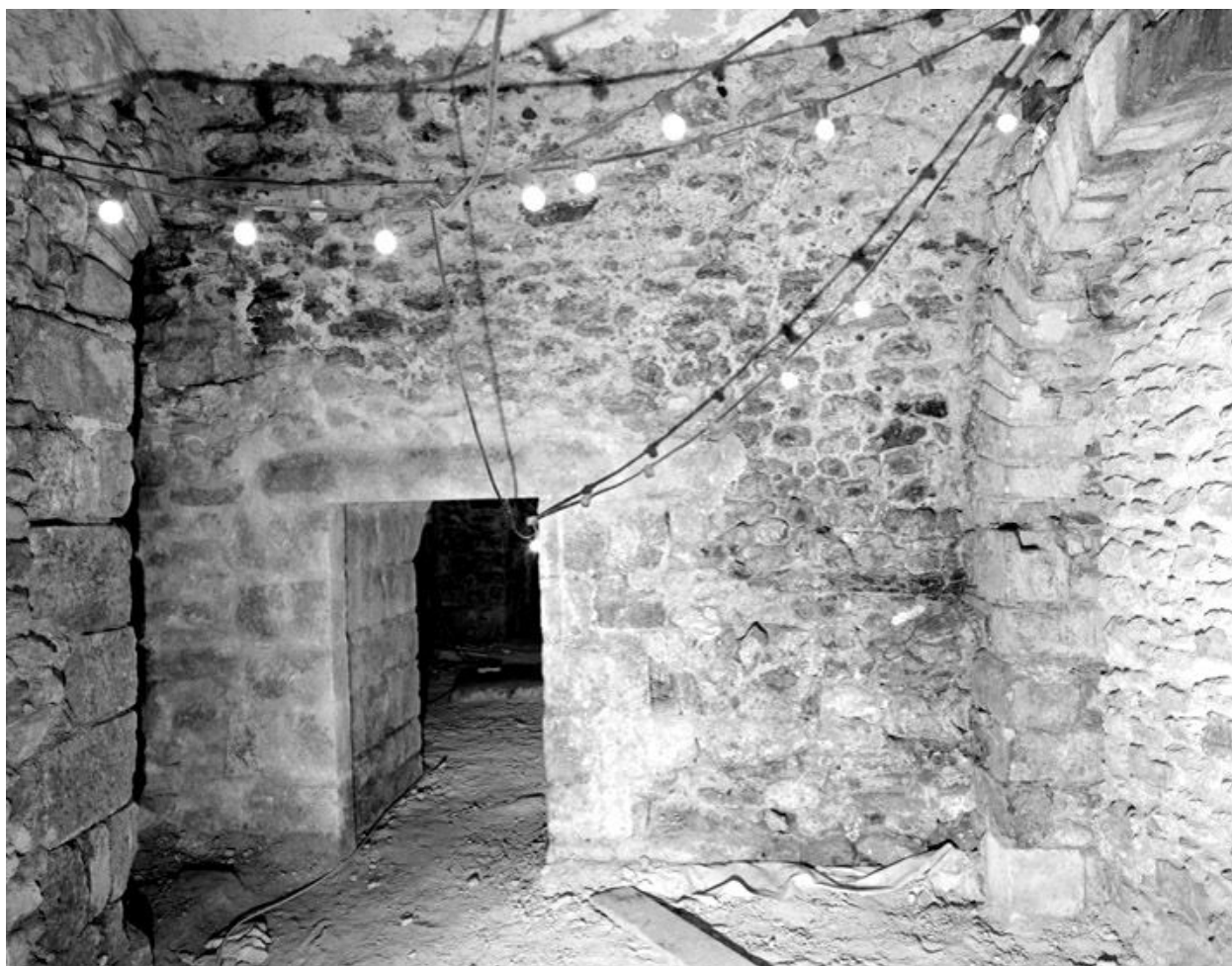
La crypte : élévation nord de la salle sud, avec l'accès à la salle centrale.
