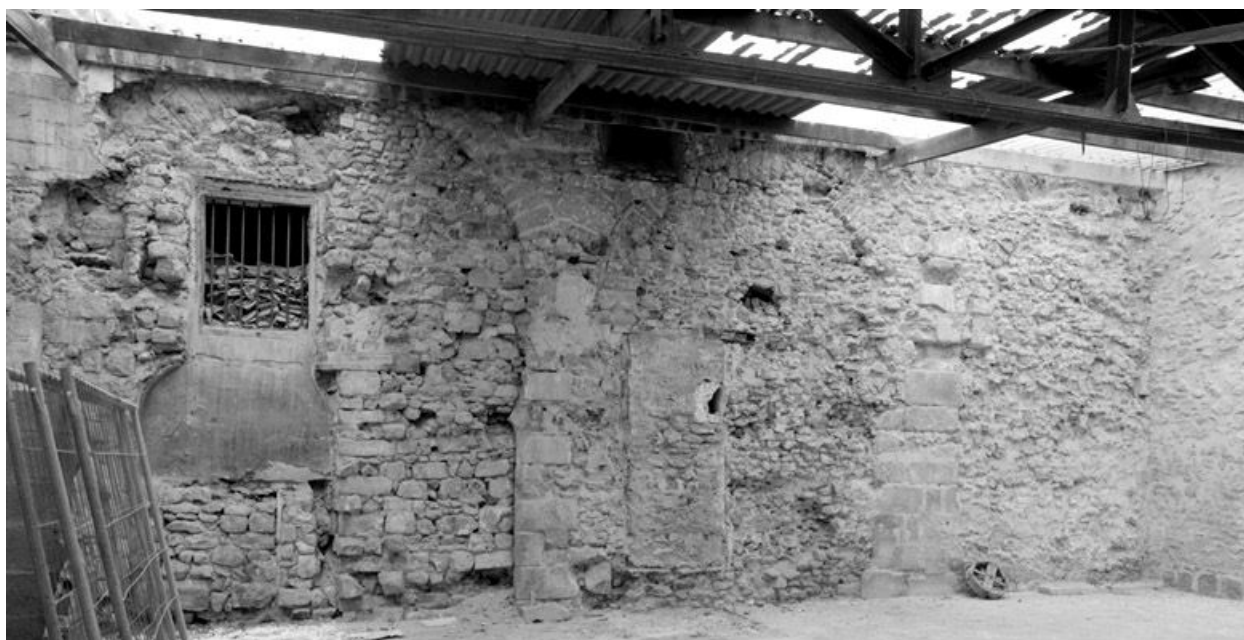
Grandes arcades de la nef, actuellement englobées dans le mur sud du hangar au n°3, rue du Château : vue prise du nord-est.
