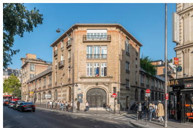
Vue générale du lycée et de son entrée. Phot. Laurent Kruszyk IVR11_20207501015NUC4A
