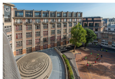
Vue générale de la cour intérieure, en surplomb de la salle polyvalente semi-enterrée, qui combine les fonctions de réfectoire, salle des fêtes et même salle de gymnastique. Phot. Laurent Kruszyk IVR11_20207501020NUC4A
