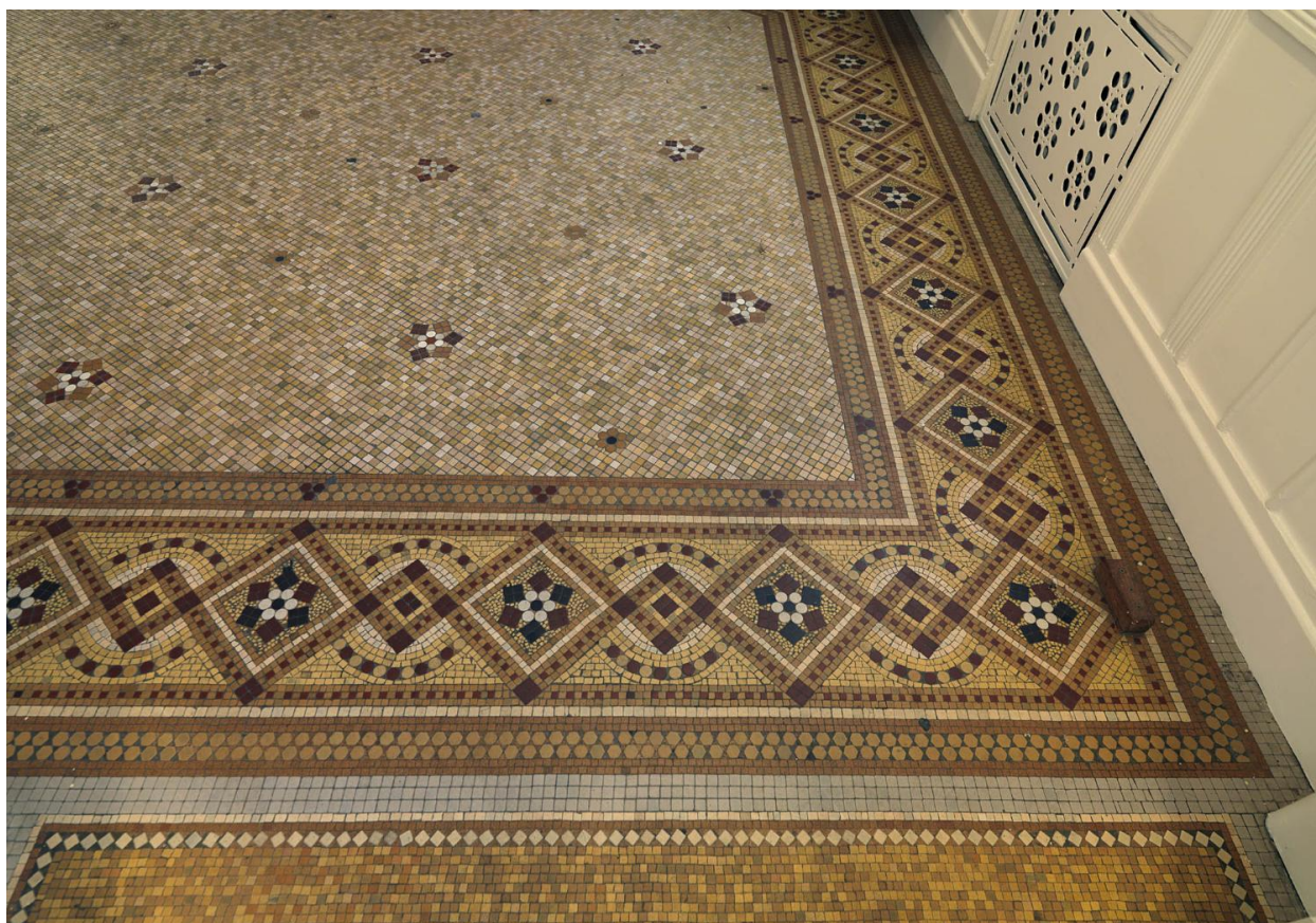
Détail du sol du hall du lycée.
