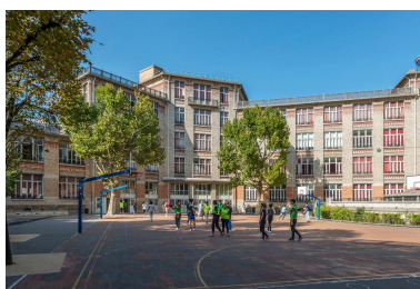
Pour la structure du lycée, l'architecte Pierre Paquet choisit de mettre en œuvre le système Cottancin aux dépens de la maison Hennebique. Brique et mosaïque animent les élévations. Phot. Laurent Kruszyk IVR11_20207501019NUC4A
