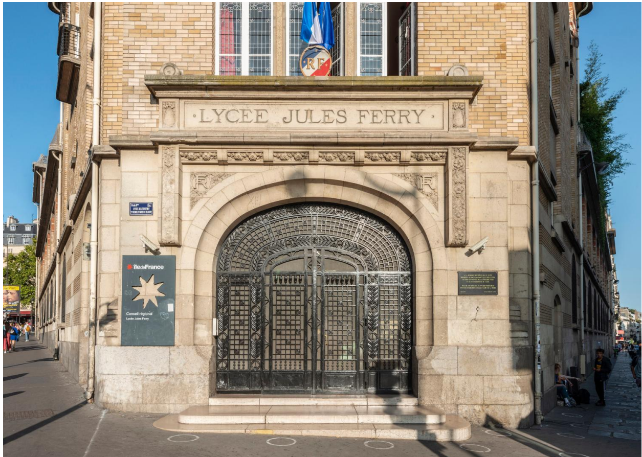
Détail de l'entrée du lycée, avec le monumental portail en anse de panier conçu par le ferronnier Emile Robert.
