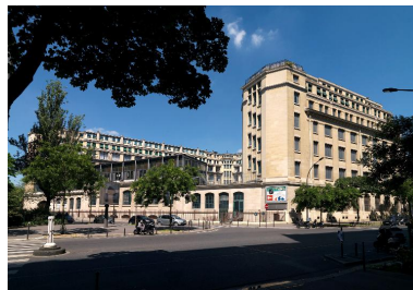
Façade sur la rue Meryon. Phot. Jean-Bernard Vialles IVR11_20167500336NUC4S
