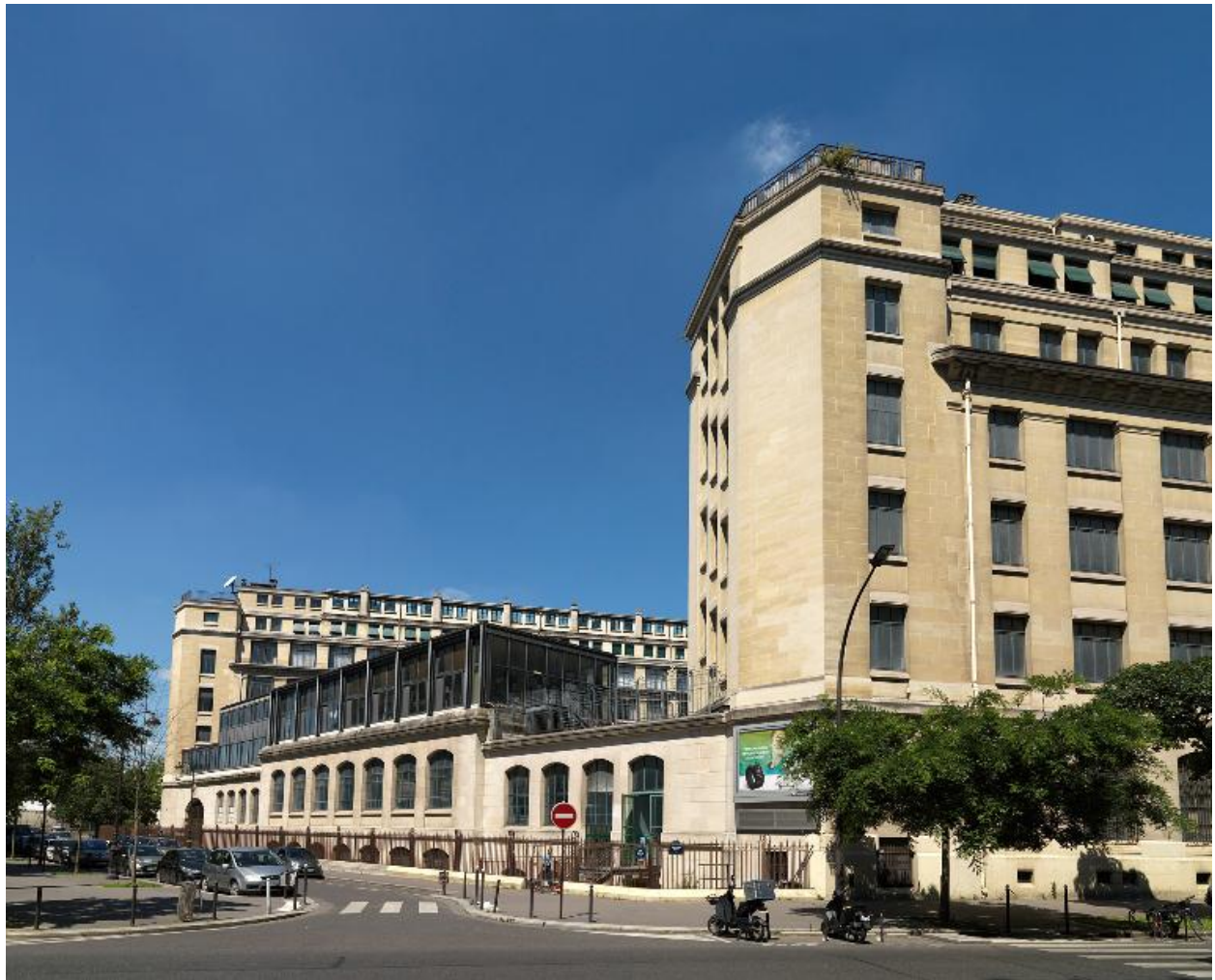
La surélévation du centre de documentation.
