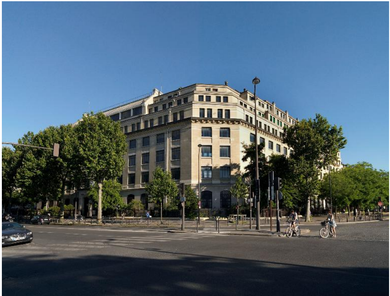
Vue générale du lycée.
