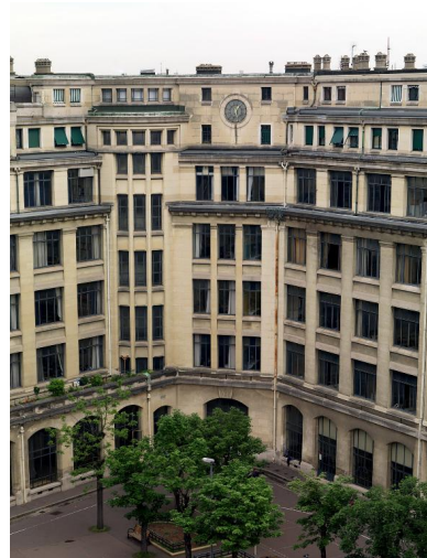
Le fronton du bâtiment B et son horloge. IVR11_20167500352NUC4S
