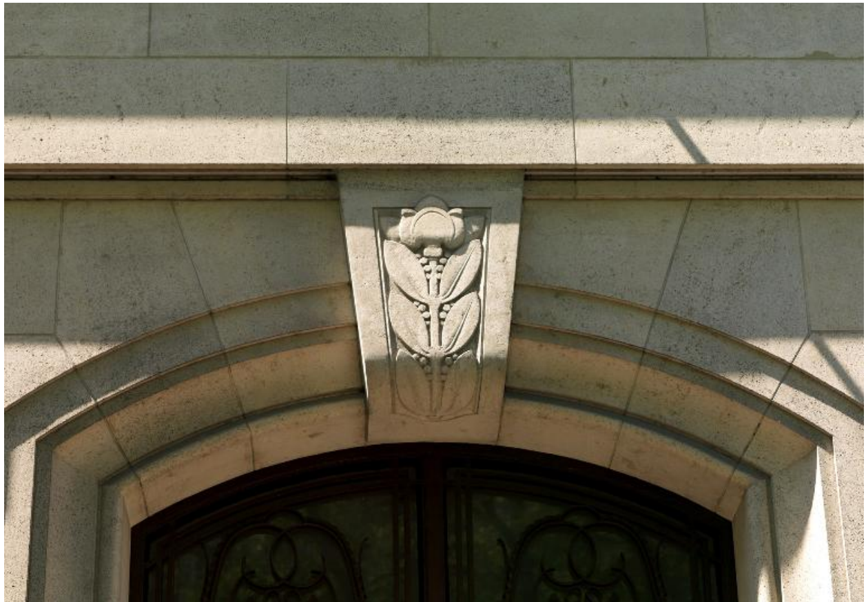
Détail de la clé au-dessus de la porte.
