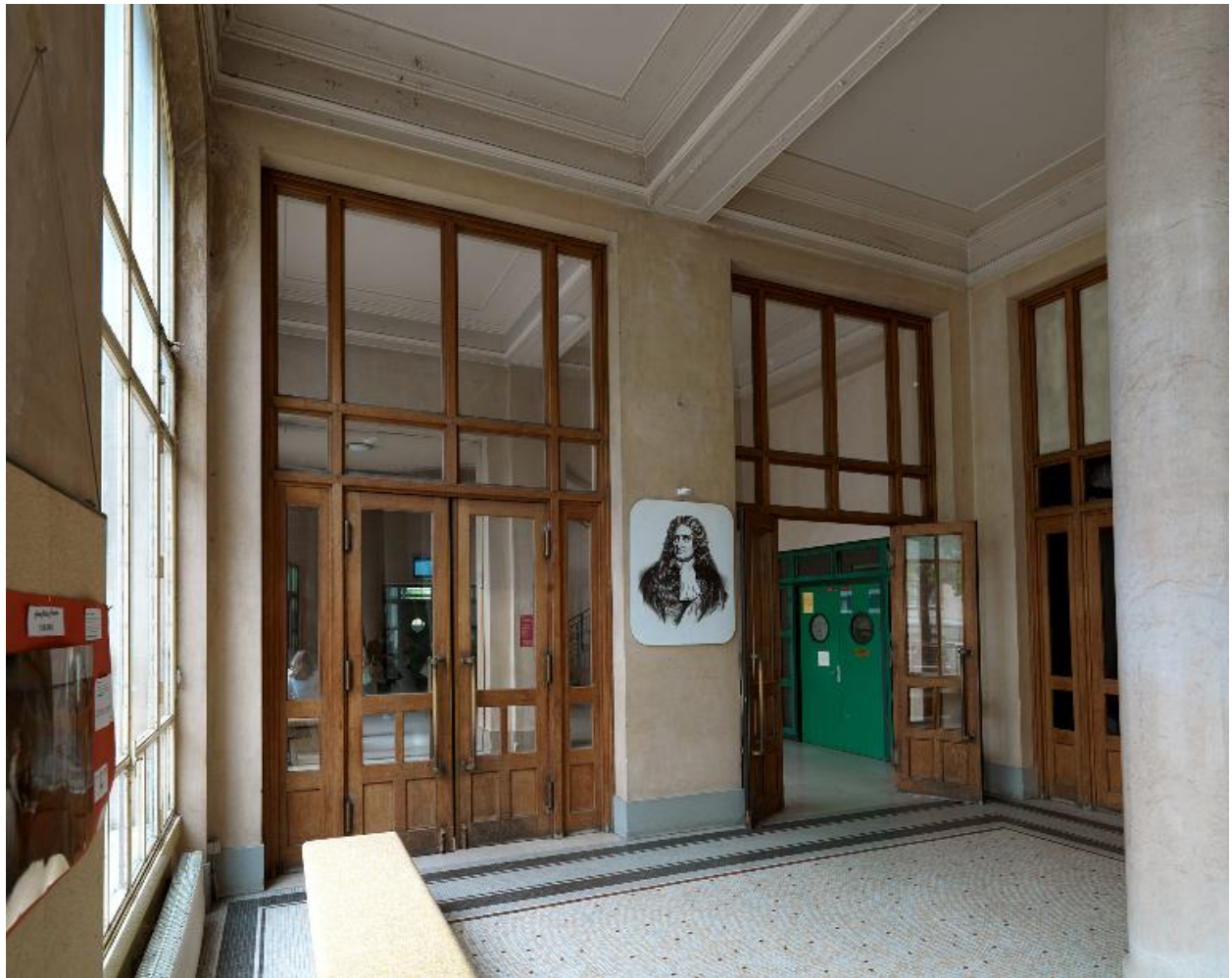
Vue des portes du hall.
