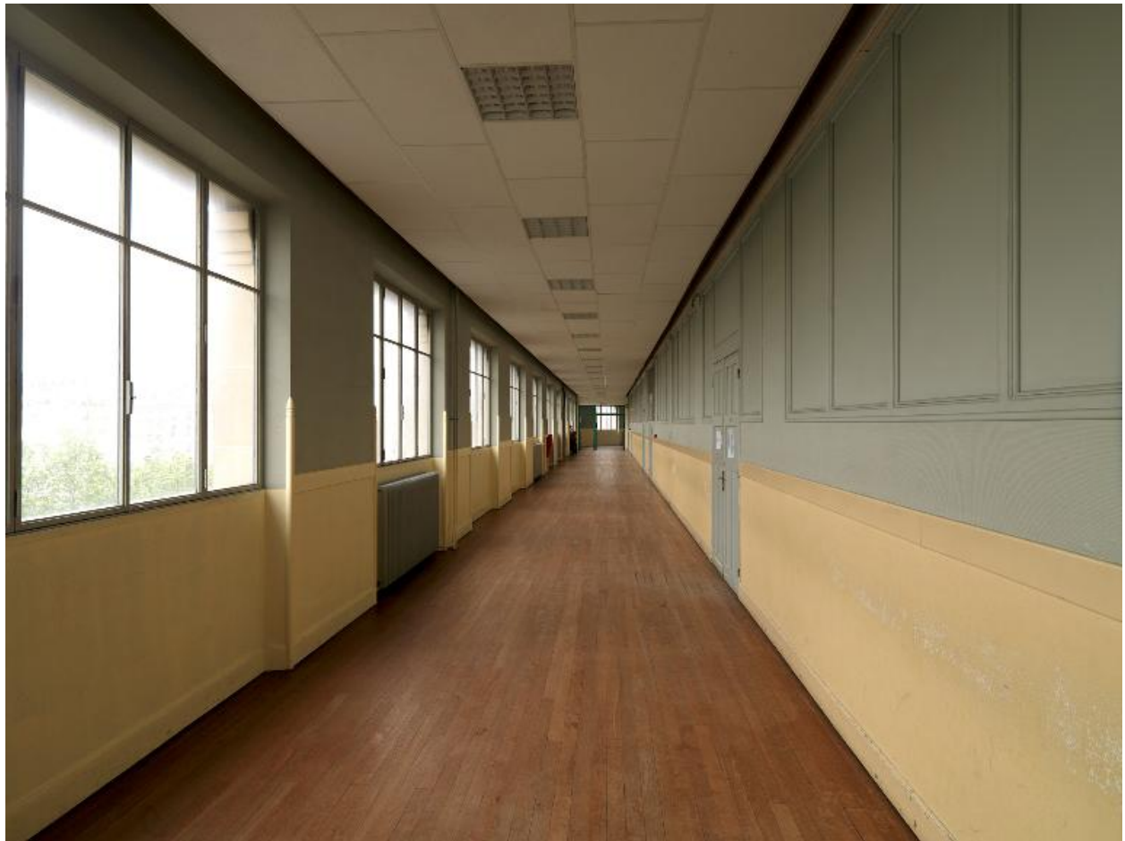
Vue d'un couloir de circulation.
