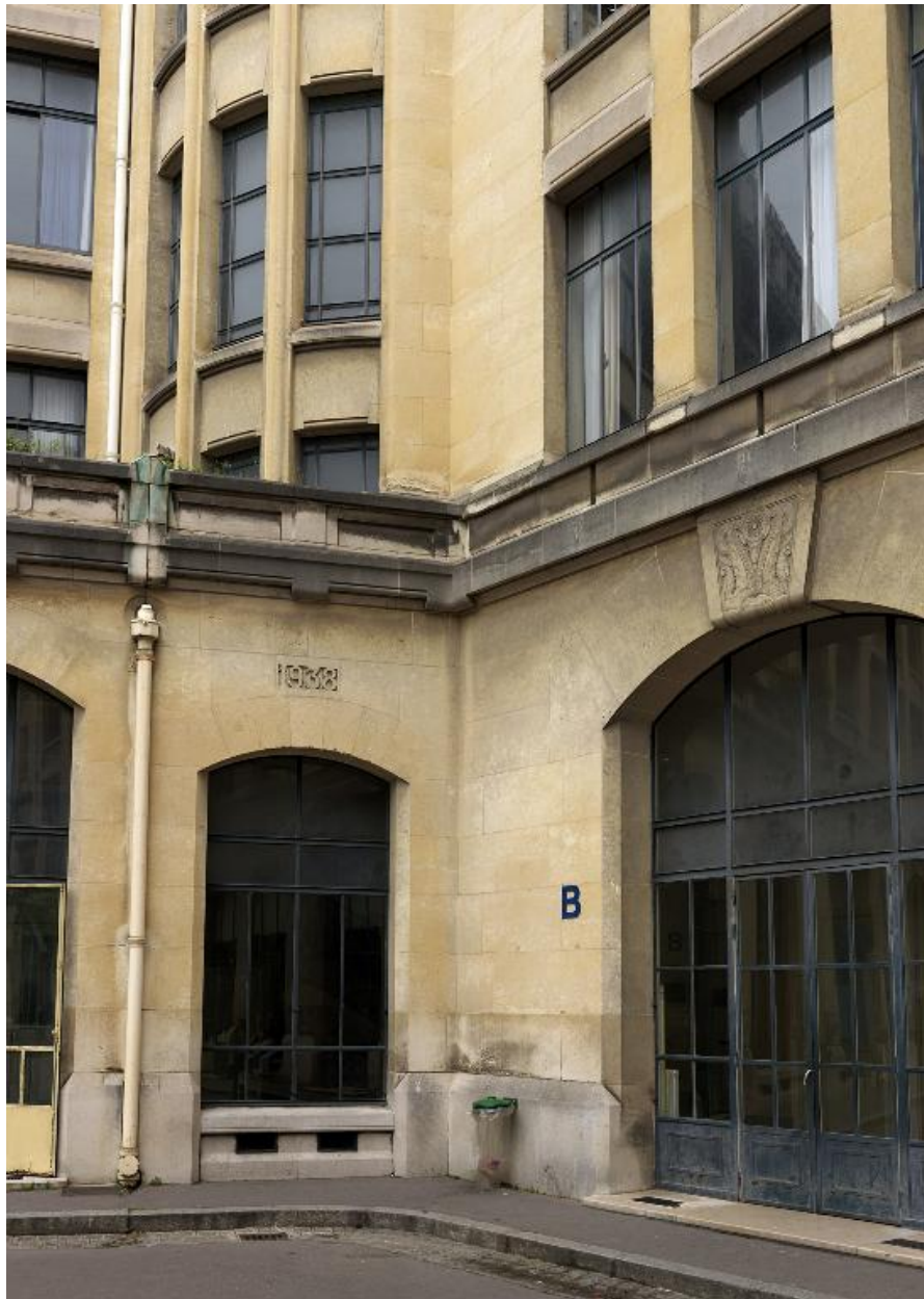
La façade ouest, datée de 1938.
