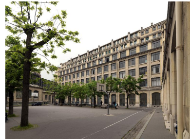
La façade ouest sur cour. Phot. Jean-Bernard Vialles IVR11_20167500346NUC4S
