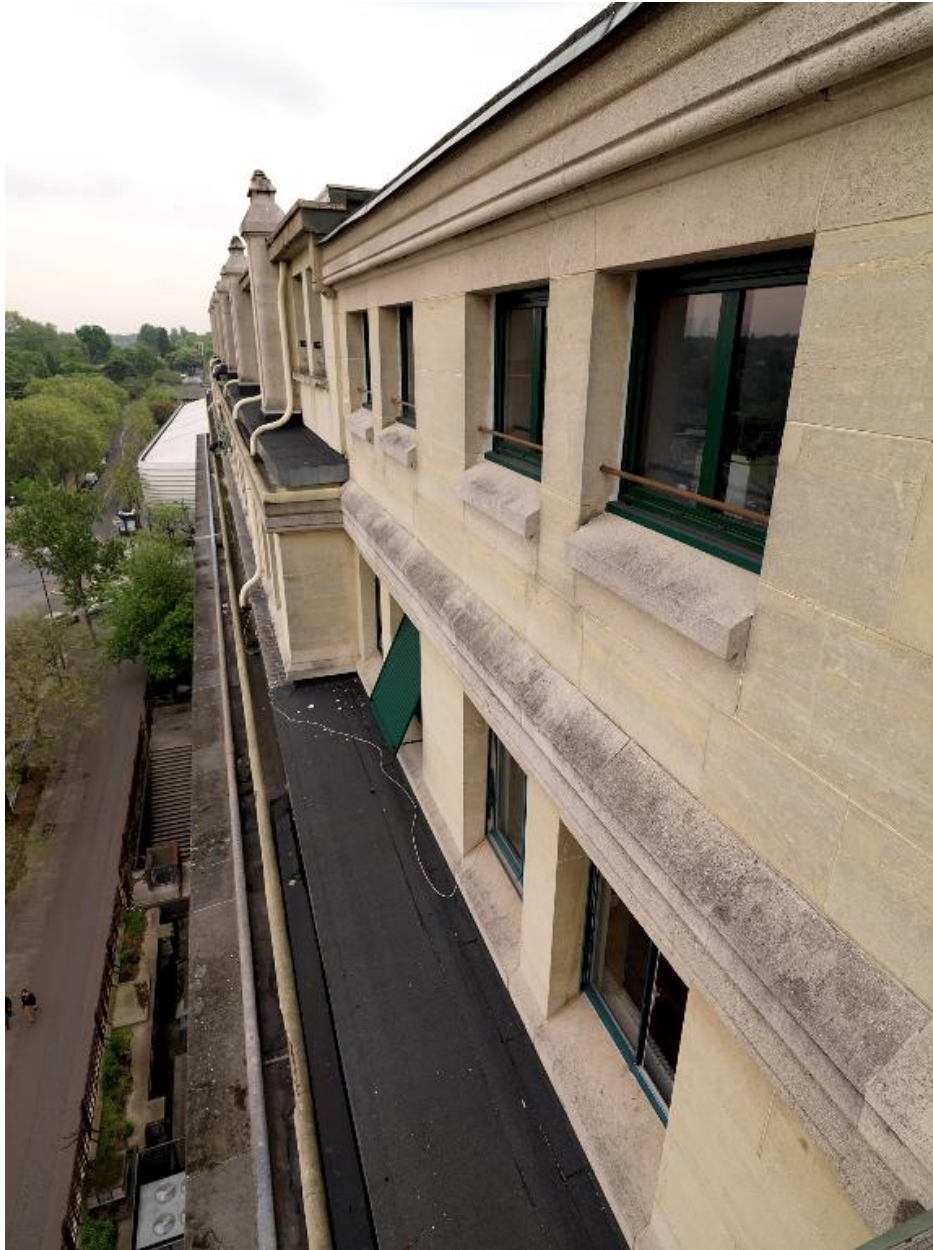
Détail de la façade donnant sur l'avenue du Général Sarraill.
