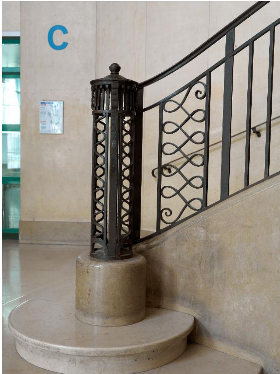
Le départ de rampe ouvragé.
