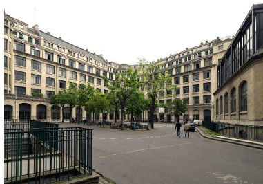
La façade principale sur cour. Phot. Jean-Bernard Vialles IVR11_20167500344NUC4S
