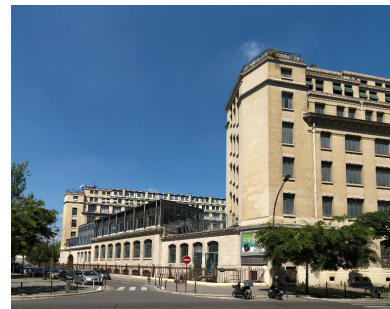
La surélévation du centre de documentation. Phot. Jean-Bernard Vialles IVR11_20167500337NUC4S
